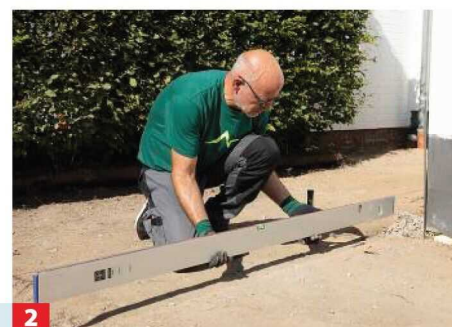
Teilweise sind die Dielen auf der Fläche abgesackt.
