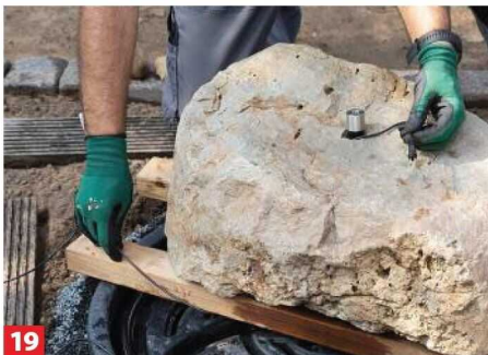
16 Markieren Sie dann, wo der Schlauch durchtrennt wird, um das Stromkabel der Quellsteinbeleuchtung herauszuführen.
