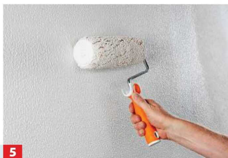
5 Den Rollputz wie Farbe aufrollen, zusammenhängende Flächen an einem Stück streichen.
