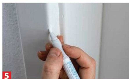
5 ... Glanzgrad anpassen. Dann den Lackstift schütteln und die Oberfläche versiegeln.
