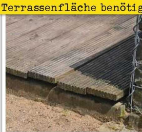
Teilweise sind die Dielen auf der Fläche abgesackt.
