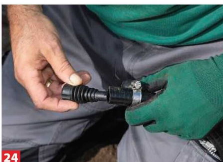
21 Nun wird der Schlauchverbinder auf das Schlauchende gesteckt.
