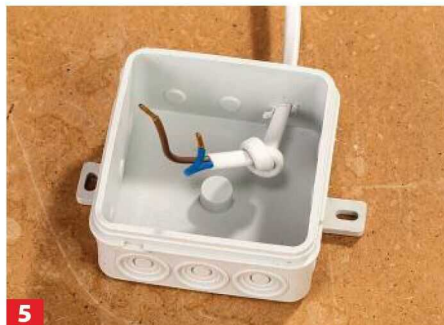
5 Mit einem Knoten sichern Sie die Leitung gegen versehentliches Herausziehen – das spart eine Zugentlastung.
