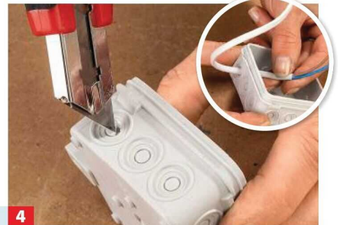
4 Durchführung in das Gehäuse schneiden und Zuleitung einfädeln.
