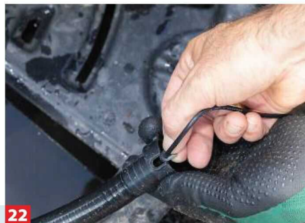
22 Das Stromkabel der Quellsteinbeleuchtung kann dank des Netzkabelaustritts an einer Seite des Verbinders inklusive Dichtung ...
