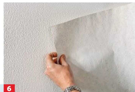
6 Trockenzeit: ca. 12 Stunden. Im Vergleich zur Raufaser ist der Putz stärker strukturiert.
