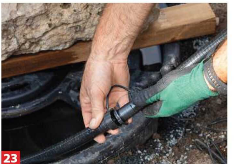
23 ... herausgeführt werden. Befestigen Sie das Gegenstück am Verbinders samt Schlauch.
