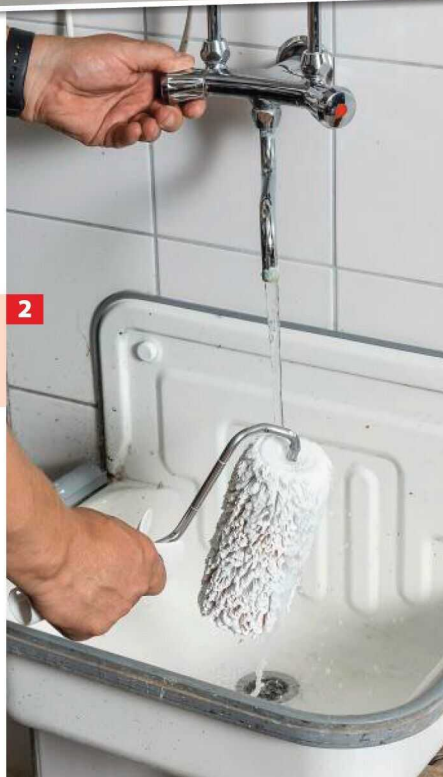
2 Nur bei mehrtägigen Arbeitspausen etwas Wasser über die Rolle laufen lassen.
