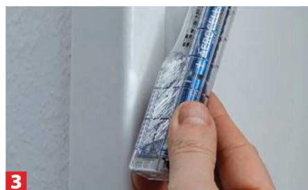
3 Die aufgebaute Wachsschicht nun mit dem Hobelgriff des Schmelzers bündig abtragen.
