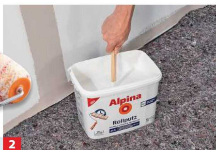
2 Den Rollputz zuerst gut aufrühren; er kann auch bis zu 10 Prozent abgetönt werden.
