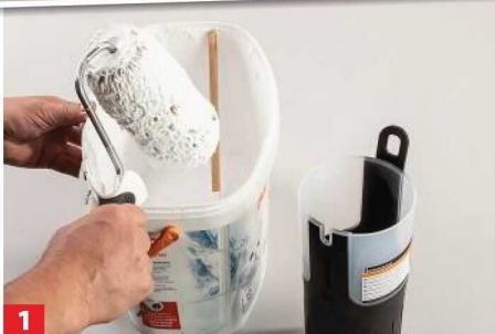
1 Streifen Sie überschüssige Farbe über dem Farbeimer sorgfältig ab.
