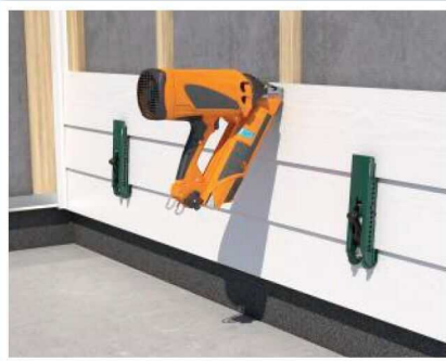
Bei Hardie-Plank hilft die Montagehilfe Gecko Gauge bei der Befestigung.
