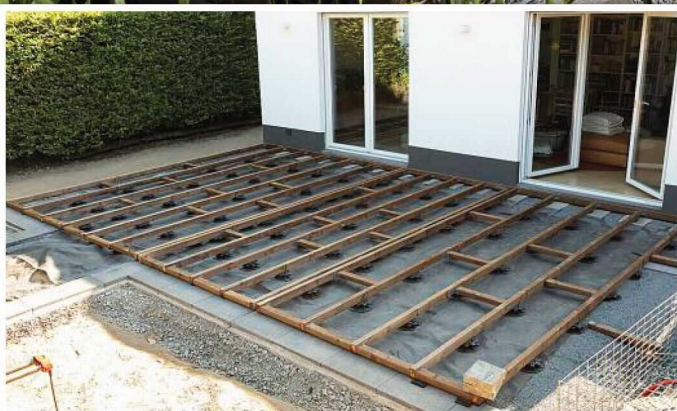
» UNTERKONSTRUKTION Errichten des Terrassenunterbaus ab Seite 12
