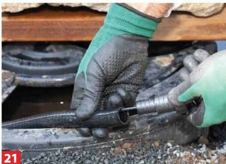
21 Nun wird der Schlauchverbinder auf das Schlauchende gesteckt.
