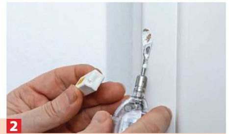
2 Das Wachs im Wunschfarbton wird mit dem Schmelzer verflüssigt und aufgetragen.
