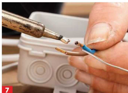
7 Verzinne Sie ebenfalls die Adernenden der Zuleitung, damit diese sich danach problemlos an der Platine ...
