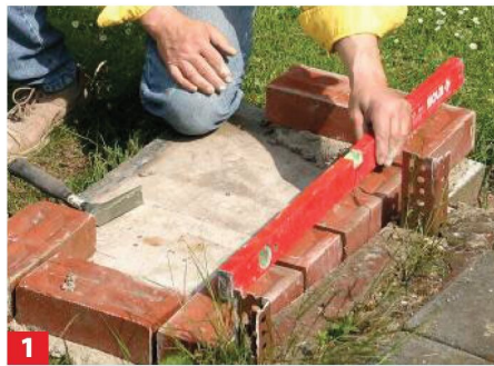
1 Die erste Klinkerschicht absolut waagrecht ins Mörtelbett setzen, da sich die Lage der folgenden Schichten an ihr ausrichtet.
