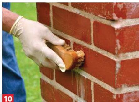
10 Mörtelreste abschließend mit Bürste und Wasser abwaschen, ggf. Zementschleierentferner einsetzen.
