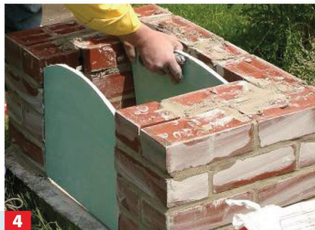
4 ... der Oberfläche abwischen. Schalungen, um Wölbungen zu mauern, kann man mit Gipskartonplatten bauen.
