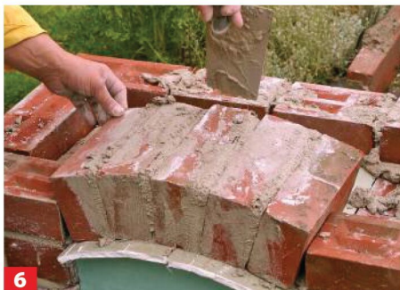
6 Nun können Sie die Klinker darüber V-förmig in Mörtel setzen. Die Fugen vollständig von oben mit Mörtel füllen.
