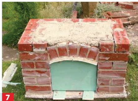
7 Den Raum zwischen Randstein und Gewölbe mit zugehauenen Klinkern möglichst eben ausmauern und die Fläche mit ...
