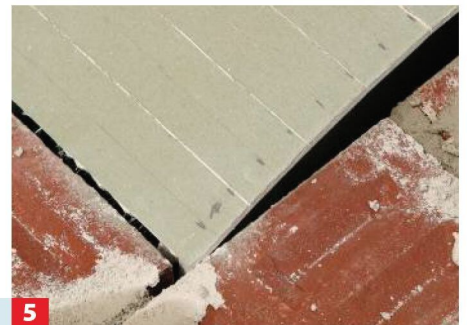
5 Für den Deckel der Schalung schneiden Sie die Gipskartonplatten ein, um sie entsprechend der Wölbung knicken zu können.
