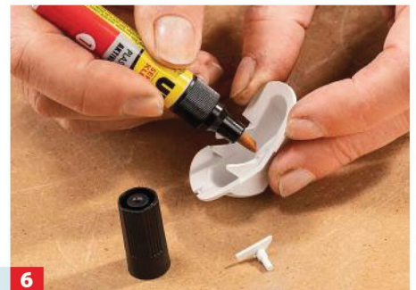
6 Verklebung: Mit einem Aktivator wird die Klebestelle benetzt – nur so wird der Kunststoff klebbar.
