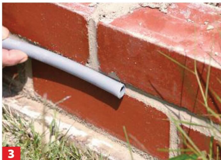
3 Die Fugen z.B. mit einem Schlauchstück so ausformen, dass sich kein Wasser darin sammeln kann. Mörtelschleier direkt von ...
