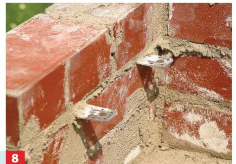
8 ... feuerfestem Mörtel glatt abziehen. Darüber drei weitere Reihen U-förmig aufmauern und mindestens vier Flachverbinder oder ...
