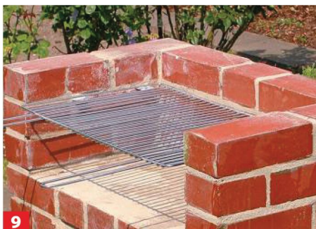
9 ... Auflagebleche in die obere Lagerfuge einbinden. Hat der Mörtel abgebunden, kann man darauf den Grillrost platzieren.
