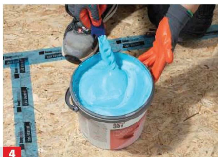
4 Die Flüssigabdichtung muss vor Gebrauch gründlich aufgerührt werden.
