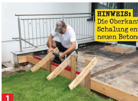
1 Bei der Terrassenverschalung müssen die Bretter nach außen abgestützt werden, damit sie dem Druck des Estrichs standhalten.
