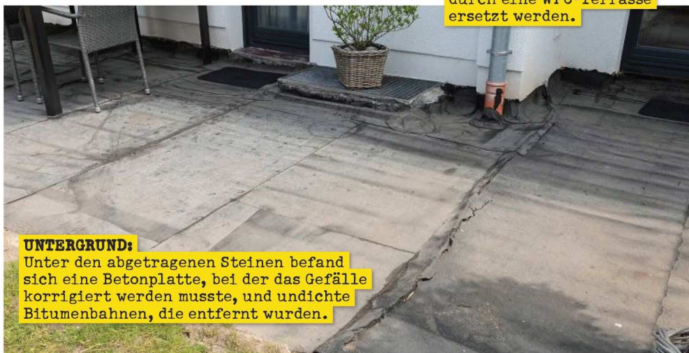
VORHER: Die alte Steinterrasse war in die Jahre gekommen und sollte durch eine WPC-Terrasse ersetzt werden.
