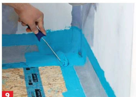
9 Anschließend vor allem die Randzonen und Stöße mit Flüssigabdichtung überarbeiten.
