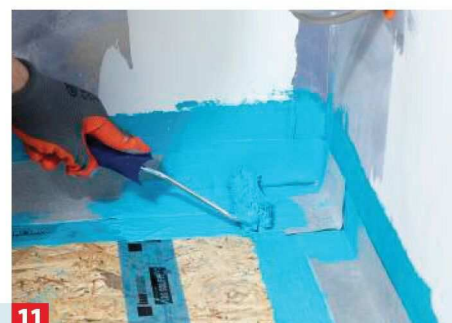
11 Auch diese anschließend mit Flüssigabdichtung überarbeiten.
