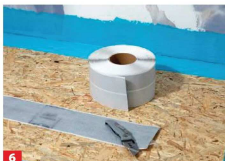
6 Nach dem Durchtrocknen wird in den Übergang zwischen Wand und Boden Dichtungsband eingelegt.
