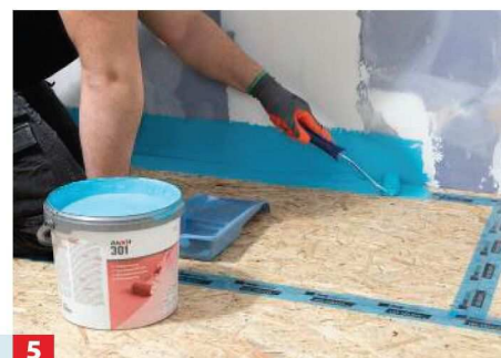
5 Dichten Sie zunächst alle Eckbereiche ab. Dazu als erstes Flüssigabdichtung abschnittsweise auftragen.
