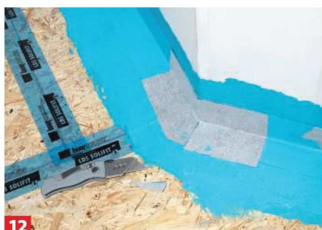
12 Für äußere Eckbereiche gibt es entsprechend selbstklebende Außenecken.
