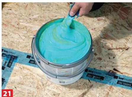
18 Wie gehabt auch die verklebten Dichtmanschetten mit Flüssigabdichtung überarbeiten. Dann alles gut abtrocknen lassen.
