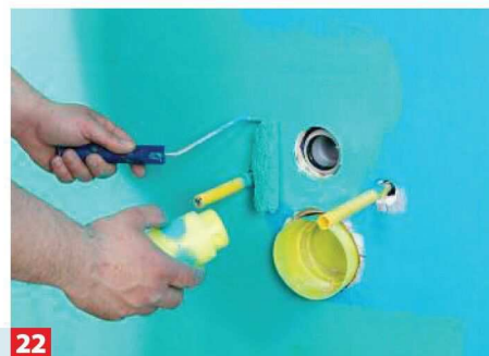
19 Für den zweiten Dichtanstrich kann man ein Kontrastmittel in die Flüssigabdichtung rühren, um den Auftrag besser kontrollieren ...
