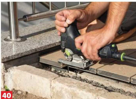
40 Die Diele am Kellereingang wird mit der Stichsäge zugeschnitten, da man mit der Handkreissäge dort nicht hingelangt.
