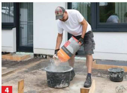
4 Zum Schutz vor Feuchtigkeit wurde die bestehende Betonplatte mit Dichtschlämme abgedichtet. Hierfür geben Sie die ...
