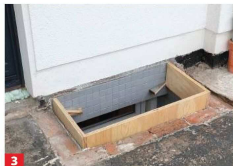
3 Damit kein Estrich in den Kellerschacht gelangt, wurde auch dieser Bereich verschaltet.
