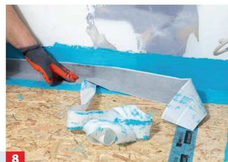
8 Es handelt sich um ein selbstklebendes Dichtband. Die Schutzfolie einfach während des Verklebens Stück für Stück abziehen.
