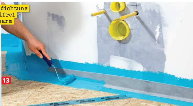
10 An Stellen wie oben im Bild die selbstklebenden Innenecken aus dem Dichts Sortiment verkleben.
