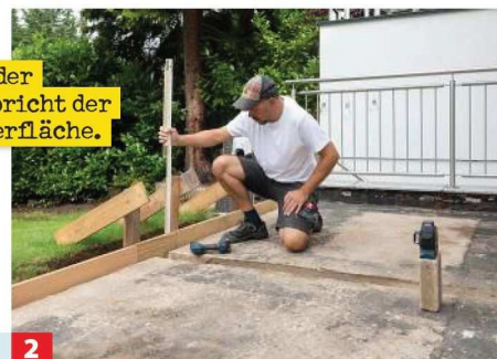
2 Die Höhen haus- und gartenseitig kontrollieren und ein gleichmäßiges Gefälle von etwa zwei Prozent zum Garten berücksichtigen.
