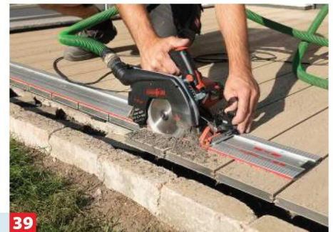
39 Am besten gelingt das entlang einer Führungsschiene.
