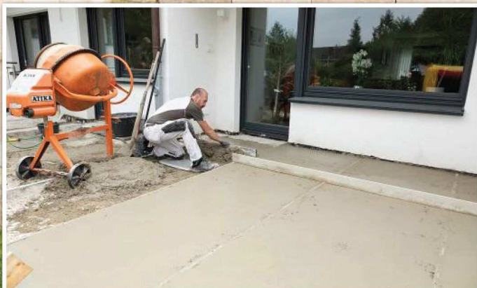
» VERBUNDESTRICH Auftragen eines Verbundestrichs ab Seite 12
