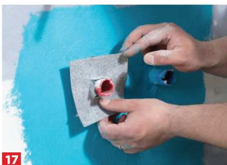
14 Für Rohrausgänge (Ø 15-32 mm) gibt es vorgefertigte Dichtmanschetten. Eine Packung von Akkit enthält zwei Stück.
