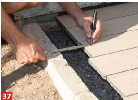
37 Markieren Sie, wo Sie die Dielen zum Garten hin kürzen wollen. Hier sollte zwischen Randstein und Diele 15 cm Platz sein.
