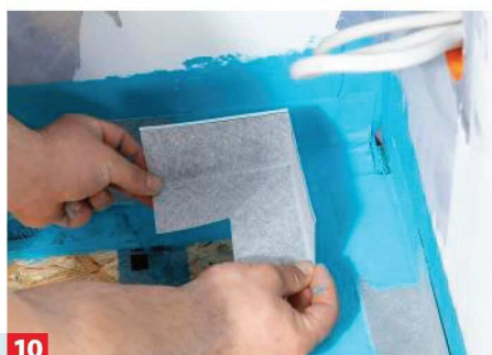
10 An Stellen wie oben im Bild die selbstklebenden Innenecken aus dem Dichts Sortiment verkleben.
