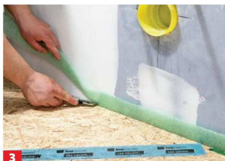
3 Zum Fliesenlegen eventuelle Randdämmstreifen schon jetzt bodenbündig abtrennen.
