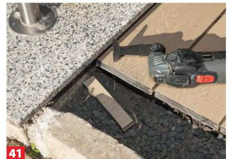
41 Auch mit der Stichsäge kann man die Diele nicht komplett zuschneiden, deshalb kam ein Multifunktionswerkzeug zum Einsatz.
