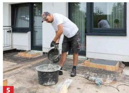
5 ... Fertigmischung mit der entsprechenden Wassermenge in einen großen Eimer. Beachten Sie hier die Angaben des Herstellers.
