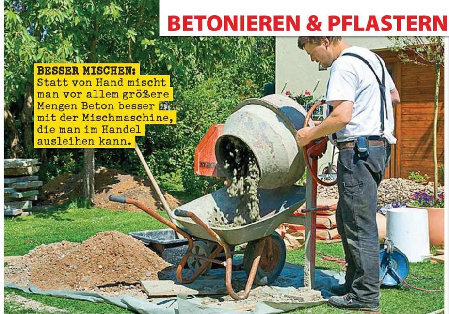
**BESSER MISCHEN:** Statt von Hand mischt man vor allem größere Mengen Beton besser mit der Mischmaschine, die man im Handel ausleihen kann.
