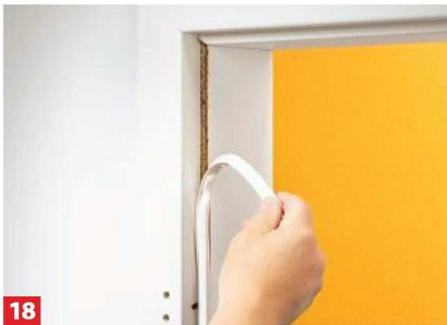
18 Die Dichtung im oberen Zargenbereich etwas herauslösen und ...
