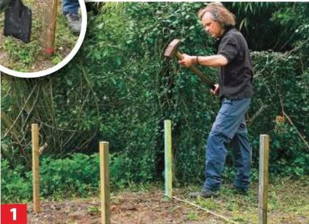
**1** Die Größe der Bodenplatte festlegen und an den Ecken angespitzte Pfähle senkrecht in den Boden schlagen.
