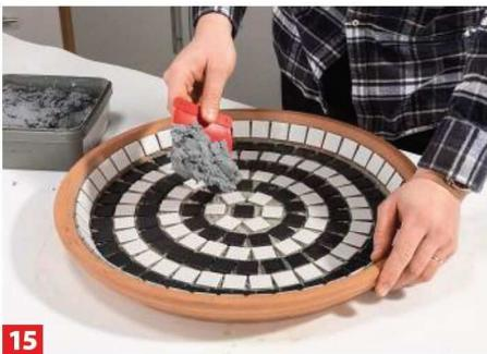
**15** Der Fugenmörtel ist verwendungsfertig angemischt. Tragen Sie mit einem elastischen Plastikspachtel den Mörtel auf ...
