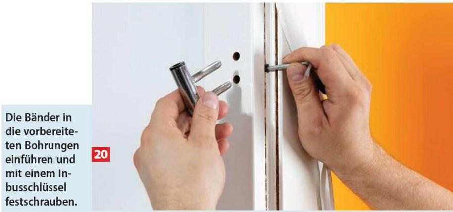
20 Die Bänder in die vorbereiteten Bohrungen einführen und mit einem Inbusschlüssel festschrauben.
