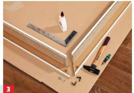
**3** ... dafür, dass das Band in der Zarge hält – sehr wichtig bei einer schweren Glastür. Zunächst die Zargenteile zusammenbauen.
