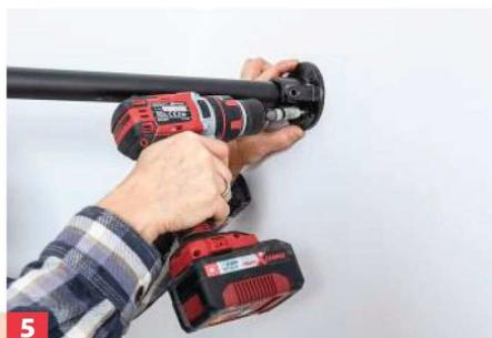
**5** Nach dem Einzeichnen und Bohren schrauben Sie die Verbinder mit geeigneten ...
