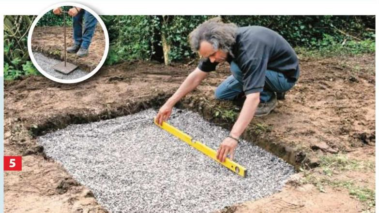
**5** Den Kies mit der Harke verteilen, mit dem Stampfer verdichten und die Fläche waagrecht glatt abziehen.
