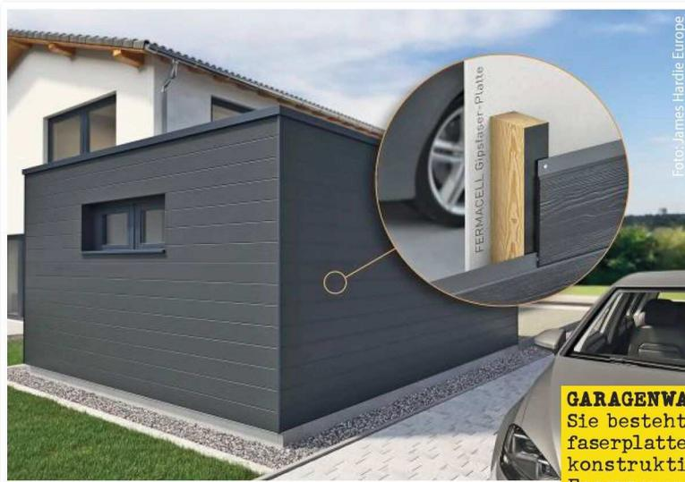
**GARAGENWAND:** Sie besteht aus Gipsfaserplatte, Holzunterkonstruktion und Faserzementplatten.
