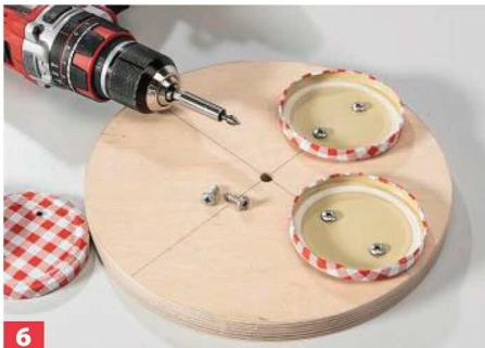
**6** Bohren Sie die Deckel vor und schrauben Sie sie fest. Halbrundkopfschrauben (evtl. mit Unterlegscheiben) verwenden!
