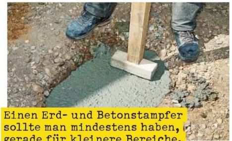
Einen Erd- und Betonstamper sollte man mindestens haben, gerade für kleinere Bereiche, für die Maschinen zu groß sind.
