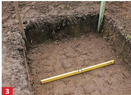
**3** Prüfen Sie mit der Wasserwaage, ob der Boden nach dem Ausheben eben und die Grube damit gleichmäßig tief ist.
