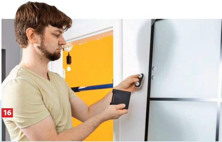
16 Jetzt beide Bänder der Glastür in den vorgefertigten Löchern befestigen.
