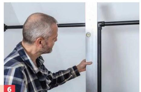
**6** ... Dübeln und schwarzen Schrauben fest. Ständer mit der Wasserwaage ausrichten.
