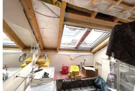
**MITTENDRIN:** Alles wurde abgedeckt, ein Sparren durchtrennt, ein Wechsel gesetzt und die Fenster montiert, inkl. Abdichtung.
