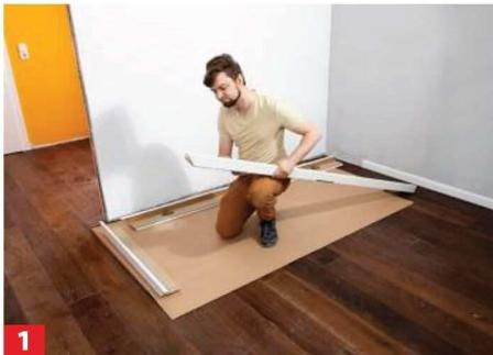
**1** Den Rahmen auf ebenem Untergrund auslegen. Er besteht aus tragender Zarge und Zierbekleidung, die man später in der ...
