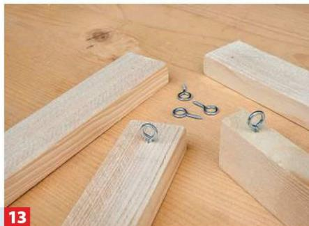
**13** ... und zum Haken passende Position der Schrauböse ermitteln, dort vorbohren und die Öse (nicht zu tief) eindrehen.
