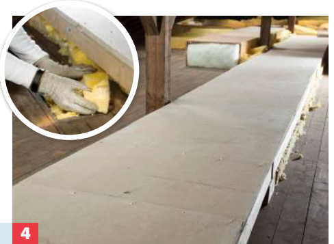
2 DÄMMUNG UNTER LAUFWEG: Zwischen der parallel, möglichst in Dämmstoffbreite laufenden Balkenlage Dämmmatten klemmen.
