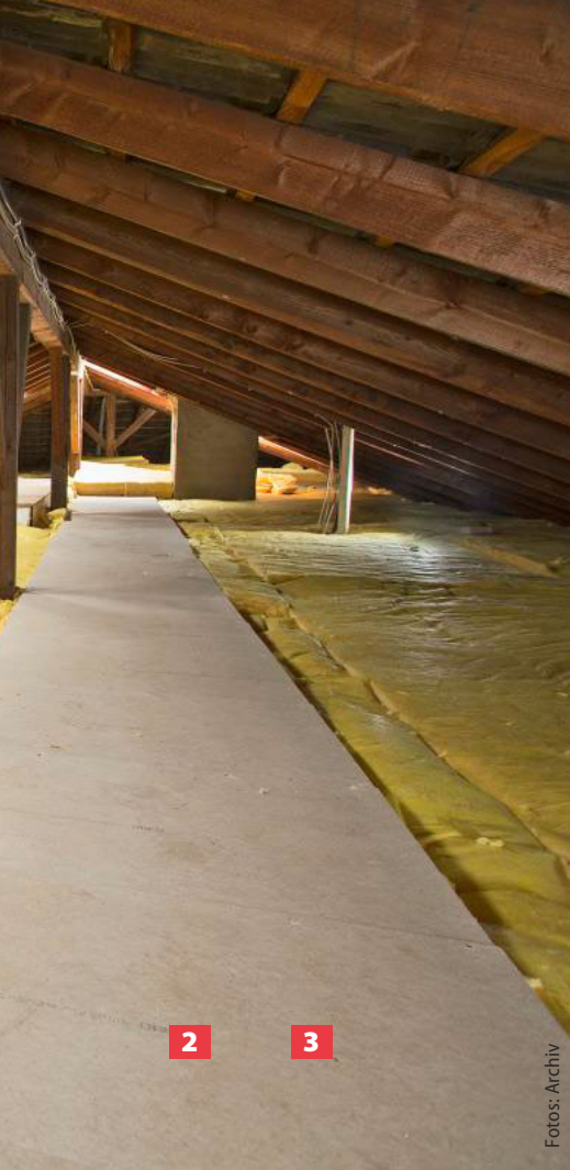
1 BALKENLAGE FÜR LAUFWEG: Für stabilen Laufweg, z. B. zum Schornstein, Balkenkonstruktion in Dämmstoffhöhe montieren.
