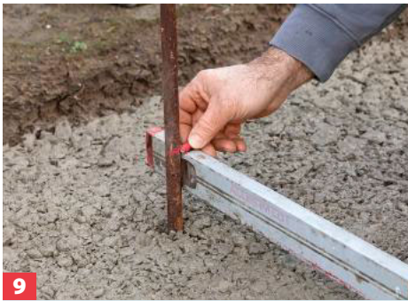
9 Fluchtschnüre auf späterer Oberkante der Pflastersteine zwischen den Eisen spannen.
