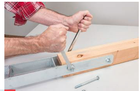
8 ... zwischen Querstrebe und Balkenende gelassen. Nach dem Bohren werden die Anker mit Sechskantschrauben (vor Ort) befestigt.
