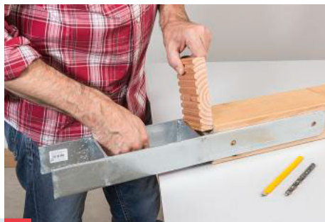
7 Am unteren Ende der Stützen markieren Sie die Bohrungen für die H-Bodenanker. Wir haben überall eine Dielenstärke Luft ...
