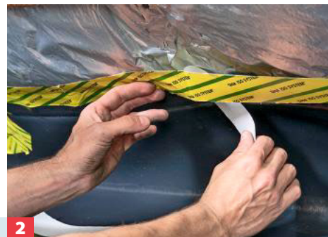
2 Bei (früher schlecht) gedämmten Dachschrägen, die Bodenfolie bis über die Folie an der Schräge ziehen, dort mit Klebeband verkleben.
