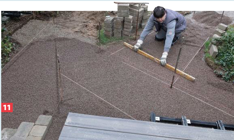
9 Fluchtschnüre auf späterer Oberkante der Pflastersteine zwischen den Eisen spannen.
