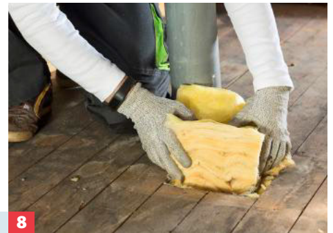
4 LÜCKEN UNTERM LAUFWEG DÄMMEN: Eventuelle Lücken zwischen Balken und Boden mit Dämmstoffstücken ausstopfen.
