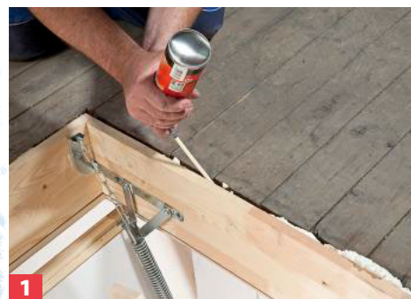
1 Ungedämmte Treppen erneuern, Hohlstellen zwischen Treppenkasten und Decke ggf. dämmen, z.B. mit Dämm- und Zargenschäum.
