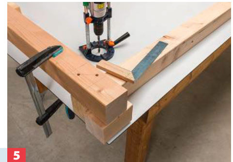
2 ... Längen der Stützen! Bei der Unterkonstruktion werden die Querträger mit den Stützen verschraubt. Markieren Sie die Lage ...
