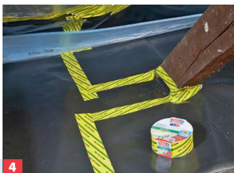
4 Die Dampfbremsfolie auch an Bahnenübergängen und Durchdringungen wie Balken oder Rohren fest verkleben.
