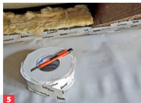
5 Bei ungedämmten Dachschrägen die Folie nicht an der Eindeckung, sondern davor wie hier an der Schwelle fest verkleben.
