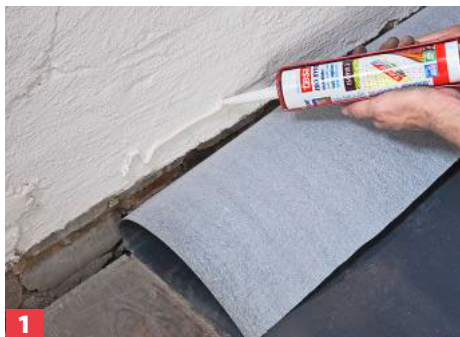
1 Dampfbremsfolien zu Giebelseiten z.B. mit einem geeigneten Kartuschenkleber befestigen: auftragen und Folie andrücken.
