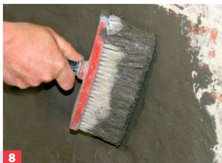
8 Bis einschließlich einer Steinreihe oberhalb der Bohrlöcher Dichtschlämme zweilagig aufziehen (siehe S. 45). Nach 7 Tagen verputzen.
