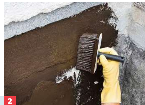
2 ... mischen und bis Geländeoberkante (GOK) auftragen. Vorher kurz unter GOK bis 15 cm über GOK eine Dichtschlämme verstreichen! 1)
