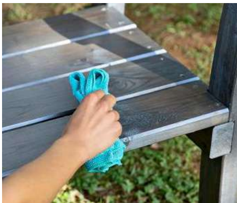
ABTRAGEN: Überschüssiges Material sollte mit einem Lappen abgetragen werden.
