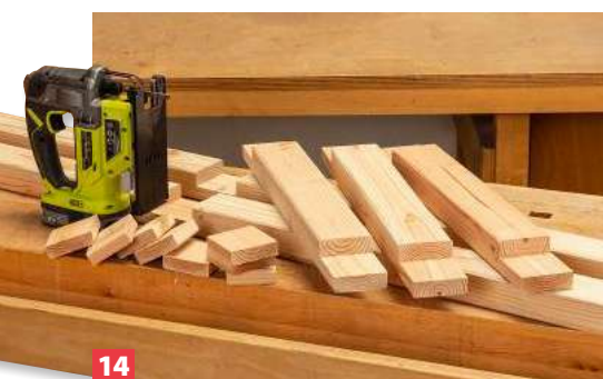
14 Nun ist der Deckel dran: Die drei Elemente werden nach dem gleichen Verfahren wie die Seiten gebaut. (Maße siehe Zeichnung).
