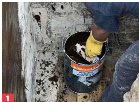
1 Innenecken, Wand- und Bodenanschlüsse mit Mörtel als Hohlkehlen ausbilden. Es folgt der Voranstrich, den Sie 1:10 mit Wasser ...
