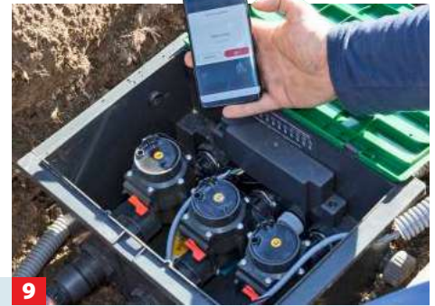
9 Ist die Ventilbox mit der smart Irrigation Control verbunden, kann das Bewässerungssystem in die App eingebunden werden.
