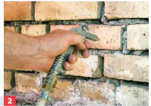
2 Lochabstand bei 10- bis 40-cm-Mauern max. 12,5 cm, ab 41 cm bis 70 cm max. 8 cm. Bohrlöcher dann ausblasen oder -saugen.
