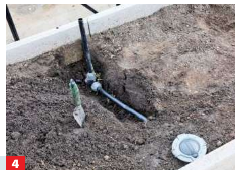
Wasser marsch! Dank des eingebauten „ Micro-Drip-Systems “ werden die Pflanzen im Gewächshaus optimal versorgt.
