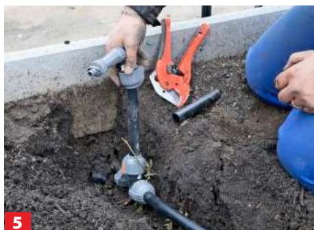
5 Die Verlegung des Micro-Drip-Systems findet oberirdisch statt. Dazu zunächst das Basisgerät mit dem Verlegerohr verbinden.
