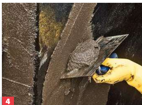
4 ... Wassereinwirkung abhängt (siehe Herstellerhinweise). 2) Die Dickbeschichtung mit einer Glättkelle dünn, aber vollflächig deckend ...
