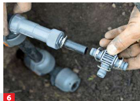
6 An das Micro-Drip-System wird ein Verteilerrohr gekoppelt, an das ein Kreuzverbindungsstück angeschlossen werden kann.
