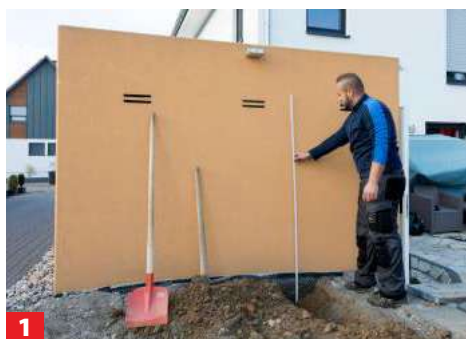
1 Für die Zuleitung in den Garten wird zuerst ein circa 25 cm tiefer Graben ausgehoben, in dem später ein Kanalgrundrohr verlegt wird.
