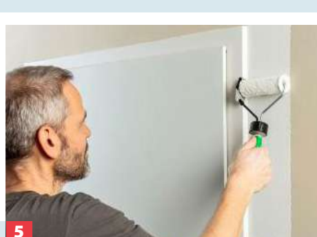
5 Erst dann streichen Sie die Kanten oder Ecken, indem Sie den Schild an der Kante ...
