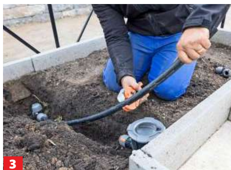
2 Um das von der Ventilbox abgehende Verlegerohr mit der Wassersteckdose zu verbinden, schließen Sie einen L-Verbinder an.
