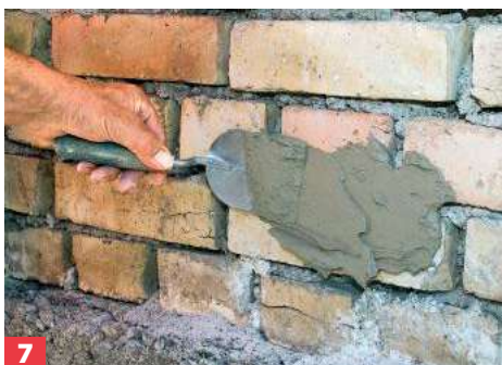
7 Saugwinkel und Kapillarröhrchen herausziehen (steckt es fest, ggf. abschneiden) und Löcher mit Reparaturmörtel verspachteln.
