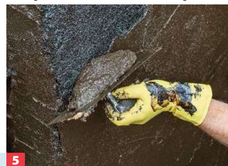
5 ... aufziehen. Die zweite Schicht frisch in frisch aufziehen, die gesamte Nassschichtdicke muss ca. 3,6 mm betragen. 3)
