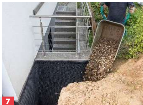
7 ... am Rand ein Abdeckprofil montieren. Den Graben mit lehmfreiem Material zuschütten, um ein Quellen des Bodens zu vermeiden.
