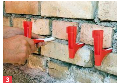
3 Kapillarröhrchen zuschneiden (Bohrlochtiefe plus 7 cm), bis zum Anschlag in die Saugwinkel stecken und diese in die Bohrlöcher.
