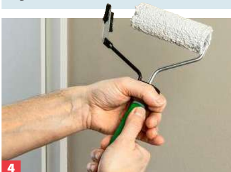
4 Bevor Sie den Schild zurückdrehen, sollten Sie etwas Farbe an der Wand ausrollen.
