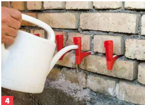
4 Die Saugwinkel zweimal in kurzen Abständen mit sauberem Wasser füllen und die Kapillarröhrchen 15 Min. aufquellen lassen.
