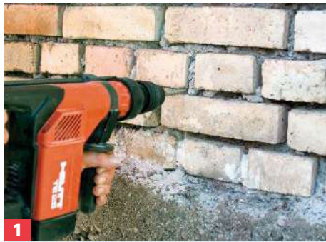
1 14-mm-Löcher horizontal in die untere Mauerwerksfuge bohren bis 5 cm Restwanddicke. Die Wand also nicht komplett durchbohren.
