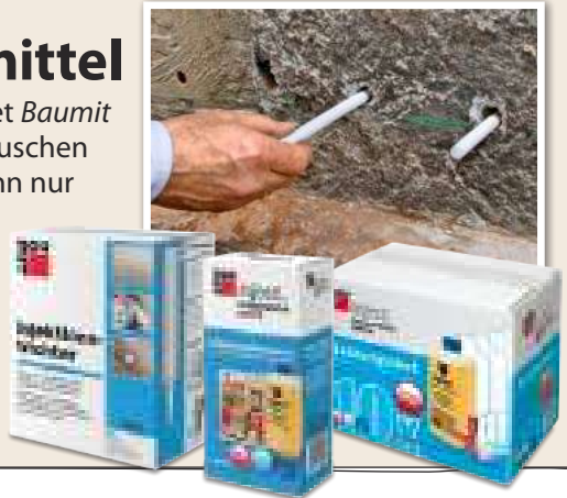
3 Kapillarröhrchen zuschneiden (Bohrlochtiefe plus 7 cm), bis zum Anschlag in die Saugwinkel stecken und diese in die Bohrlöcher.
