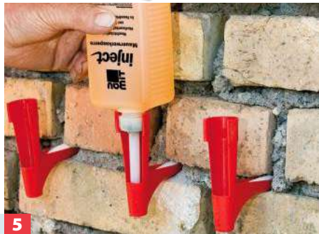
5 Die mit Mittel gefüllten Einzelkartuschen mit dem aufgeschraubten Endstück in die Klemmvorrichtungen der Saugwinkel stecken.
