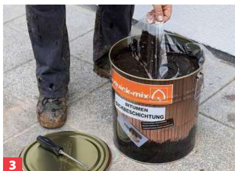
3 Nach 24 Stunden Bitumendickbeschichtung auftragen. Dies erfolgt stets in zwei Lagen, wobei die Art des Auftrags von der ...
