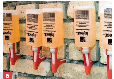
6 Nach ca. 12 bis 48 Std. sollte die Kartusche vollständig entleert sein und kann abgenommen und ggf. wiederbefüllt werden.
