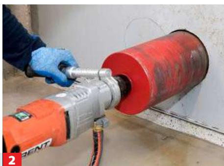
2 Um den Wasseranschluss von der Garage aus in den Garten zu legen, wurde mit einem Diamant-Kernbohrer ein Zugang gebohrt.
