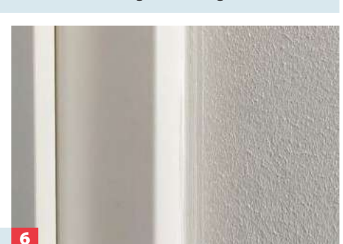
6 ... entlangführen. Die Bürstenkante des Seitenschilds hinterlässt eine feine, saubere Spur.
