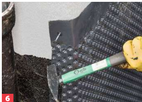
6 Nach drei Tagen eine Noppenbahn oberhalb der Bitumenbeschichtung ansetzen und dort festnageln, nicht verkleben. Oben ...
