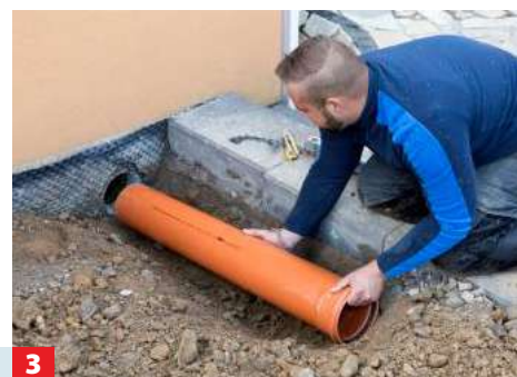
3 Ist der Zugang fertig, kann das 160-mm-KG-Rohr verlegt werden.
