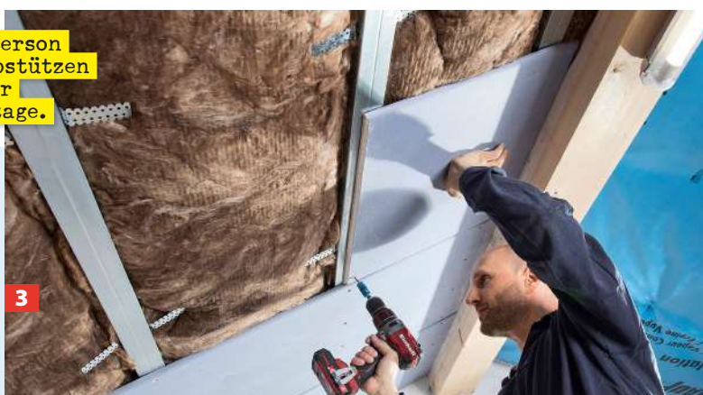
1 Die Platten Knauf Diamant GKFI mit max. Schraubenabstand von 17 cm (Decke und Schräge; an der Wand 25 cm) verschrauben.
