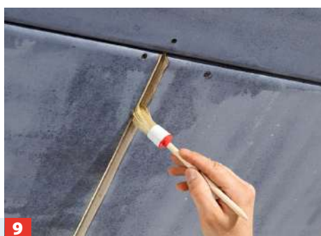
Schnittkanten möglichst komplett grundieren und mit Fugendeckstreifen verspachteln!
