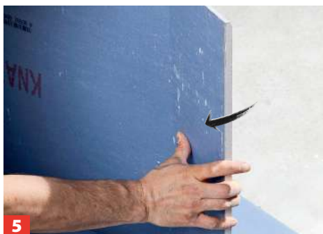
... komplettes Durchtrennen ermöglicht. Mit Cutter angeritzte Platten können aber auch leicht über eine Kante gebrochen werden.
