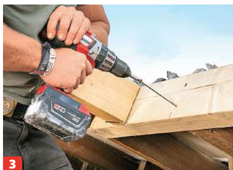
3 Um die Konstruktion zu stabilisieren, werden Wechsel bzw. Hilfssparren eingezogen und mit bestehenden Sparren verschraubt.
