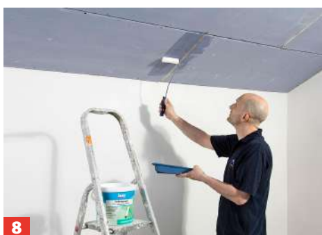
Tragen Sie entlang der Anschlussfugen Tiefengrund auf, damit der Fugenspachtel gut haftet.
