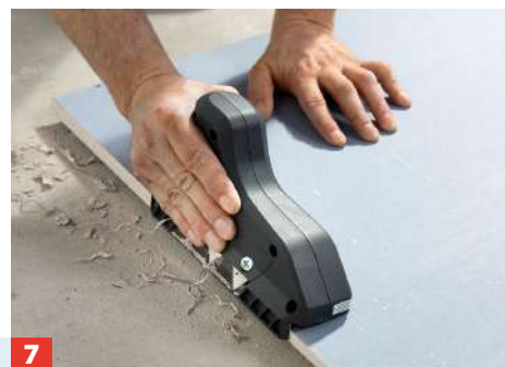
Schnittkanten mit einem Hobel brechen, hier ein 3-Fach-Kantenhobel.
