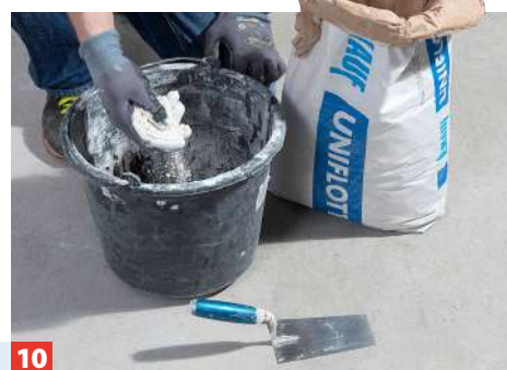
Der erste Spachtelgang erfolgt mit Knauf Uniflott . Rühren Sie die Masse mit der angegebenen Menge Wasser cremig an.
