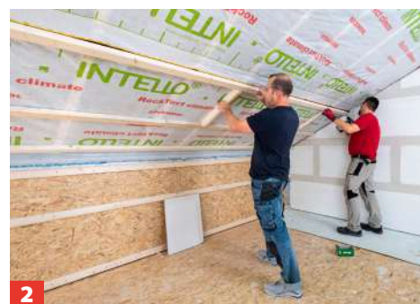
2 Ein Lattenabschnitt hilft, gleichmäßige Lattenabstände einzuhalten; das Kalkin Klima-Board von Baumit ist 62,5 cm breit, ...
