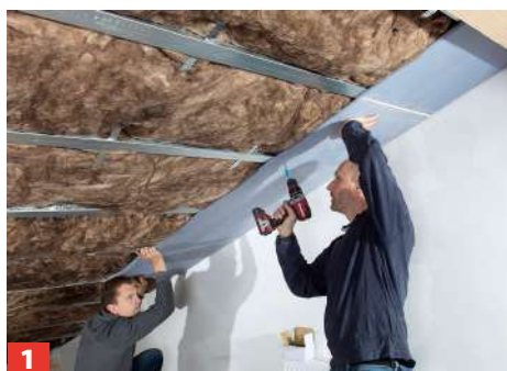
1 Die Platten Knauf Diamant GKFI mit max. Schraubenabstand von 17 cm (Decke und Schräge; an der Wand 25 cm) verschrauben.
