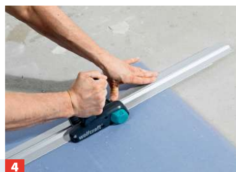
Der Plattenzuschnitt gelingt mit Cutter und Schiene, noch einfacher mit Gipskartonschneider (z. B. von Wolfcraft ), der ein ...
