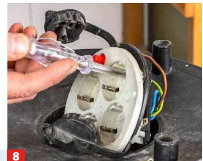
8 Vor der erneuten Montage haben wir die Steckdosen der Verteilung auf Funktion geprüft.
