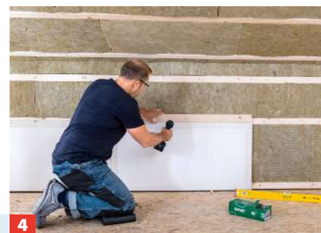
4 Ist der Falzbereich zum Boden abgetrennt, montieren Sie die untere Plattenreihe mit 5 mm Abstand zum Boden.
