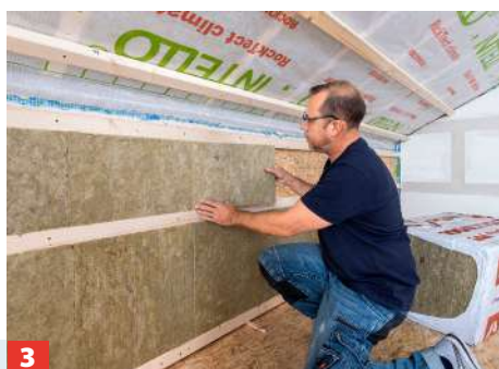
3 ... allerdings wird der Falzbereich von 6 cm zu Anschlussbauteilen abgetrennt. Zwischen die Lattung Untersparrendämmfilz klemmen.
