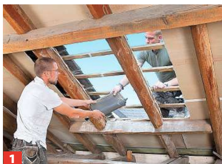
1 Für den Fensterausschnitt werden alte Dachbahnen oder -platten herausgetrennt und die Dachpfannen aufgenommen.
