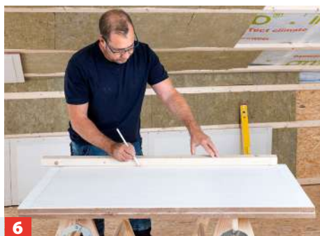
6 Im Dremelpbereich sind meist Längsschnitte fällig, damit die Platte passt. Die Schnittlinie mit Bleistift anzeichnen.
