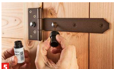
5 Mit dem Ausbesserungslack lassen sich auch die Schraubenköpfe behandeln.
