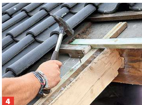
4 Von außen nagelt man Dachlatten so auf, dass Dämm- und Fensterrahmen daran festgeschraubt werden können.
