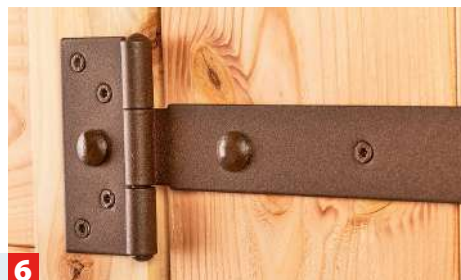
6 Aus einem Guss: So sieht der aufgeschraubte Beschlag nach dem Bearbeiten aus.
