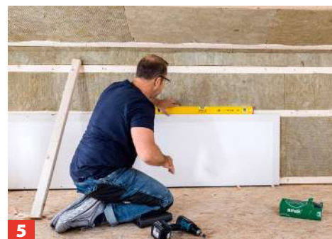
5 Die Verschraubung erfolgt alle 20 cm mit rostfreien Spanplattenschrauben 4,5 x 50 mm. Die waagerechte Ausrichtung kontrollieren!
