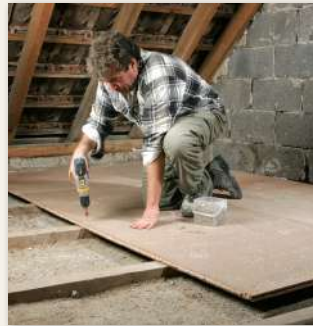
Die Verschraubung erfolgt hier direkt auf den Balken.
