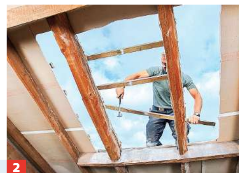
2 Nun trennt man in der Öffnung die Dachlatten und die Sparren heraus und stützt den Bereich provisorisch ab.
