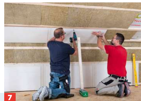
7 Die Schrauben bündig zur Falzoberfläche bzw. Kalkputzbeschichtung verschrauben, nicht tiefer einschrauben.
