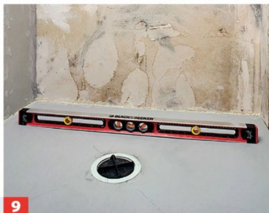
7 Das 1200 x 1200 mm große Dusch-element (Bodenablaufsystem Fermacell Powerpanel TE) nun auflegen.
