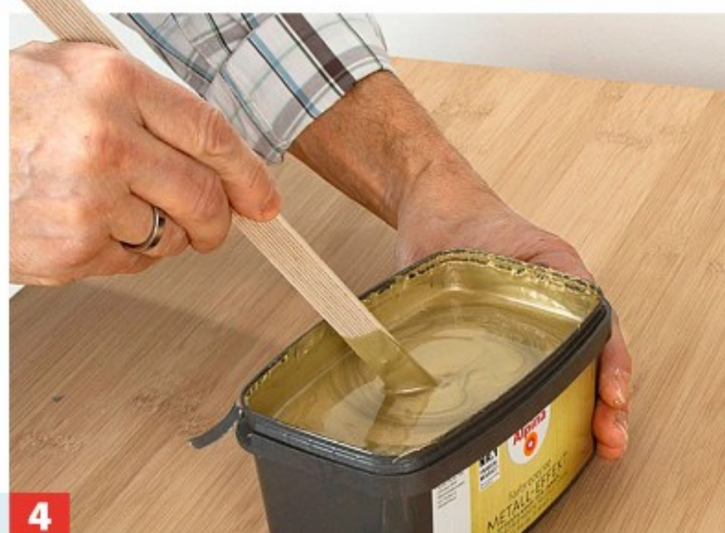
4 Nach dem Trocknen rühren Sie die Metall-Effekt-Lasur sorgfältig auf. Dann ziehen Sie sich Gummihandschuhe über.
