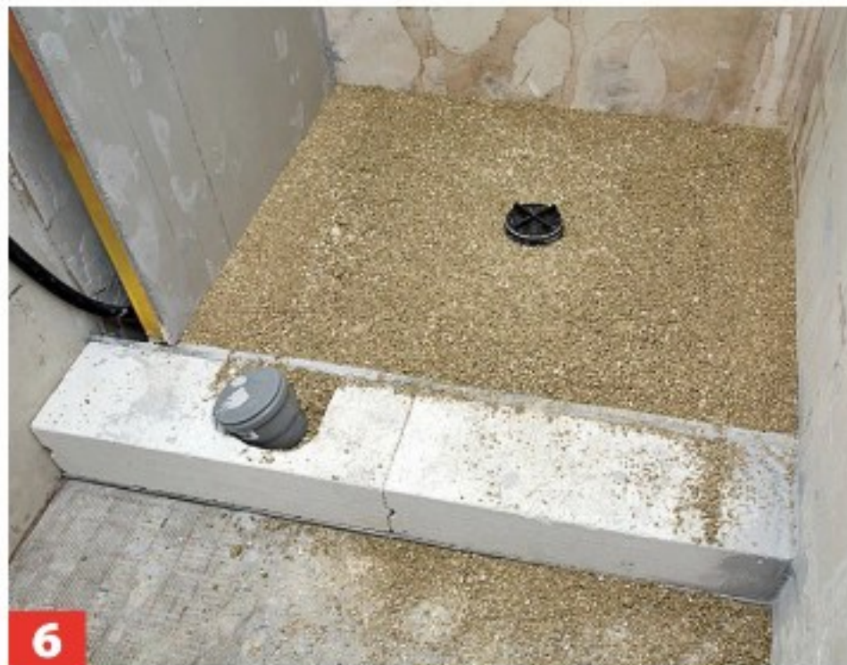
3 ... Dusche verwirklicht. Den Hohlraum zwischen den Abflussrohren kann man mit einer Schüttung ausgleichen.
