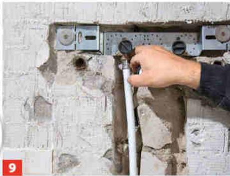
**9** ... Eck in den Wandschlitz zum Anschlussbereich führen. Den Fitting an den Messinglaschen mit der Montageeinheit verschrauben.
