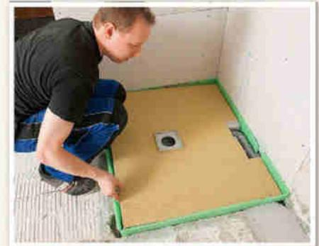
Das Duschelement wird über dem Abfluss platziert und dann direkt gefliest.
