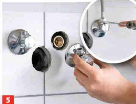
**5** Eckventile in den Wandausgängen verschrauben. Die Anschlüsse für die Trinkwasserschläuche müssen nach oben zeigen.
