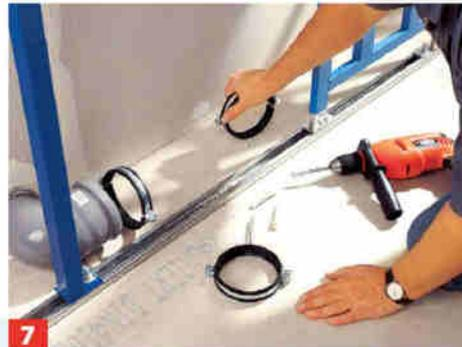
**7** Zur Verlegung Schellen im Boden verschrauben, Abstand bei Falleitung 2 m, bei liegender Leitung 10 mal Rohrdurchmesser.
