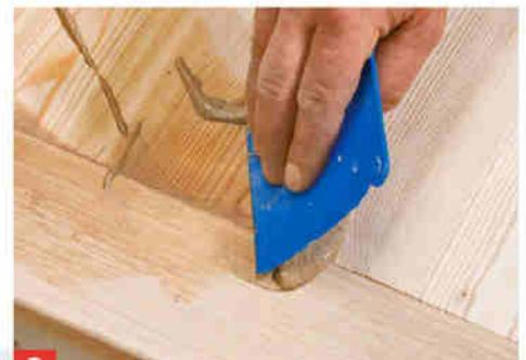
2 Kitt in die Fugen bzw. Schadstellen füllen und abziehen. Das Verfüllen von Fugen hält nur dauerhaft auf fest verklebten Böden.
