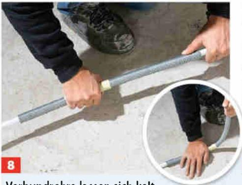
**8** Verbundrohre lassen sich kalt biegen. Dazu eine Biegefeder über das Rohr stülpen. Danach kann man es über ...
