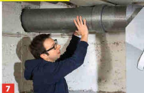
**7** Nun die Schaumrohre für Außen- und Fortluft sowie Zu- und Abluft an das Gerät anschließen. Hier das Außenluftrohr.
