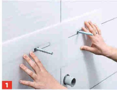
**1** Waschtischmontage: Stockschrauben montieren und die zum Becken passende Schallschutzmatte über die Schrauben hängen.
