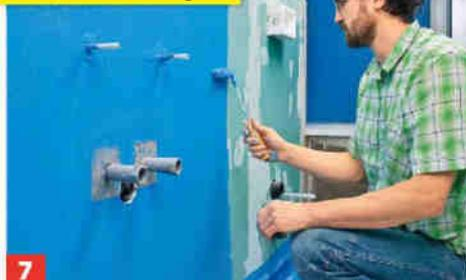
**7** Rund um Rohrausgänge sowie über Fugen Dichtband verkleben und Flächen im Spritzwasserbereich mit Dichtanstrich behandeln.
