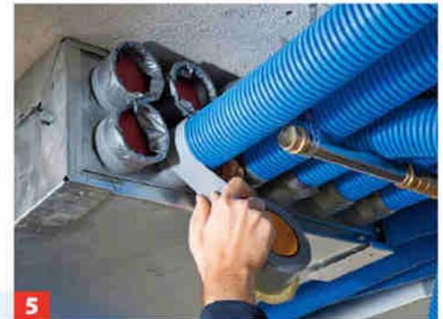
**5** In die Flexrohrenden stets einen Dichtring einsetzen und die Anschlüsse rundum mit Kaltschrumpfband abdichten.
