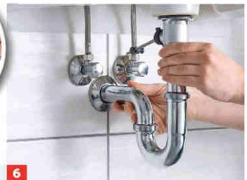
**6** Schläuche mit Ventilen und Armatur verschrauben und den Siphon montieren. Dazu Ventilkelch von oben durchs Ablaufloch führen.
