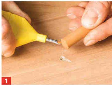
1 Reinigen Sie die Schadstelle, ggf. Überstände abschleifen. Suchen Sie einen passenden Grundton aus und erhitzen den Füllstoff ...
