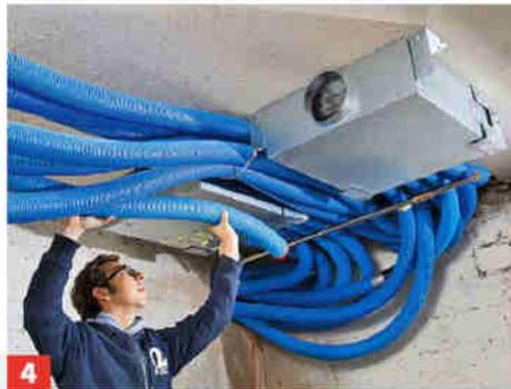
**4** Die Zu- und Abluftrohre münden nahe des Lüftungsgerätes in zwei Luftverteilern, hier inkl. Schalldämpfer für 12 x DN-75-Flexrohr.
