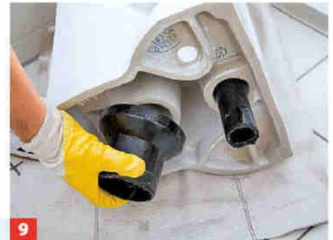
**9** Ermitteln Sie auch hier die nötige Rohrlänge, in der Regel muss man die Rohre etwas kürzen. Schnittkanten entgraten!
