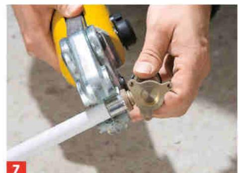
7 Das Rohr in das Formstück am Fitting stecken, die Pressbacken der Handpresse über die Presshülse setzen – und verpressen.
