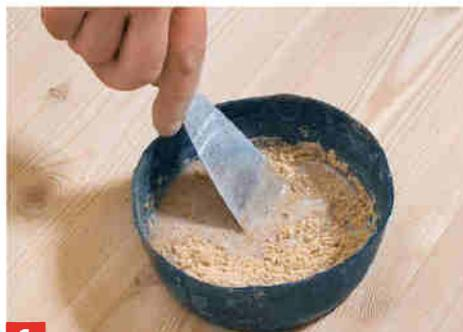
1 Mit einem Spachtel die Fugenkittdispersion und den im Raum entstandenen Schleifstaub zu einer cremigen Masse verrühren.
