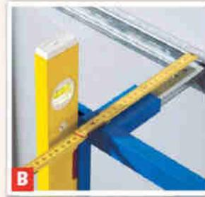
**B** Das Modul unten und oben exakt ausrichten, dann die Muttern an den Schienen festziehen.
