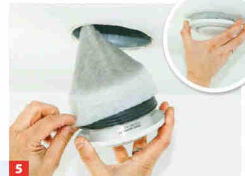
**5** Nun noch die Ablufteingänge reinigen: Tellerventil herausziehen, alten Filter abnehmen und neuen (hier für DN 125) aufsetzen.
