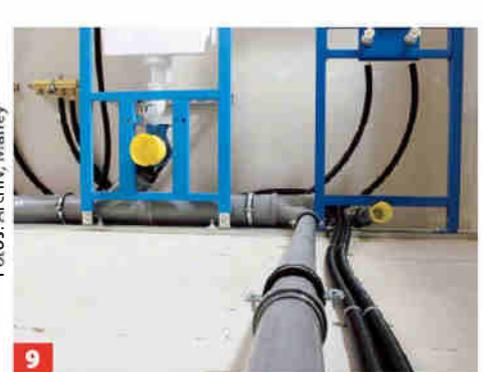
**9** Trink- und Abwasserrohre werden von den Vorwandmodulen mit Gefälle zu den entsprechenden Zu- und Abflüssen verlegt.
