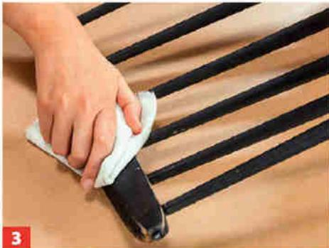
**3** Anschließend müssen die Oberflächen gründlich gereinigt und von Staub befreit werden. Verwenden Sie dazu einen feuchten Lappen.
