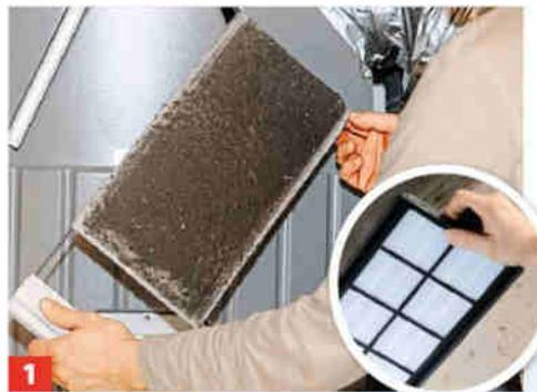
**1** Die Filter im Lüftungsgerät zweimal pro Jahr wechseln: Filterteil herausnehmen, neuen Filter aufziehen und wieder hineinstecken.
