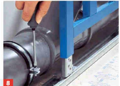
**8** Die Rohre durch die Schellen bis unterhalb der Muffen führen und die Schrauben an den Schellen festziehen.
