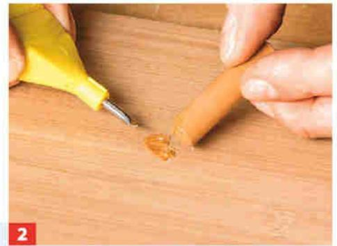
2 ... mit dem Schmelzer. Dazu runden Knopf entriegeln und nach unten drücken. Den Füllstoff dann in die Schadstelle tröpfeln.
