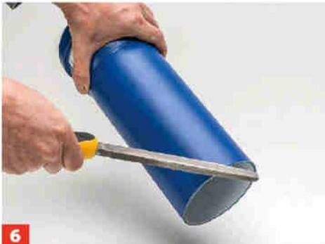
**6** Die Rohrenden sind werkseitig angefasst. Feilen Sie das Schnittende entsprechend schräg an, das erleichtert die Montage.
