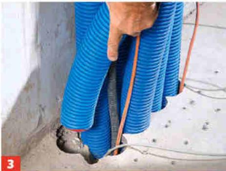
**3** Flexrohre für Zu- und Abluft gebündelt in Abkastungen entlang von Wand oder Decke führen. Entsprechende Bohrungen einplanen.
