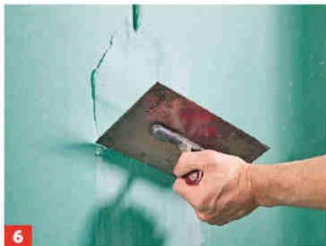
**6** Geschnittene Plattenkanten mit Tiefengrund behandeln, dann die Fugen und Schraublöcher verspachteln.<sup>3)</sup>
