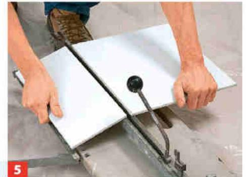
**5** Für gerade Zuschnitte Fliesenschneider bereithalten: Fliese einspannen, mit dem Messer anritzen und über die Kante durchbrechen.
