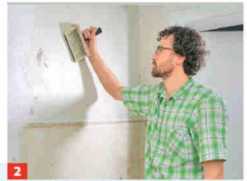
**2** ... grundieren. *Knauf* empfiehlt auf saugenden Untergründen *Haftemulsion*, auf schwach saugenden wie Zementputz *Betokontakt*.
