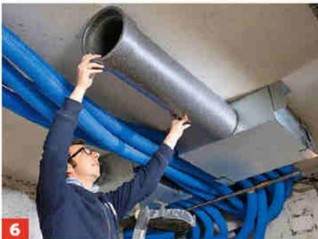
**6** Von der anderen Seite des Verteilers überbrückt man die Rohrstrecke zum Lüftungsgerät mit Schaumrohr DN 180.
