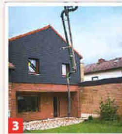
Die Hartschaumelemente sind Schalung und Dämmung in einem. Sie werden mit Bewehrung versehen und dann folgt der Beton.
