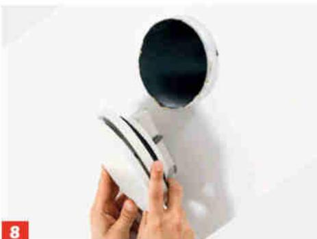
**8** In den Zu- und Abluftrohrausgängen der Räume (an Decken oder Wänden) entsprechende Zu- und Abluftventile montieren.
