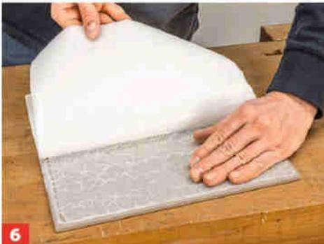
**6** Mit rundum 0,5 cm Abstand verkleben Sie nun das Haftgewebe Stück für Stück, indem Sie das Trennpapier langsam abziehen.
