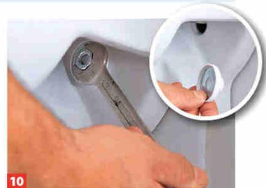
**10** Mit beiliegenden Befestigungsmaterial das WC an den Gewindestangen festschrauben. Der Deckel wird meist einfach aufgesteckt.
