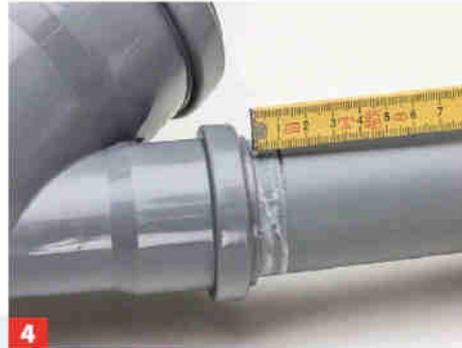
**4** Ziehen Sie das eingesteckte Rohr nun wieder 1 cm heraus. Machen Sie dies bei jeder dieser Steckverbindungen.
