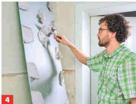
**4** Den angerührten Gips batzenförmig im Abstand von je 30 cm auf der Plattenrückseite verteilen und die Platte an die Wand drücken.
