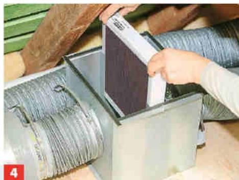
**4** Den Pollenfilter ebenfalls alle halbe Jahre tauschen: Aus dem Gehäuse (hier DN 150/ DN 160) entnehmen und neuen einsetzen.
