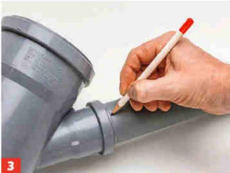
**3** Damit die Rohre nicht unter Spannung geraten, benötigen sie etwas Spiel. Dafür am Muffenende eine Markierung vornehmen.
