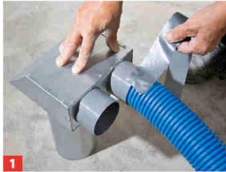
**1** Die Luft wird über Flexrohre transportiert. Mit Eckübergängen verbindet man sie mit den Zu- und Abluftventilen in den Räumen.
