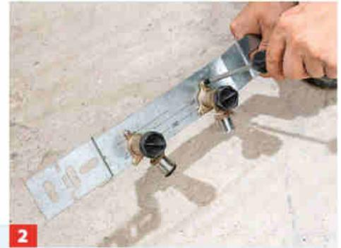
2 Die Verbindung von Rohrströcke und Waschtischanschluss stellt eine Montageeinheit mit Pressfittings dar (System von KAN-therm).
