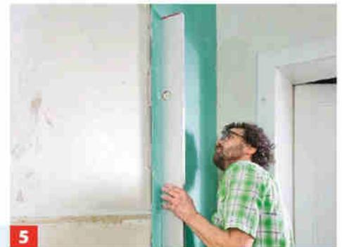
**5** Beim Ausrichten mit Richtschiene und Gummihammer auf 10 mm Abstand zum Boden und 5 mm Abstand zur Decke achten.
