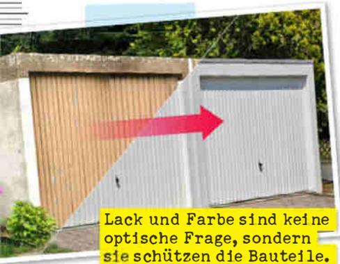
Winter Split- und Streusalzreste sowie Nässe ins Innere. Daneben sollte sich das **Tor** problemlos öffnen und schließen lassen (ggf. die Federn schmieren) und alle Scharniere und Federn in gutem Zustand sowie frei von Korrosion sein.
