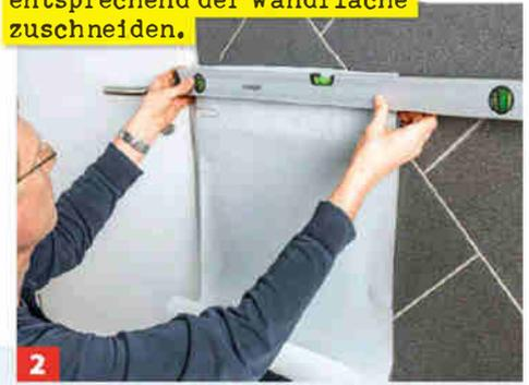
**2** Dank des aufgeklebten Klettbandes haftet die Wasserwaage am Gewebe – und dieses kann leicht ausgerichtet werden.
