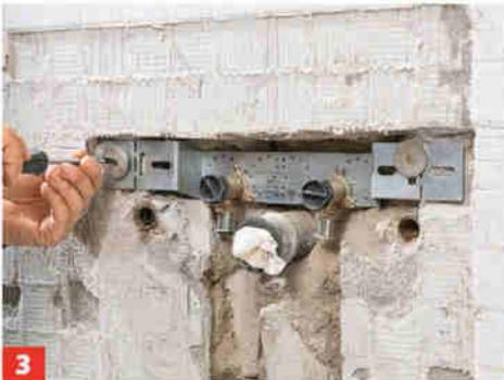
3 Die Montageeinheit in einer entsprechend aufgestemmen Wandvertiefung oberhalb des Abflusses verdübeln.
