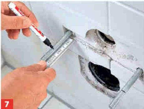
**7** WC-Montage: Die eingedrehten Gewindestangen entsprechend der WC-Aufhängung mit Metallsäge ggf. kürzen.
