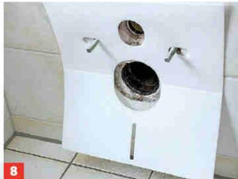
**8** Passende Schallschutzmatte über die Stangenstülpfen. Nun die Anschlussrohre (siehe Grafik unten) für Spülung und Abfluss montieren.
