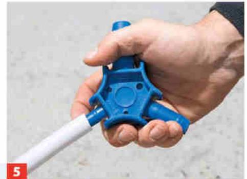
5 Um die Dichtheit sicherzustellen, entgratet man das Rohrende deshalb mit einem Kalibrierwerkzeug, bis es rund und glatt ist.
