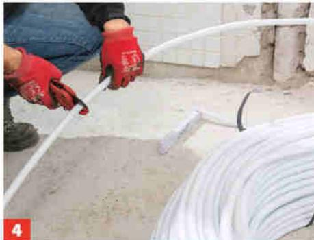
4 Verbundrohre lassen sich mit einer Rohrschere auf die nötige Länge kürzen. Danach ist das Rohrende aber etwas scharfkantig.
