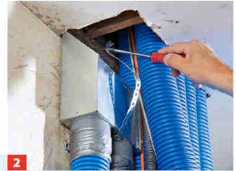
**2** Rohrdurchgang zum Raum bohren und Eckübergang entsprechend befestigen. Raumseits Ventile montieren (siehe Bild 8).
