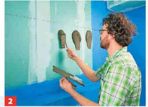
**2** ... gleich breit auslaufen. Den Fliesenkleber anrühren und zwischen den Markierungen abschnittsweise auftragen.
