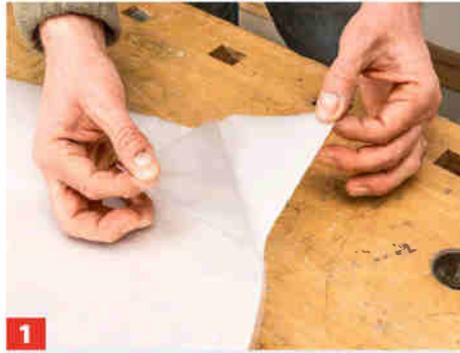
**1** Zum Verkleben etwa 4 cm der Trennschutzfolie abziehen, umschlagen und mit den Heftklammern am Trägergewebe fixieren.
