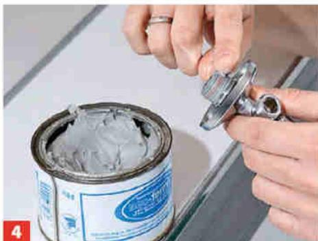
**4** Es folgt der Anschluss der Eckventile. Über die Gewinde Hanf wickeln und Dichtpaste auftragen.
