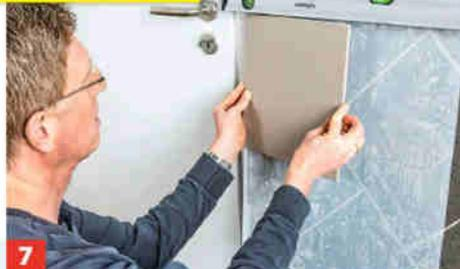
**7** Die erste Fliese ausrichten und in kreisförmigen Bewegungen andrücken. Sind alle Fliesen verklebt, wird herkömmlich verfugt.
