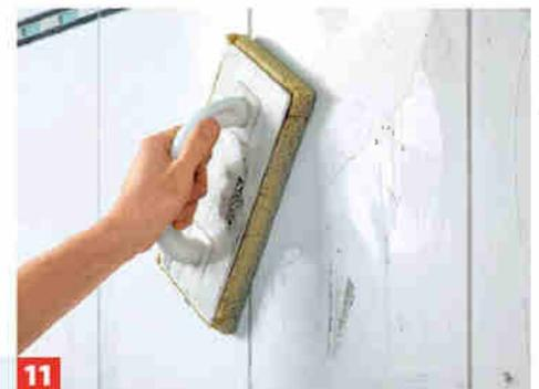
**11** Fugenmörtel mit einem Fugbrett einschlämmen und diagonal zum Fugennetz abziehen. Die Fläche mittels Schwamm Brett säubern.
