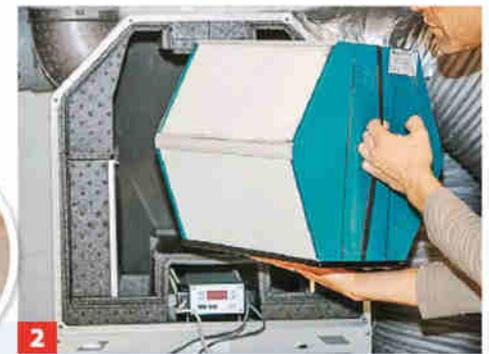
**2** Auch den Wärmetauscher ab und zu komplett entnehmen und reinigen. Hierzu müssen nur ein paar Schrauben gelöst werden.
