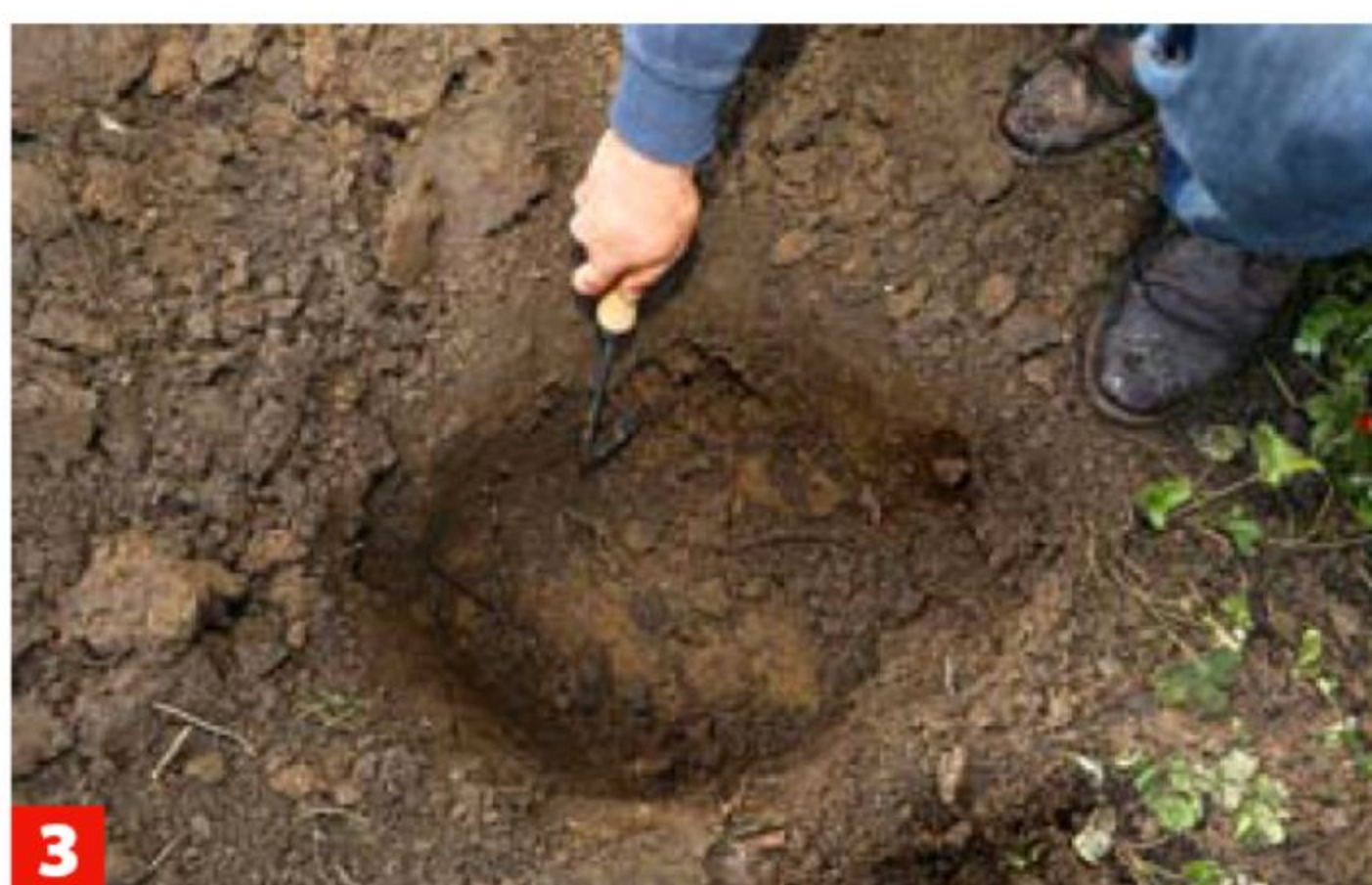
3 Lockern Sie anschließend bei lehmigem Boden die Sohle und die Wände des Lochs.
