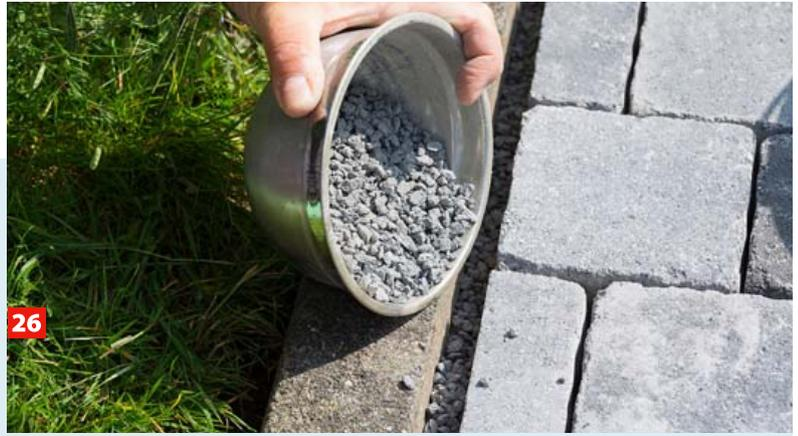
Die etwas breiteren Fugen zwischen Pflaster- und Randsteinen können sauber mit Splitt aufgefüllt werden.
