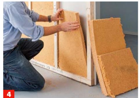
Die Wandstärke von 40 mm lässt hier Platz für 40 mm Dämmung. Verkleidet wird mit Bauplatten seiner Wahl.
