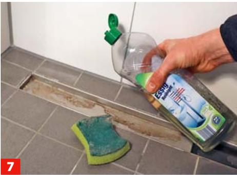
**7** Links und rechts vom Abfluss den eingebauten Rinnenkörper ebenfalls reinigen.
