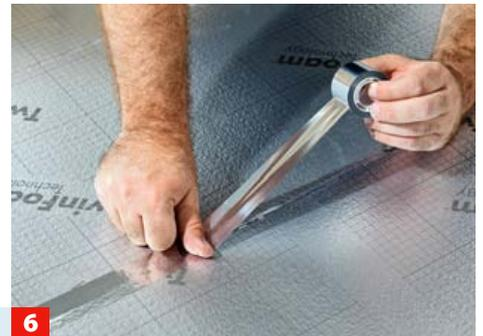
**6** Abschließend die Bahnenanschlüsse und im Prinzip auch die Fugen zur Wand mit dem dazugehörigen Dichtband abkleben.
