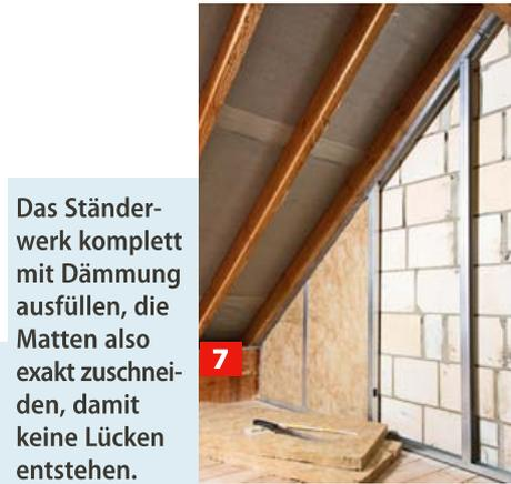
**7** Das Ständerwerk komplett mit Dämmung ausfüllen, die Matten also exakt zuschneiden, damit keine Lücken entstehen.
