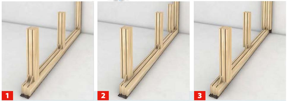
Unter die Anschlusshölzer wie gewohnt Dämmstreifen kleben und die Hölzer dann an Boden, Wand und Decke verdübeln. Die Ständer passend ablängen und mit Hilfe der Montagechips fixieren, **1** alle mittig, **2** zu einer Seite versetzt oder **3** abwechselnd zu beiden Seiten.
