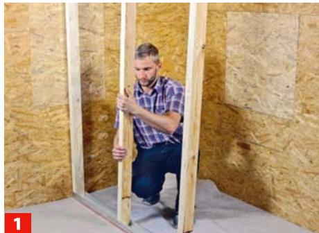
**1** Die Verarbeitung ist vergleichbar der von Profilen: Auf den Dämmstreifen folgt eine Bodenschwelle, auf der die Holzständer ...
