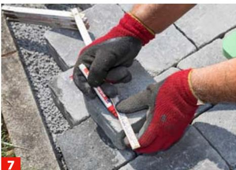
**7** Vermessen Sie die Lücke und markieren Sie genau, an welcher Stelle der Pflasterstein gekürzt werden muss.
