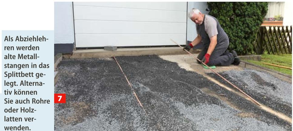
7 Als Abziehlrahmen werden alte Metallstangen in das Splittbett gelegt. Alternativ können Sie auch Rohre oder Holzlatten verwenden.
