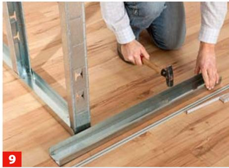
**9** Für die Wand vorne verdübeln Sie im Abstand einer Plattenstärke vor der gesetzten Wand UW-Profile an Boden und Decke.
