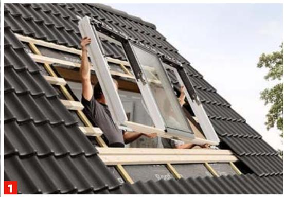
**PRAKTISCH:** Es handelt sich quasi um ein Fenster, denn das Element besteht aus einem einzigen Blendrahmen, der mit drei Fensterflügeln bestückt ist bzw. wird.
