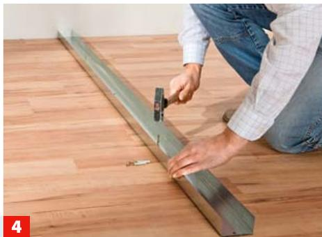
**4** Erst die UW-Profile an Boden und Decke mit Nageldübeln befestigen, Dübelabstand maximal 70 cm.
