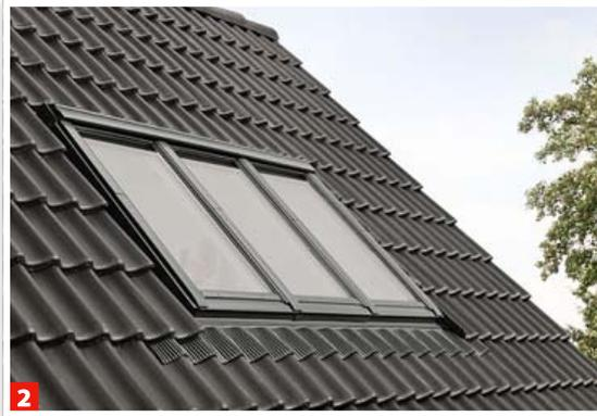
**SCHNELL FERTIG:** Der Einbau gestaltet sich für den Dachdecker erheblich einfacher, als wenn er drei einzelne Fenster ins Dach setzen müsste.
