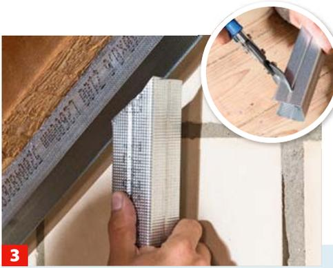
**3** Die nötigen CW-Profile passend ablängen. Oben müssen sie entsprechend der Dachschräge zugeschnitten werden.
