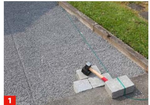
**1** Mit einer Richtschnur werden hier Verlaufsrichtung und Aufbauhöhe der Pflasterung festgelegt.
