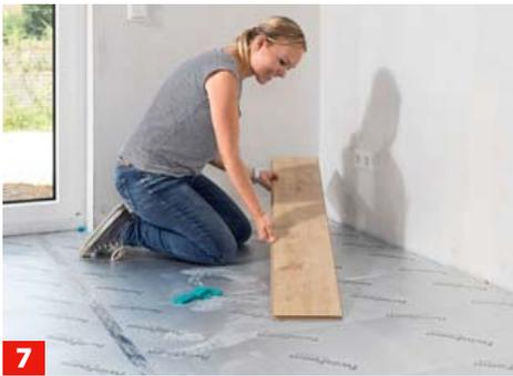
**7** Beginnen Sie die Verlegung in einer linken Raumecke, möglichst in Längsrichtung zur Lichtquelle. Die Federseite muss dabei ...
