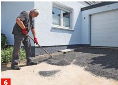
6 Bringen Sie nun eine etwa vier bis fünf Zentimeter dicke Splittschicht auf der gesamten Fläche aus und verteilen Sie sie.
