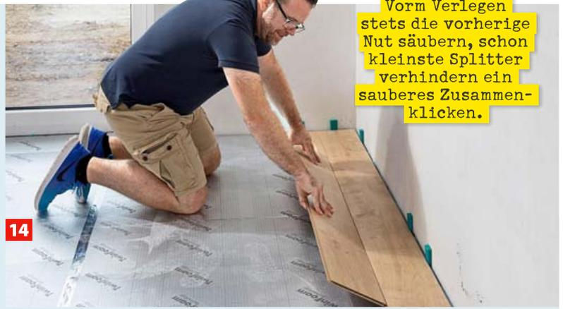
**14** Dank der praktischen Klickverbindung (siehe Kasten unten links) lassen sich die weiteren Elemente sehr leicht verlegen – einfach schräg ansetzen und absenken, bis es klickt.
