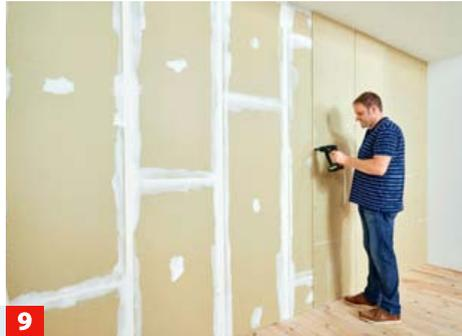
**9** ... zweite Lage Platten, deren Fugen ebenfalls verspachtelt werden. Anschlussfugen abschließend mit Acryl verschließen.
