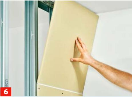
**6** Die zugeschnittene Platte dichtgestoßen an die vorherige ansetzen und verschrauben. Alle weiteren mit einem Stirnkantenversatz ...
