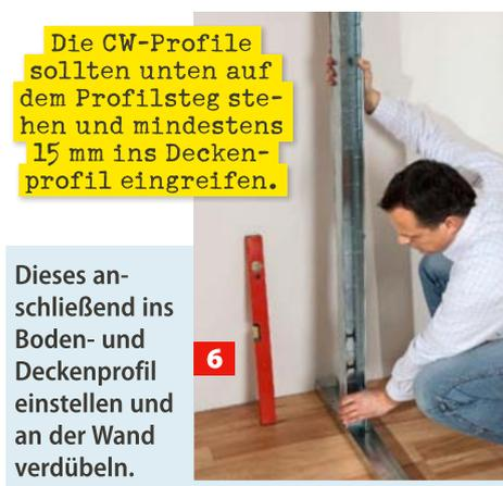
**6** Dieses anschließend ins Boden- und Deckenprofil einstellen und an der Wand verdübeln.
