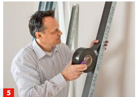
**5** Auch das CW-Anschlussprofil für die Wand mit einem Dichtstreifen bekleben.
