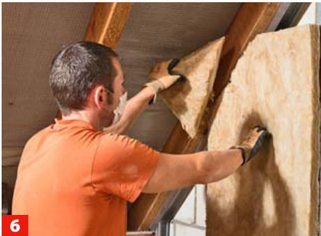
**6** Passend zu den 50-mm-Profilen wurden 50-mm-Dämmplatten eingesetzt. Der Zugschnitt erfolgt mit scharfem Küchenmesser.
