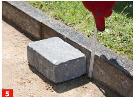
5 Kontrollieren Sie an unterschiedlichen Stellen der Randeinfassung mit einem Pflasterstein die Aufbauhöhe.
