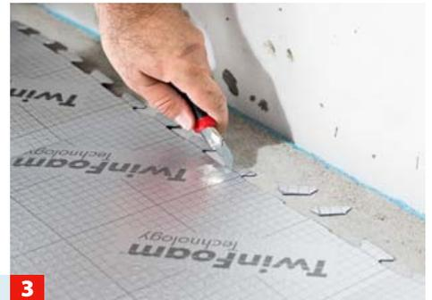
**3** Die Rasterung, mit der die Bahnen ineinandergreifen, sollten Sie wandseits abschneiden, damit die Unterlage bündig anschließt.
