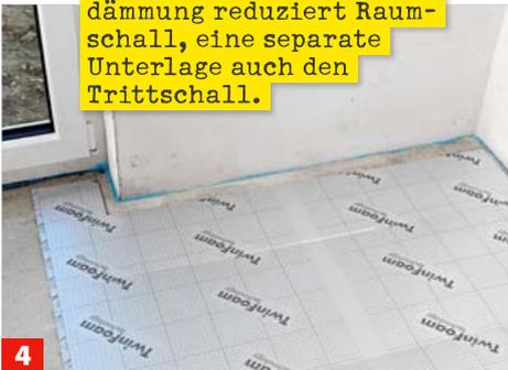
**4** Denn bei der Unterlage handelt es sich eben auch um einen Feuchteschutz, der möglichst dicht an der Wand anliegen muss.
