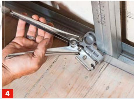
**4** Sind die CW-Profile in die UW-Rahmenprofile eingestellt, verquetscht man sie hier der Stabilität wegen mit einer Profil-Verbundzange.
