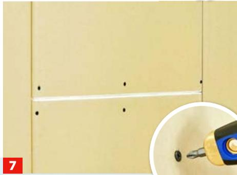
**7** ... von mindestens 40 cm montieren, die Schnellbauschraubenköpfe leicht versenken!
