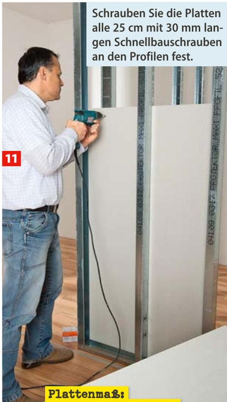
Schrauben Sie die Platten alle 25 cm mit 30 mm langen Schnellbauschrauben an den Profilen fest.
