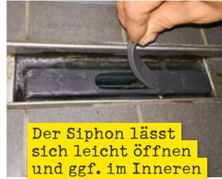
Der Siphon lässt sich leicht öffnen und ggf. im Inneren etwas reinigen.
