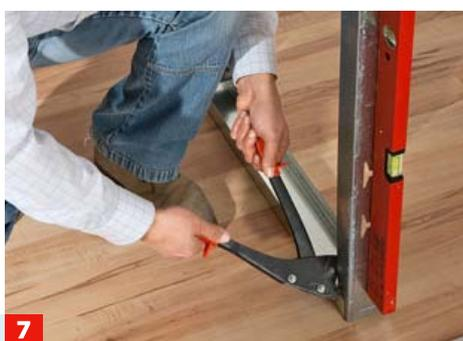
**7** Stellen Sie danach das äußere CW-Profil ein und verquetschen es mittels Profilverbundzange<sup>1)</sup> mit dem Boden- und Deckenprofil.
