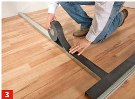
**3** Alle Rahmenprofile mit einer Anschlussdichtung bekleben, um Schallbrücken zum bestehenden Mauerwerk zu vermeiden.
