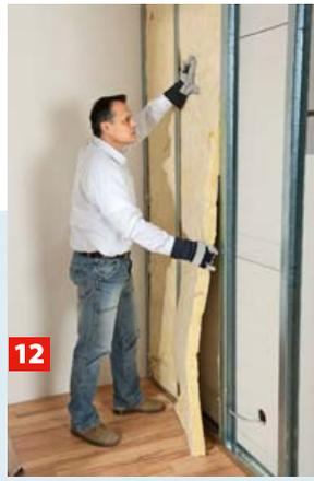
Um etwas Schallschutz zu gewährleisten, klemmen Sie Dämmmatten ein, hier 70-mm-Mineralwolle.
