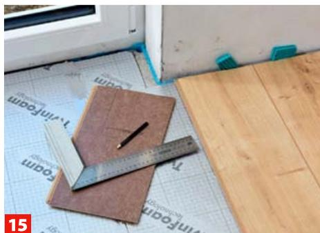
**15** Bei Zuschnitten erneut die Dehnungsfuge berücksichtigen! Ob Sie aber von unten oder von oben anzeichnen, ist im Prinzip ...
