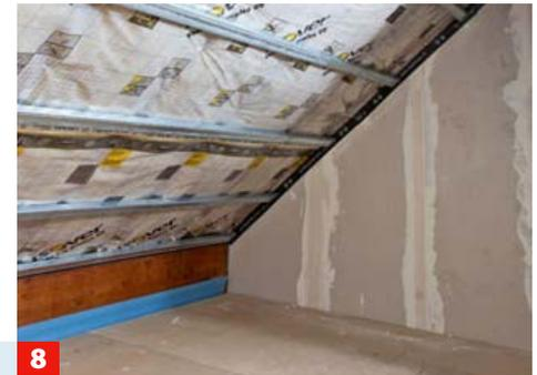
**8** An Außenwänden vor der Verkleidung mit Gipsplatten eine Dampfbremse luftdicht über der Dämmebene verkleben.
