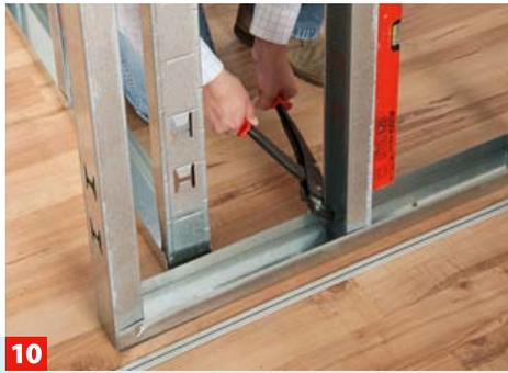
**10** Dann stellen Sie erneut CW-Profile ein. Eine mechanische Verbindung sollte nur erfolgen, wenn die Konstruktion zu instabil ist.
