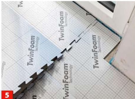
**5** Die einzelnen Unterlagsbahnen mit der puzzelartigen Rasterung, die ein Verrutschen verhindern soll, dichtgestoßen verlegen.
