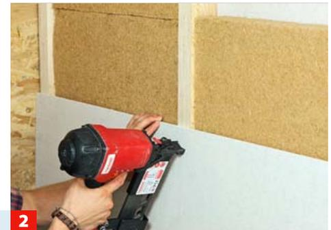
**2** ... aufgestellt werden. Die Lücken füllt man mit Dämmung. Die Plattenmontage erfolgt mit Schrauben oder einfach mit Klammern.
