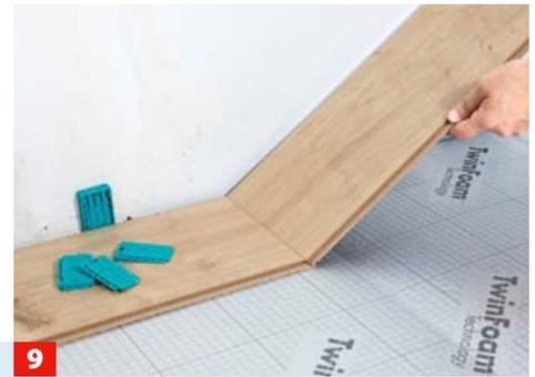
**9** ... hierfür Keile einsetzen, die dies sicherstellen. Die folgenden Elemente der ersten Reihe stirnseitig einfach einschwenken.<sup>1)</sup>
