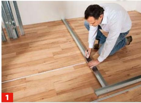
**1** Den gewünschten Wandverlauf auf dem Boden skizzieren und auf UW-Profilen, die als Decken- und Bodenprofile dienen, ...
