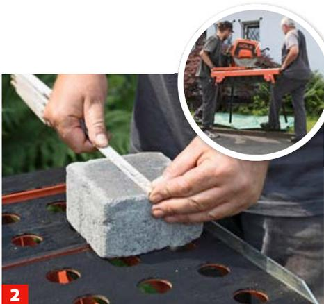
**2** Markieren Sie Steine, die zugeschnitten werden müssen, und sägen Sie sie mit der Steintrennmaschine.
