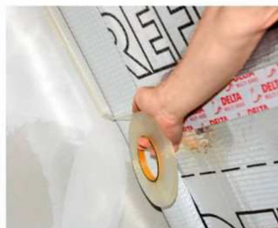
Dichte Giebelanschlüsse ohne Anpresslatte: Delta-Tixx VDR Klebeschnur von der Rolle.
