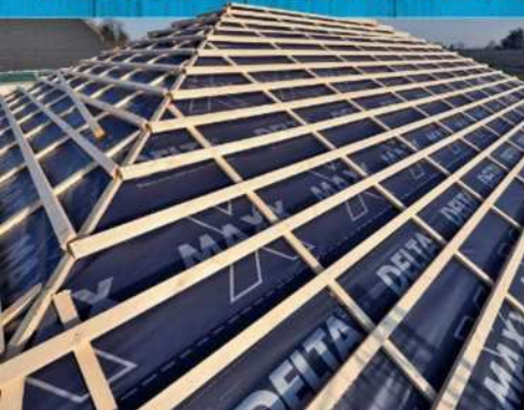
Reißfest, dehnfähig, diffusionsoffen, wasserdicht: Unterdeckbahn Dörken Delta Maxx X.
