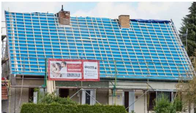
VON AUSSEN Dampfbremse um die Sparren plus 160 mm Zwischensparrendämmung ...
