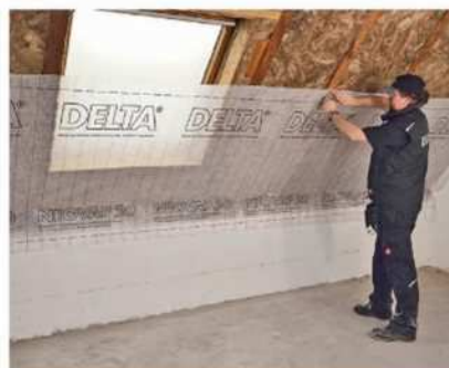
Durchsichtige Folie Dörken Delta-Neovap 20 = sichtbare Sparren = einfaches Tackern.
