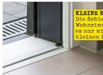
SCHWELLENLOS: Fenster mit Absenk- und flächengleich eingelassener Bodenschiene.
