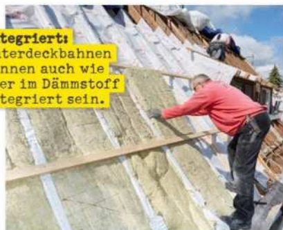
VON AUSSEN Dampfbremse um die Sparren plus 160 mm Zwischensparrendämmung ...
