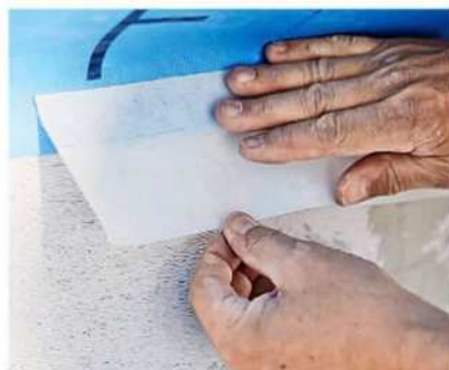
Überputzbare und dichte Giebelanschlüsse: LDS Einputzband von Knauf Insulation.
