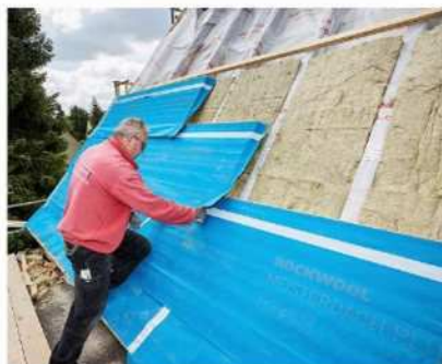
... mit Klemmrock 035, darüber 80 mm Dachdämmplatten Masterrock GF kaschiert.
