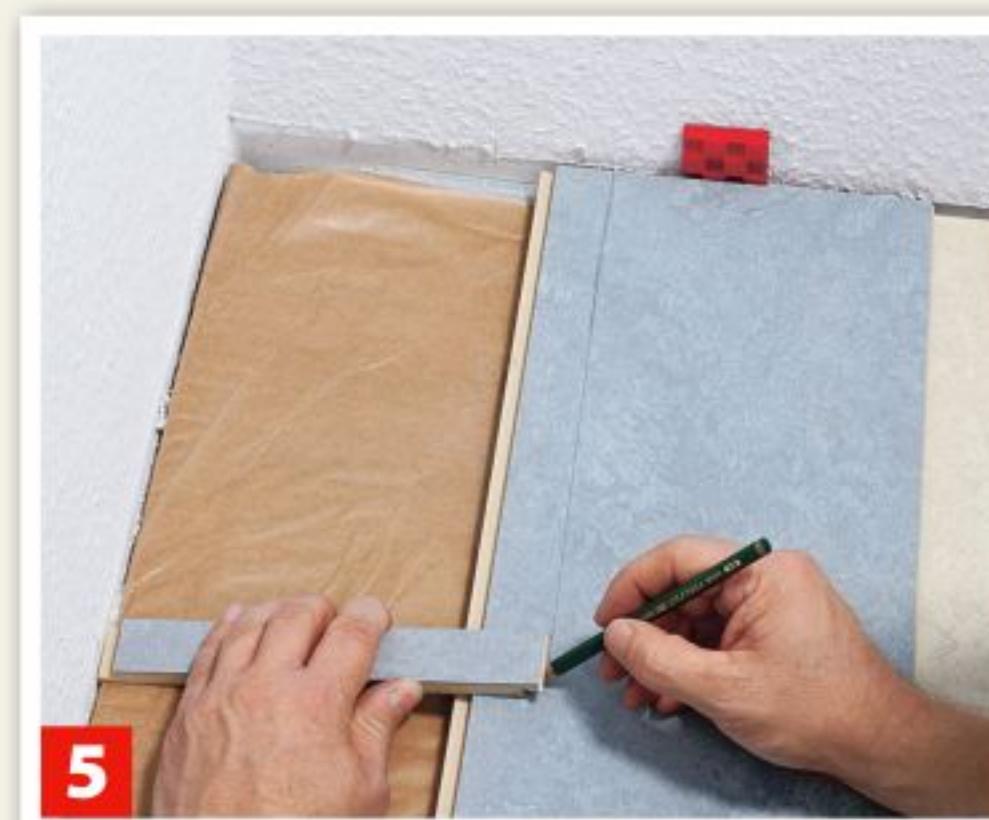
5 Oben ein Trick zur Markierung für Zuschnitt der letzten Reihe. 3)
