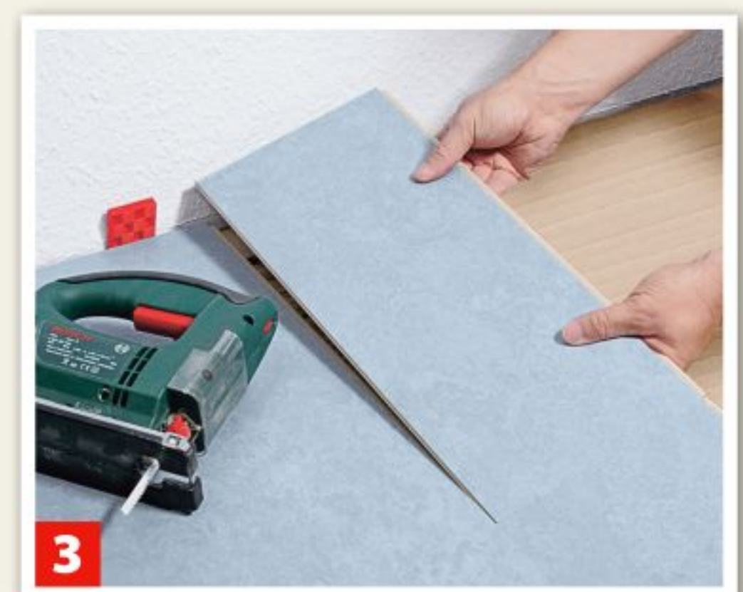
3 Element durchsägen und einhebeln. Längs- und Stirnseiten ...
