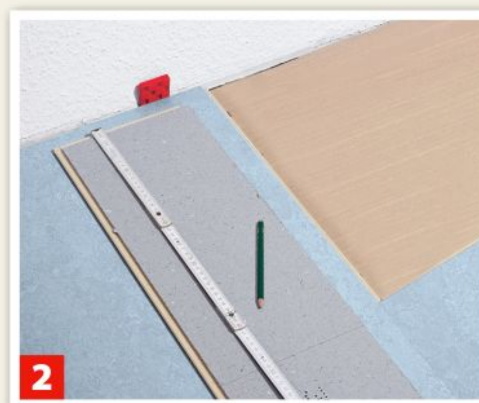
2 ... auch beim Zuschnitt des Reststücks berücksichtigen.
