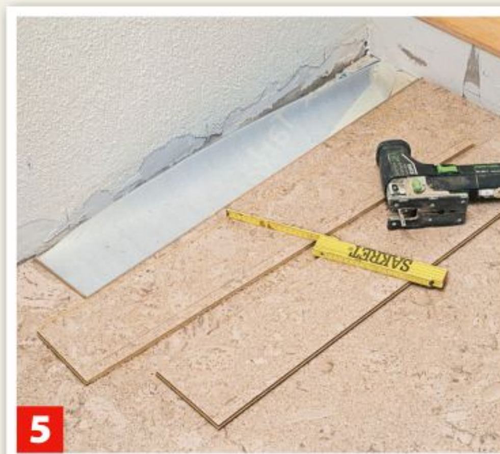
5 Fallen Längsschnitte an, schräge Wandverläufe berücksichtigen.
