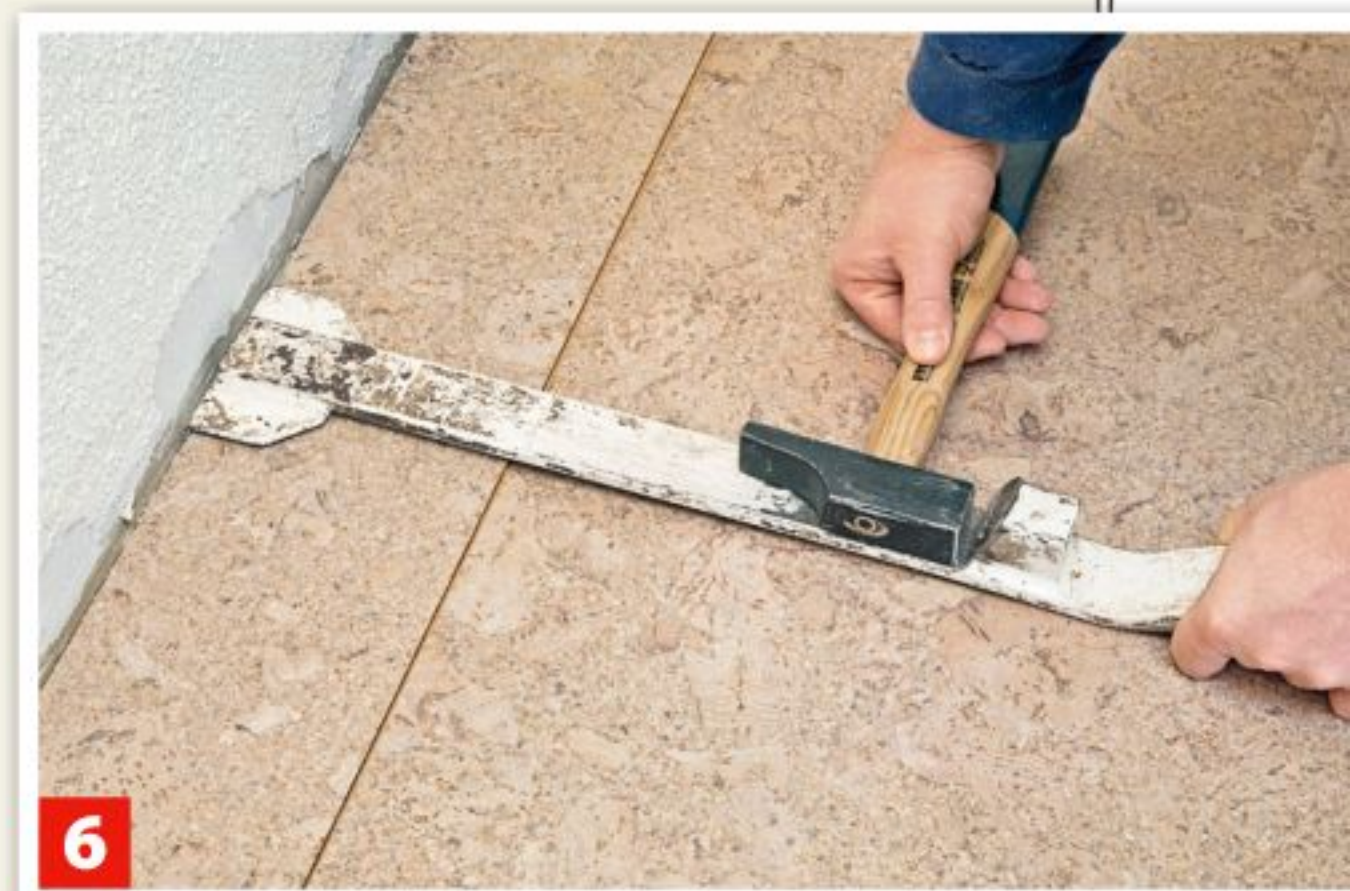
6 Das letzte Element mit Zug-eisen und Hammer einfügen.
