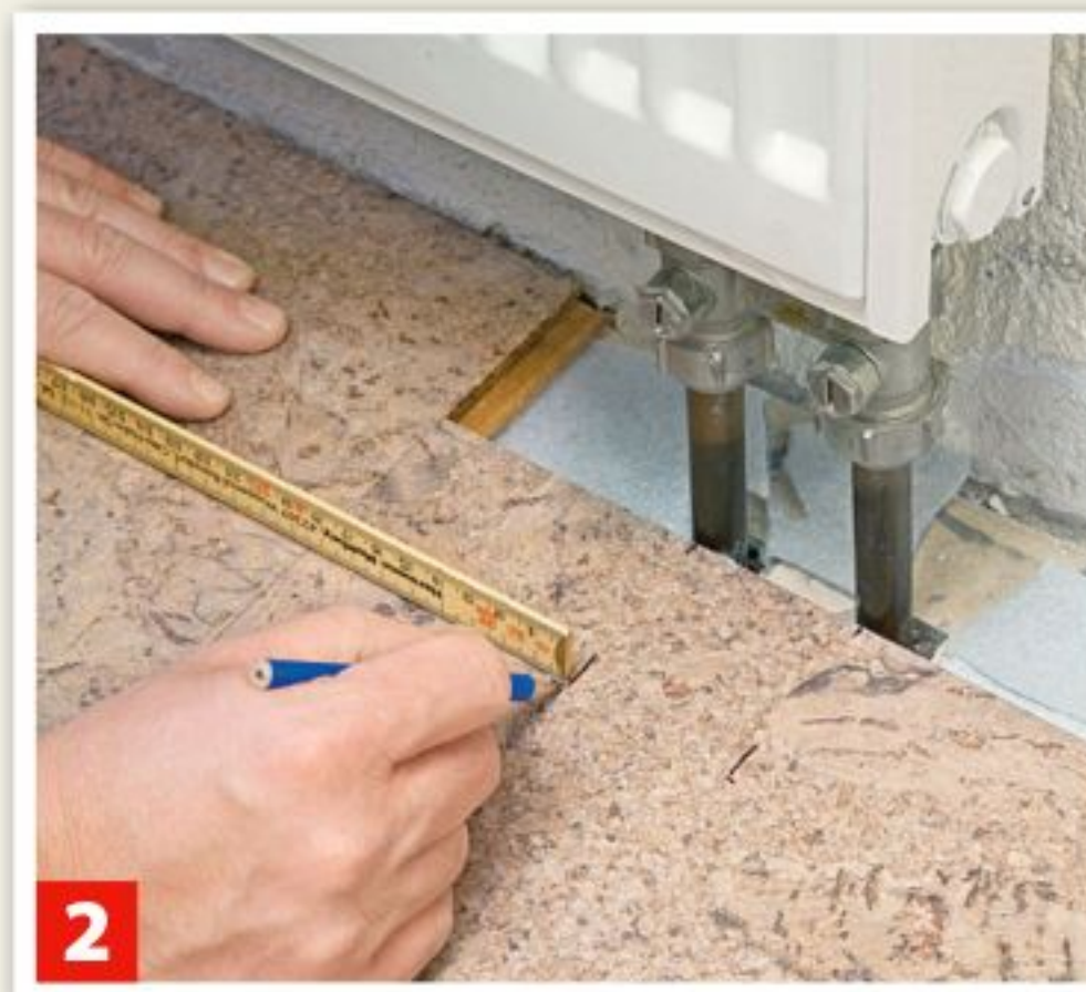
2 An Heizkörperrohren die Rohrposition am Element anzeichnen.
