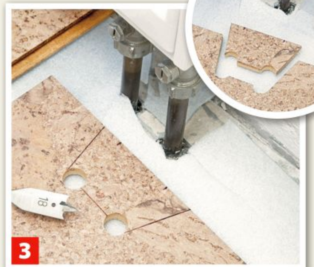
3 Die Löcher bohren und den Abschnitt wie gezeigt aussägen.
