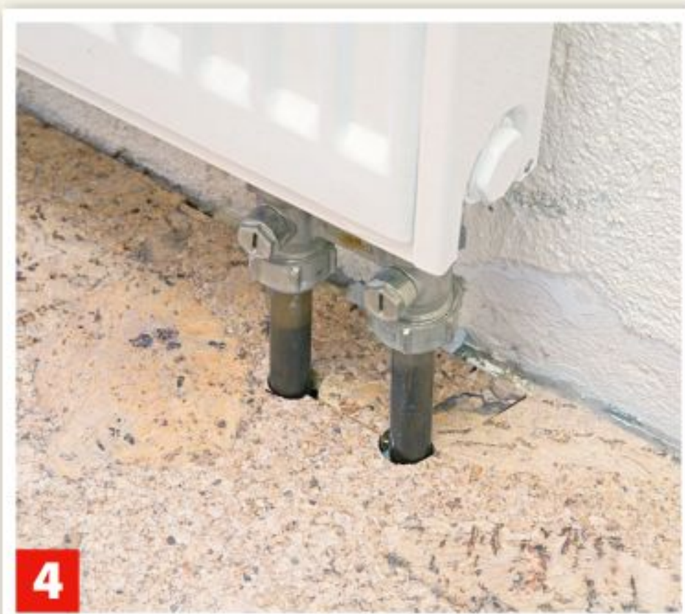
4 Restelement einhebeln, ausgeschnittenen Abschnitt einleimen.
