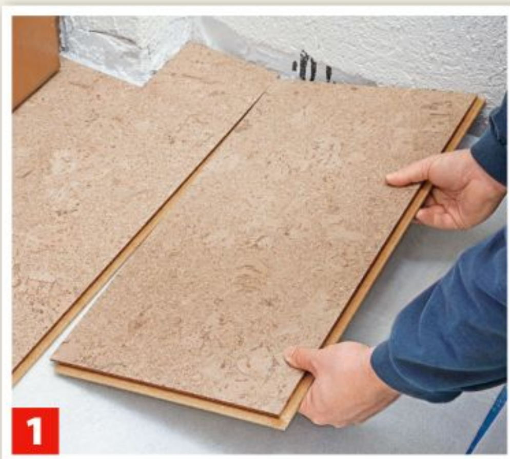
1 Elemente versetzt verlegen; eins sollte nicht kürzer als 30 cm sein.
