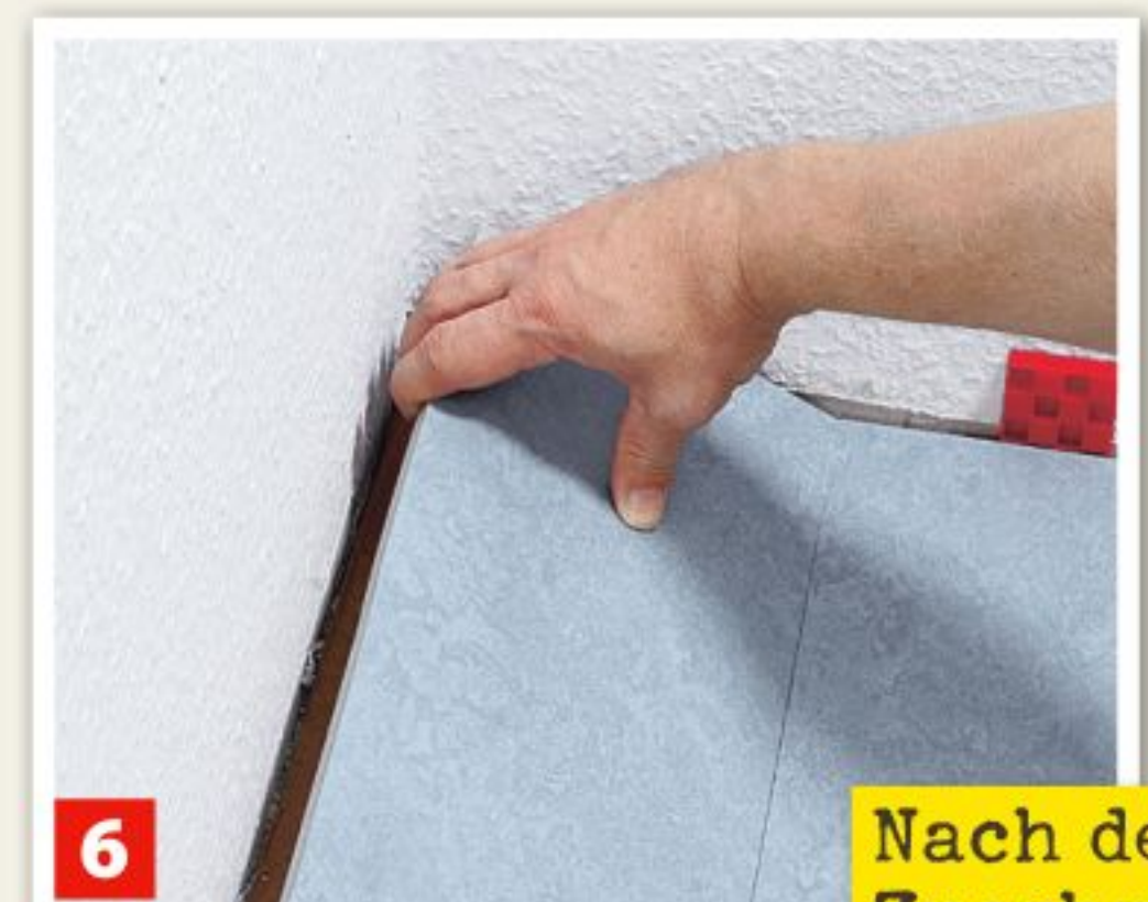
3 Element durchsägen und einhebeln. Längs- und Stirnseiten ...
