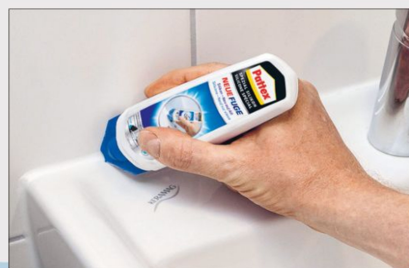
BAUEN Praktisch: Pattex Neue Fuge lässt sich direkt auf die alte Silikonfuge auftragen.
