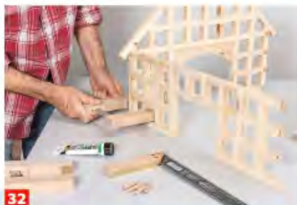
32 Klebstoff angeben und Dübelabschnitte einstecken. Dann Seite für Seite verpressen. Überprüfen Sie dabei die Winkligkeit!
