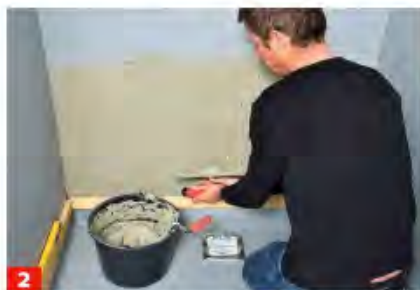
2 Das hat den Vorteil, dass Sie darüber den Fliesenkleber aufziehen und die Fliesen ...
