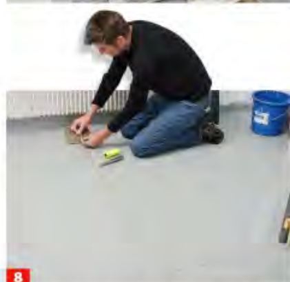
Die Bezugslinie kann man auch durch das Spannen einer Fluchtschnur markieren. Vorteil: Sie liegt über dem aufziehenden Kleber.
