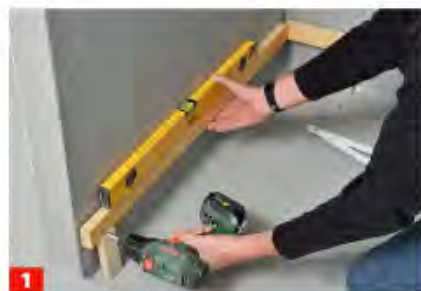
Anhand von Fliesengröße und Fugenbreite Bezugslinie festlegen und markieren. 1) Hier wurde zusätzlich eine Holzleiste montiert.
