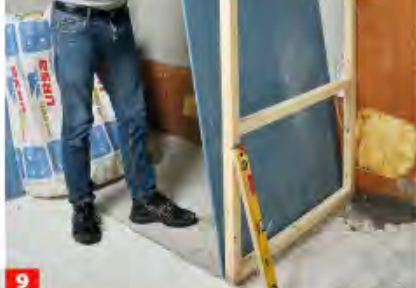
9 Je weniger Fugen, desto dichter: Montieren Sie also ein möglichst großes Plattenformat. Ansonsten 40 cm Plattenversatz vorsehen.
