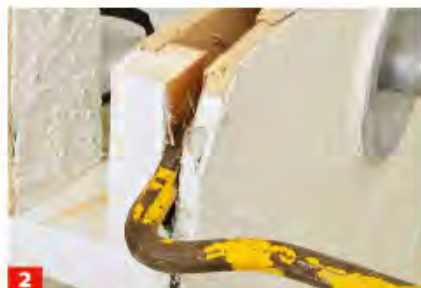
2 So können Sie verschraubtes oder vernageltes Material auseinanderhebeln. Alte Armaturen, Duschstangen etc. vorher demontieren.
