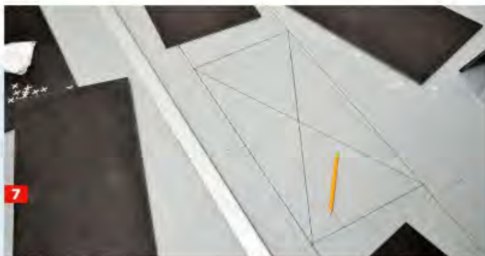
5 Auch am Boden ist Maßarbeit gefragt. Hier können Sie die Fliesen jedoch trocken auslegen und sehr einfach die Markierungen ...
