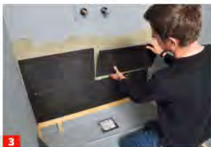
3 ... einlegen können, ohne dass sie abrutschen. Wobei ein guter Flexkleber direkt eine ausreichende Anfangshaftung aufweisen sollte.
