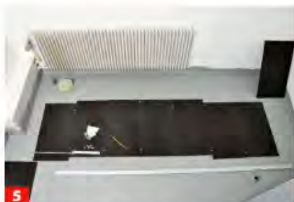
5 Auch am Boden ist Maßarbeit gefragt. Hier können Sie die Fliesen jedoch trocken auslegen und sehr einfach die Markierungen ...
