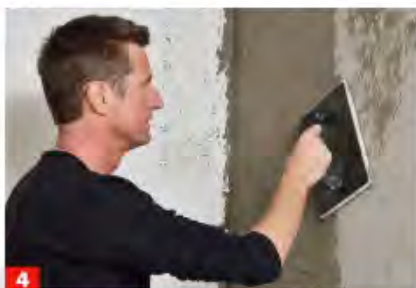
4 Nach dem Abriss ist Platz für Ausbesserungsarbeiten an der Wand – Risse und Hohlstellen mit Zementputz beispachteln.
