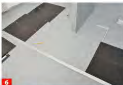
6 ... vornehmen. Die großformatigen Fliesen sollen in voller Breite zum bodengleichen Duschbereich abschließen.
