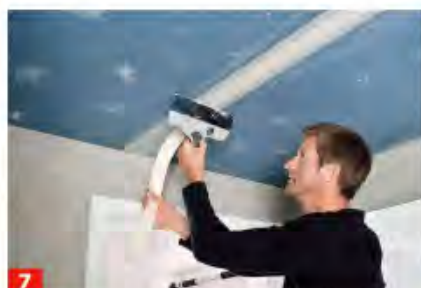
7 Bei geschnittenen Kanten bzw. je nach Spachtelmasse einen Fugendeckstreifen über den Plattenstößen einspachteln.
