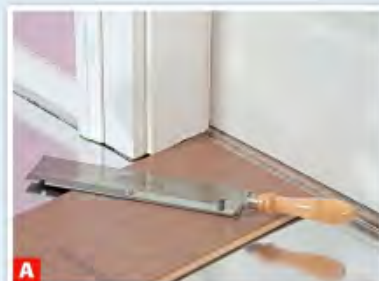
A TÜRZARGEN Mechanisch kürzt man mit Feinsäge mit abgewinkeltem Griff.
