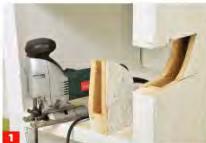
1 Alte Bau- oder Holzplatten lassen sich gut mit einer Säge einschneiden, sodass man Ansatzpunkte für einen Kuhfuß hat.
