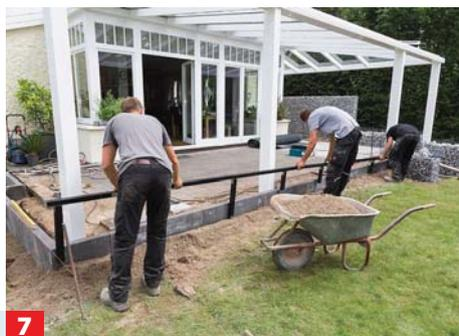
**7** Platzieren Sie nun die Außenelemente der Unterkonstruktion vor den Randsteinen und betonieren diese mit ein.
