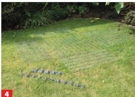
**4** Die Gabionenkörbe werden aus feuerverzinkten Drahtmatten gefertigt.
