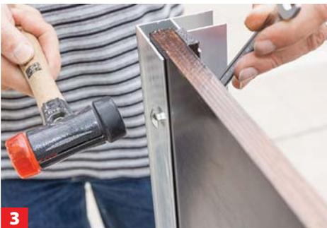
... gesteckt werden können. Schlossschrauben durch passende Bohrung stecken, Vierkant-Verdrehschutz mit einem Schonhammer ...
