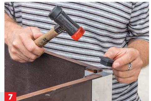
Mit passenden Stopfen die offenliegenden Vierkantrohre der Eckprofile verschließen – sie sind kleiner als die Original-Stopfen.
