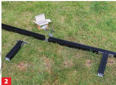
**2** Für die Befestigung der WPC-Terrasse wurde eine Alu-Unterkonstruktion verwendet, deren Elemente nun verschraubt werden.
