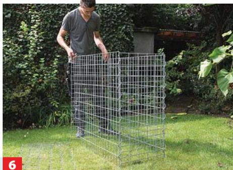
**6** Achten Sie darauf, dass die Ecken der Gabionenkörbe gleichmäßig rechtwinklig ausgerichtet sind.
