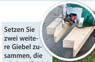
Setzen Sie zwei weitere Giebel zusammen, die mit jeweils einer waagerechten Latta stabilisiert werden. Benutzen Sie den vorderen Giebel als Schablone.
