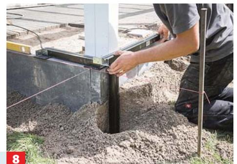
**8** Die innere Profilreihe der Unterkonstruktion (siehe Schritt 9) wird mit Filzmatten auf den Randsteinen platziert.
