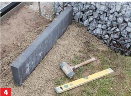
**4** Setzen Sie die Randsteine in den Beton und klopfen sie mit dem Gummihammer fest. Prüfen Sie die Lage mit der Wasserwaage.
