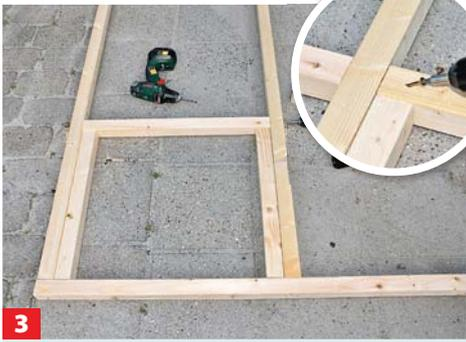
**3** Bilden Sie die beiden Seitenrahmen (ebenfals mit Verkleidungsrahmen im unteren Bereich) und verschrauben Sie diese.
