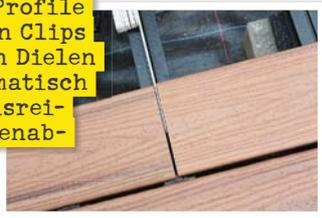
Verlegen Sie nun weitere Dielenreihen parallel zur Hauswand. Die oben herausragenden Abstandhalter werden später entfernt.
