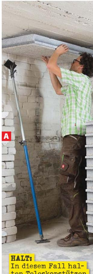
**HALT:** In diesem Fall halten Teleskopstützen die Platten, bis sie verdübelt sind.
