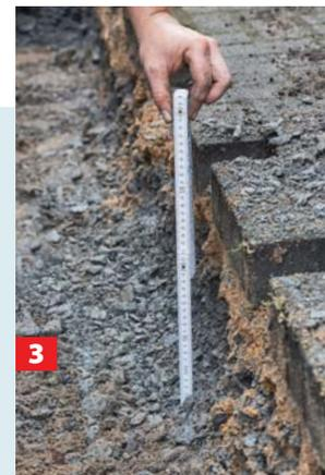
Zwischen Gabionen-Untergrund und Pflaster sollten etwa 30 cm Höhenunterschied liegen. Dort werden später die Gabionenkörbe gesetzt.
