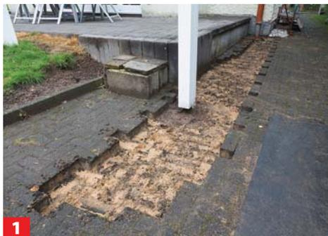
**1** Schaffen Sie eine freie Fläche für die Gabionen. In diesem Fall wurden bereits vorhandene Pflastersteine entfernt.
