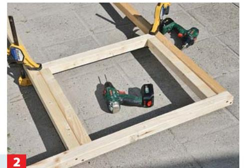
Rechts und links vom Türbereich werden Rahmen für die Sperrholz-Verkleidung im unteren Bereich befestigt.
