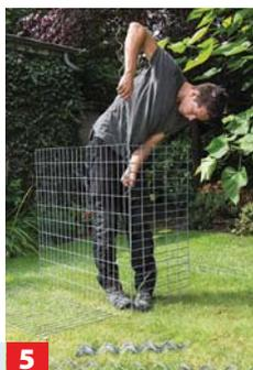
**5** Befestigen Sie die Drahtmatten an den Ecken mit Verbindungsspiralen.
