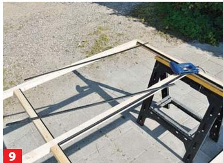
**9** Auf den Innenseiten des Vorder- und der Seitenrahmen werden Falzleisten mit einem Elektrotacker befestigt.
