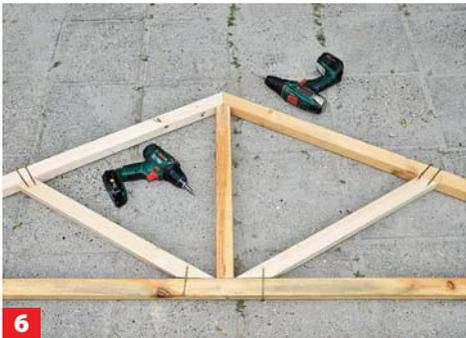
**6** Zur zusätzlichen Stabilisierung werden diagonal zwei Streben auf die hier gezeigte Weise befestigt.
