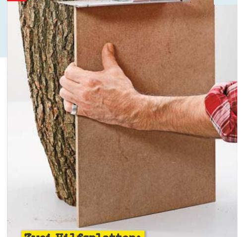
**Zwei Hilfsplatten:** Mit einer großen und einer kleinen rechtwinkligen Platte gelingen beide Schnittmarkierungen exakt parallel!
