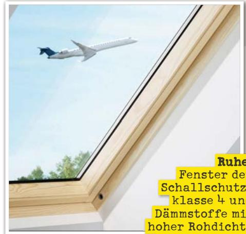
**Ruhe!** Fenster der Schallschutzklasse 4 und Dämmstoffe mit hoher Rohdichte wie Holzfaserplatten sorgen auch unterm Dach für Ruhe.
