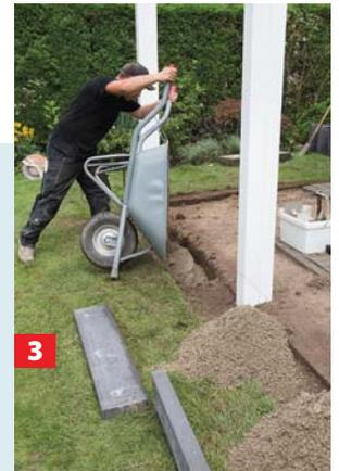
**3** Füllen Sie anschließend die Furche mit Beton aus. Achten Sie darauf, dass Sie die Randsteine verlegen, bevor er getrocknet ist.
