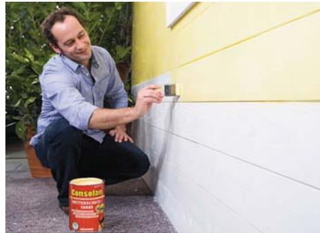
Deckende Farblacke bilden eine stabile, wasserundurchlässige und gleichzeitig optisch ansprechende Schicht.
