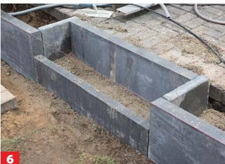
**6** Auf der linken Terrassenseite wurde eine Treppe mit halbierten Randsteinen konstruiert. Die Lücke wird mit Beton gefüllt.
