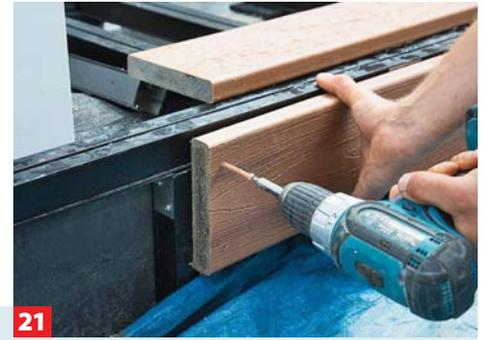
**21** Dort können die Dielen anschließend am Außenrahmen der Unterkonstruktion festgeschraubt werden.
