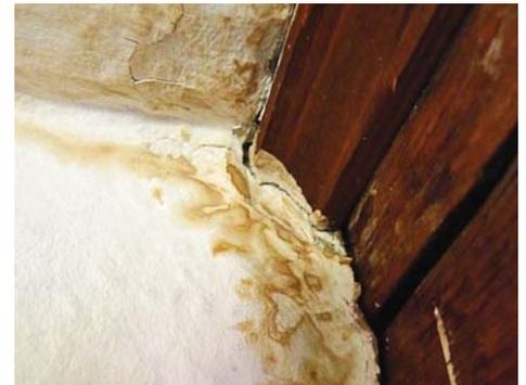
**Hier besteht eine dauerhafte Undichtigkeit, die zügig abgestellt werden sollte.**
