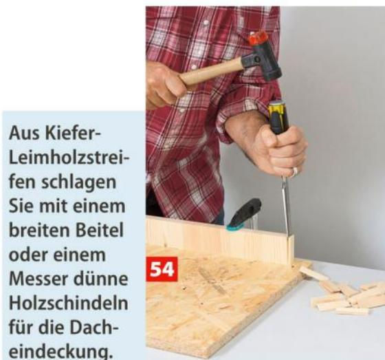
Aus Kiefer-Leimholzstreifen schlagen Sie mit einem breiten Beitel oder einem Messer dünne Holzschindeln für die Dach-eindeckung.
