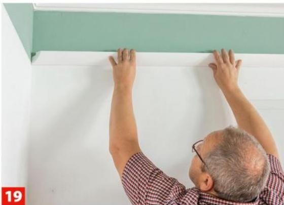
**19** Montageklebstoff an die Kontaktfläche des Profils geben, die Gehrung in der Innenecke anlegen und das Profil gerade ausrichten.
