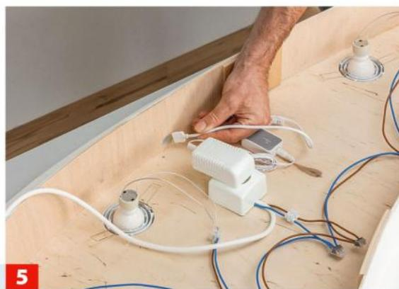
**5** Um den Steckertrafo des Flexbandes anschließen zu können, haben wir im Hohlraum der Abhängung eine Aufputz-Steckdose ...
