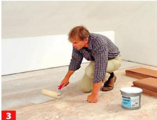
**3** Dann einen Bodenabschnitt für zwei bis drei Reihen bestreichen. Nun muss der Kleber bis zu einer Stunde ablüften.<sup>1)</sup>
