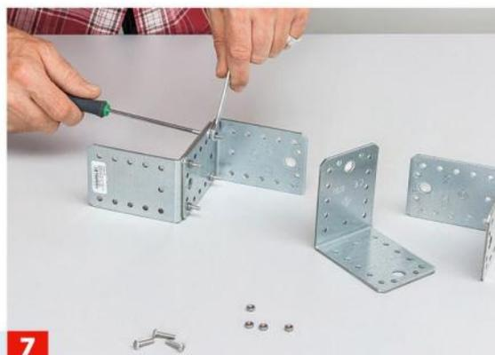
**7** Für den Halt unter der Decke sorgen doppelt verschraubte Bauwinkel. Um die Höhe der Blende zu ermitteln, ...
