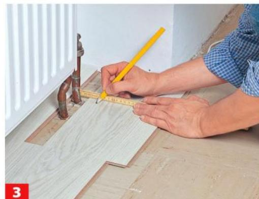
**3** Beim Folgeelement müssen auch die Heizkörperrohre ausgeschnitten werden. Am einfachsten ist es, Sie ...
