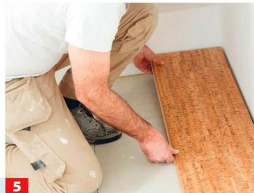
**5** ... darf es nicht für die nächste Reihe verwendet werden! Das zugeschnittene letzte Element einfügen.
