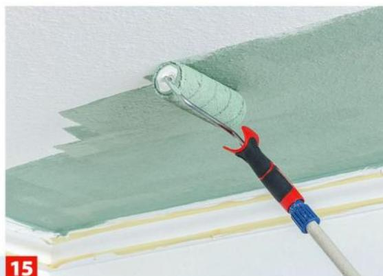
Anschließend mit der Farbrolle vom Fenster bzw. vom Haupt-Lichteinfall weg die Decke rollen. Ggf. sind zwei Aufträge erforderlich.
