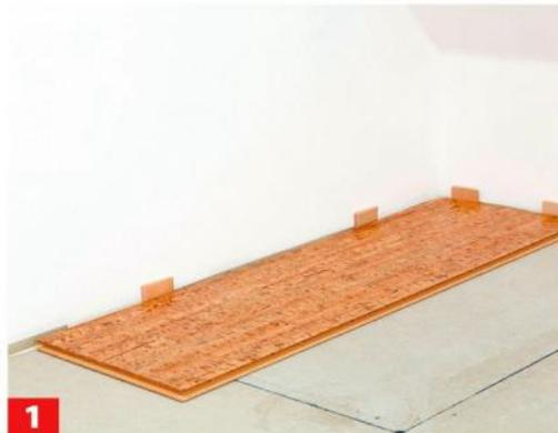
**1** In einer Raumecke beginnen, Federseite zur Wand. Setzen Sie Abstandsklötze, die eine Dehnungsfuge von 10 mm ...
