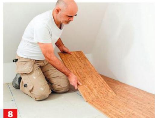
**8** ... Elemente setzt man stirnseitig schräg an und legt sie längs auf die Verriegelungsseite der verlegten Elemente ab.
