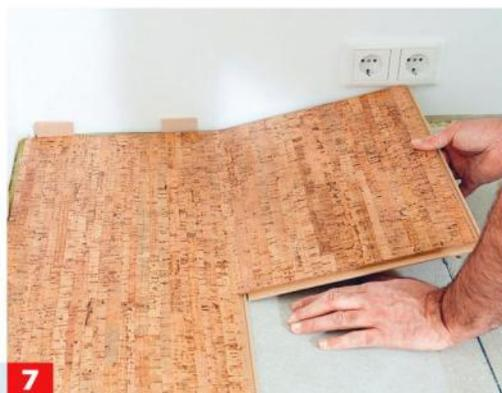
**7** Es wird dann längs genauso wie stirnseitig an Reihe eins schräg angesetzt und nach unten gedrückt. Die folgenden ...
