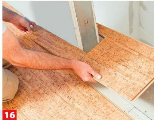
**16** Dehnungsfuge beim Zuschnitt berücksichtigen und Element einfügen. Auch Dehnungsfugen im Estrich übertragen ...
