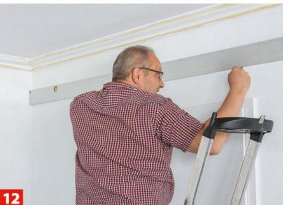
Jetzt die Lage des Lichtprofils (hier die Oberkante der Profil-Klebefläche) mit einer Wasserwaage anzeichnen. Unterhalb der ...
