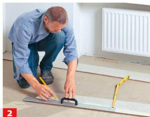
**2** Hier folgt direkt die Heizkörpernische. Restabstand zur Wand ausmessen und abzüglich Dehnungsfuge übertragen.
