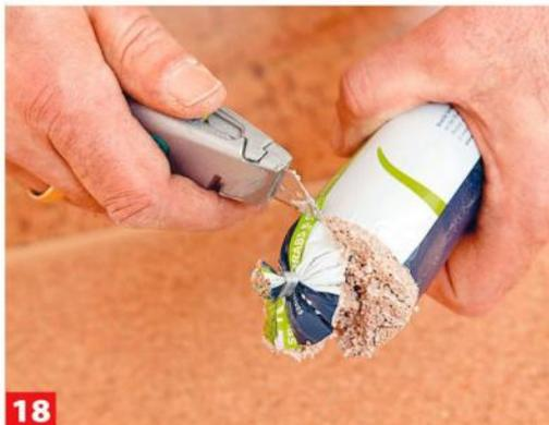
**18** Die Anschlussfugen zum Schornstein und Holzbalken kann man mit Spritzkork ausfüllen. Dazu Schlauchbeutel ...
