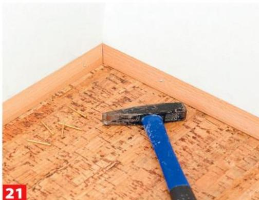
**21** Die Dehnungsfugen zur Wand überdecken Sockelleisten, die man im Eckbereich auf Gehrung sägen muss.
