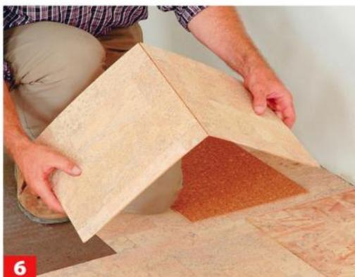
**6** ... geraden Linie (benutzen Sie Schiene/Lineal und schnittfeste Unterlage!) und brechen das Material dann durch.
