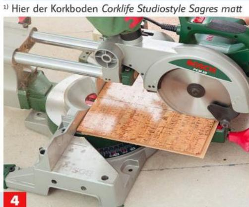
**4** ... Element von Reihe eins entsprechend kürzen. Das Reststück ist hier für den Müll, da es kürzer als 30 cm ausfällt, ...
