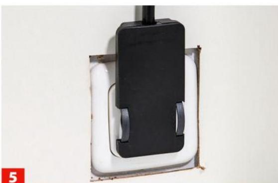
**5** Den beiliegenden Flachstecker montieren
