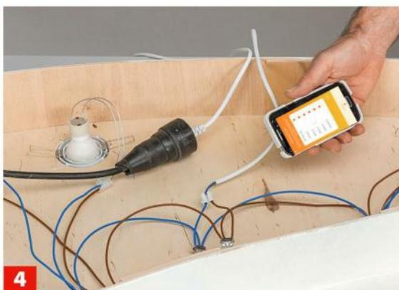
**4** ... Stecker montiert. Beim Anlernen wird die Stromversorgung kurz unterbrochen, um die Erkennung neuer Geräte zu aktivieren.
