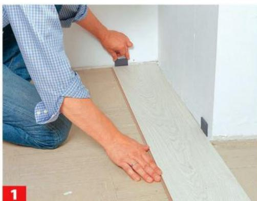
**1** Die Verlegung in einer linken Raumecke beginnen<sup>2)</sup>, Federseite und 10 mm Dehnungsfuge Richtung Wand.
