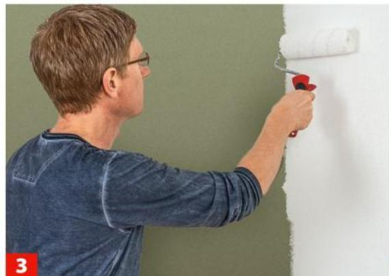
**3** Die Farbe danach von oben nach unten verschlichten. Auf Grund der Dickflüssigkeit die Farbe am Abstreifgitter sorgfältig abrollen.
