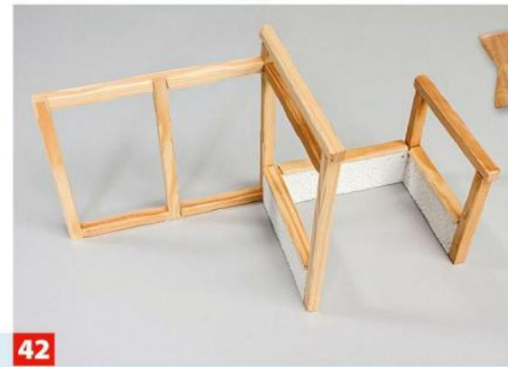
**42** ... Schuppens an den bereits vorhandenen angebaut. Die Putzplatten werden anschließend oben mit Leisten abgedeckt.
