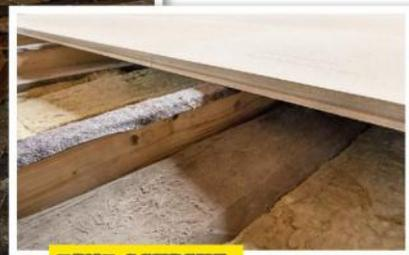
**EINE SCHICHT:** Das neue Gipsfaser-Plattensystem kann einschichtig auf Holzbalkendecken verlegt werden – mit Auflagedämmstreifen auf den Balken und Randdämmstreifen in Richtung Wand.
