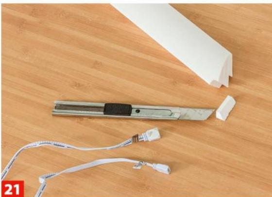
**21** Klinken Sie hierzu die Innenkante der Gehrung soweit aus, dass sich die Anschlussstecker der Zuleitungen durchführen lassen.
