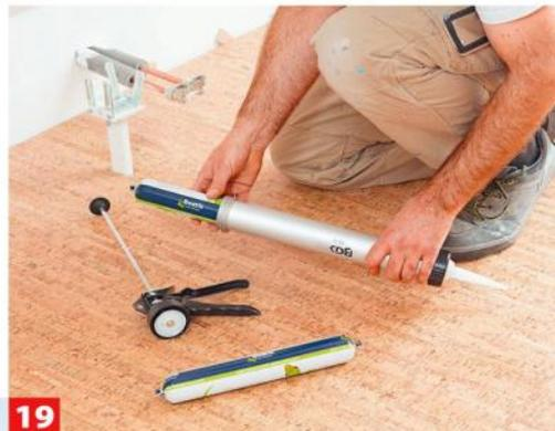
**19** ... aufschneiden und ihn in eine Schlauchbeutel pistole schieben.
