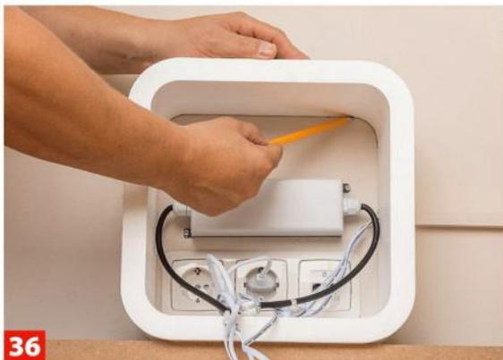
**36** Installieren Sie die Lichttechnik (Trafo anschrauben) und markieren Sie die Position des Regalkastens.
