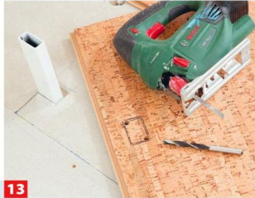
**13** Ausschnitt markieren und in zwei Eckpunkten Bohrungen setzen, um mit dem Stichsägeblatt den Ausschnitt ...
