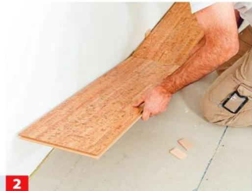
**2** ... zur Wand sicherstellen. Die nächsten Elemente der ersten Reihe stirnseitig schräg ansetzen und herunterdrücken.
