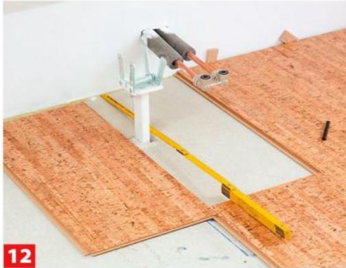
**12** An Heizkörpern bzw. den Stützen (hier vor der Heizkörpermontage) sind kleinere Einschnitte im Element nötig.
