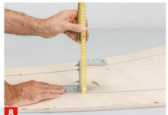
**8** ... einen verschraubten Doppelwinkel auf die Abhängung stellen und die Höhe bis in die Haltenut hinein ermitteln.
