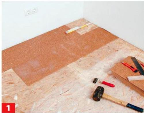
**1** Die Verlegung beginnt an einer geraden Wand oder – wenn nicht vorhanden – an einer gerade angezeichneten Linie.
