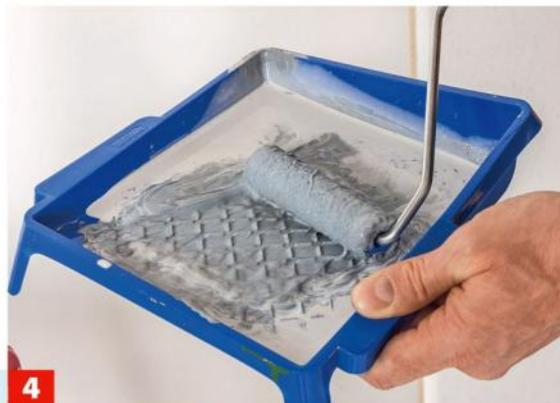
**4** Verwenden Sie am besten eine kleine Farbrolle und keinen Pinsel, da der Auftrag so gleichmäßiger gelingt. Skizzieren Sie den ...
