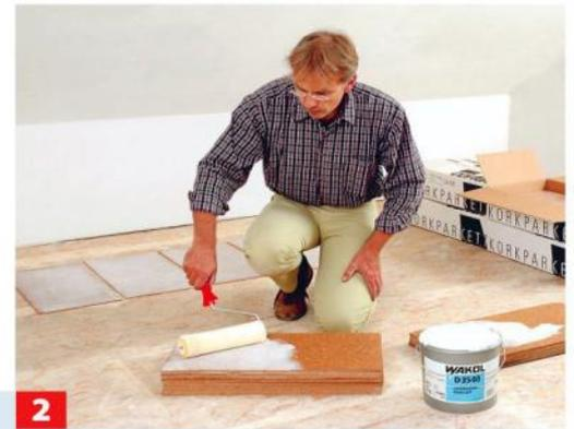
**2** Der Kontaktkleber wird beidseitig aufgetragen. Bestreichen Sie am besten erst die Plattenrückseite.
