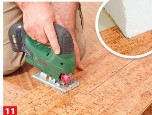
**11** Mit der Stichsäge lassen sich kleine und winklige Zuschnitte gut durchführen. Zugeschnittenes Element einfügen.
