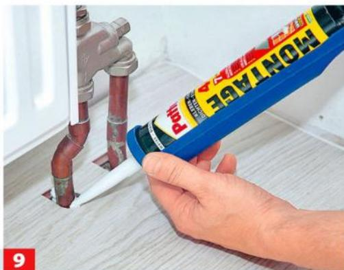
**9** Hohlstellen um Heizungsrohre mit hitzebeständigem Silikon oder elastisch eingestelltem Montagekleber verschließen.
