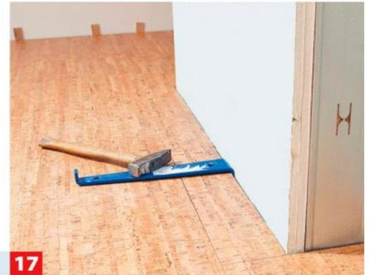
**17** ... und ggf. Profil setzen oder elastisch ausfügen. Beim Einfügen der Elemente helfen Zügeisen und Hammer.
