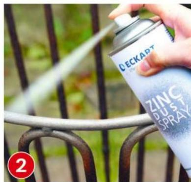
**2** Sorgen Sie mit ECKART Zinkstaubgrundspray als Grundierung für optimalen Rostschutz: Schütteln Sie die Dose kräftig, bis Sie die Mischkugel hören. Sprühen Sie das Spray dann aus ca. 25-30 cm Entfernung gleichmäßig über Kreuz auf (bei 18-25°C). Die Grundierung ist schon nach 30 Min. trocken, aber noch nicht abriebfest. Nach ca. 12 Std. ist sie durchgehärtet.
