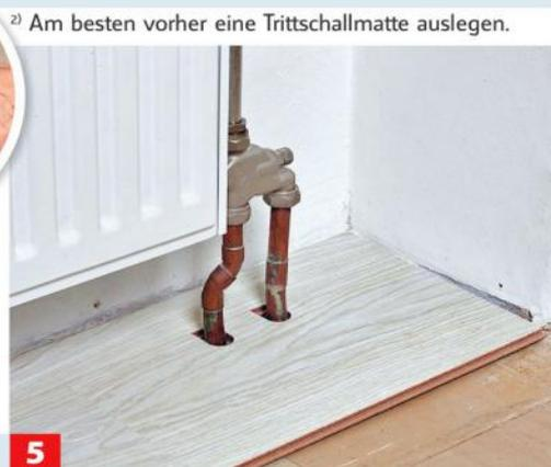
**5** ... Element einfach von vorne einschwenken.<sup>3)</sup> Berücksichtigen Sie auch rund um die Rohre 10 mm Dehnungsfuge!
