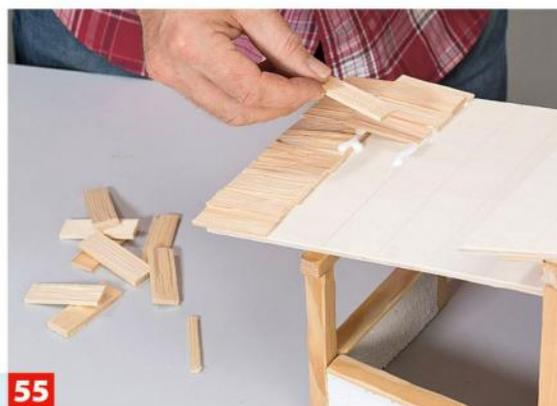
**55** Reißen Sie die parallelen Schindelreihen auf das Sperrholz und leimen Sie die Schindeln von unten nach oben im Halbversatz auf.
