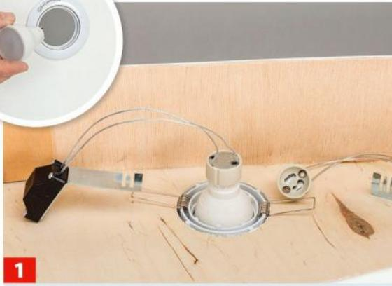
**1** Die Ledvance-Spots werden einfach in den Fassungen montiert und können direkt mit der Stromversorgung verbunden werden.
