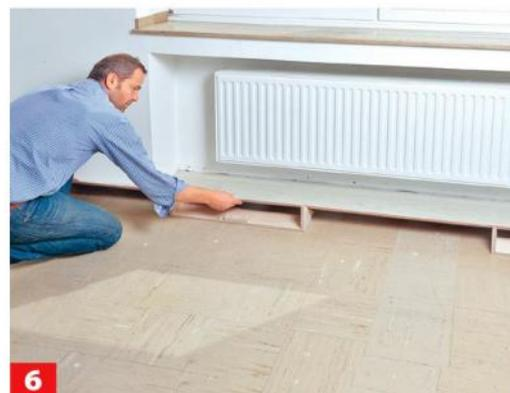
**6** Die erste, abgerückte lange Reihe nun komplett längsseitig in die in der Heizkörpernische verlegte Reihe einhebeln.
