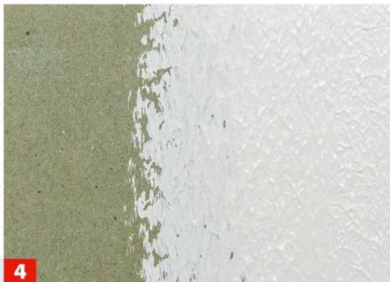
**4** Sie deckt sehr gut! **Wichtig:** Unbeschichtete Gipsplatten, die länger der Sonne ausgesetzt waren, besser mit Sperrgrund vorbehandeln.<sup>1)</sup>
