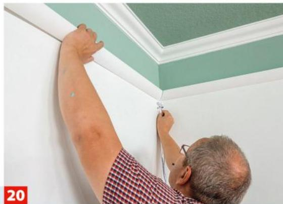
**20** In der Ecke, in der der Anschluss der LED-Strips erfolgt, müssen Sie die Gehrung des Profils für die Anschlussleitung bearbeiten.
