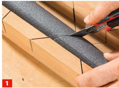
**1** Da für dieses Vorhaben sehr genaue Einschnitte in die Rohrschale benötigt werden, verwenden Sie eine Gehrungslade.
