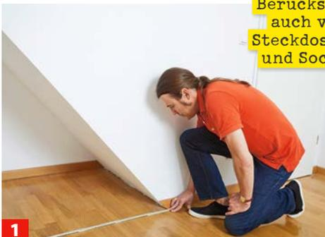
Messen Sie die Nische sehr genau aus. Auch mit der Wasserwaage prüfen, ob eventuell Unebenheiten oder Wellen vorhanden sind.
