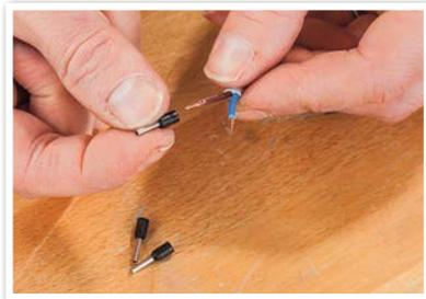
Die zum Adern-Durchmesser passende Hülse aufstecken, in die ...
