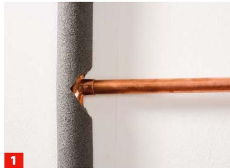
**1** Trennen Sie ein 90-Grad-Stück aus der Schale bis zur Mitte heraus, sodass die Abzweigung frei liegt.
