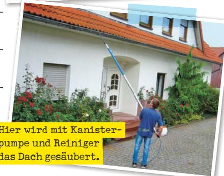
Hier wird mit Kanisterpumpe und Reiniger das Dach gesäubert.
