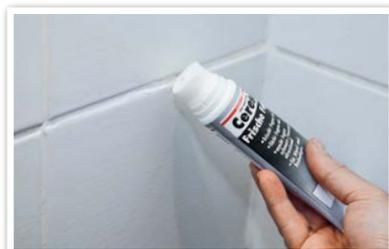
Mit der Schwammtube bestreicht man die komplette Fugenbreite.
