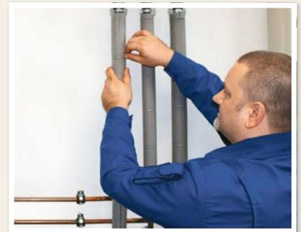
Schäden durch Schimmelbefall bei Tauwasserbildung lassen sich durch eine Rohrdämmung vermeiden.
