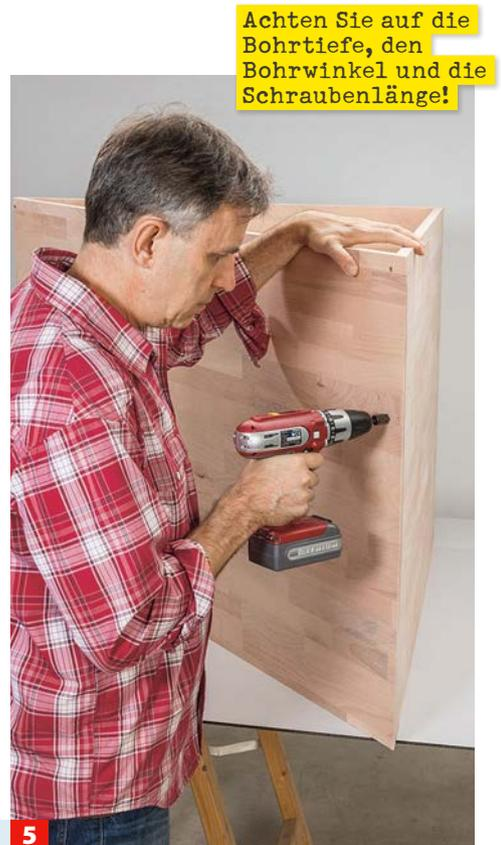
**5** Die Schrägwand wird nun vor dem Winkel positioniert, exakt ausgerichtet, vorgebohrt, gesenkt und verschraubt.
