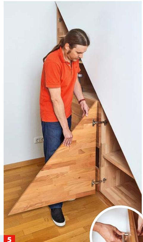
**5** ... die Türen einklipsen und die zum Ölen demontierten Griffe wieder anschrauben.
