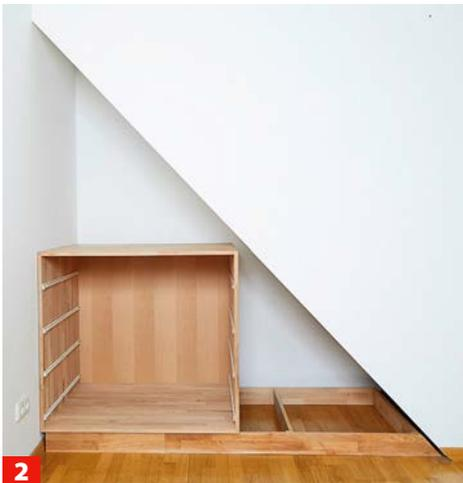
**2** Jetzt stellen Sie den Korpus des Schubkastenmoduls auf. Auf dem Sockel ausrichten, so dass der Sockel gleichmäßig zurückspringt!
