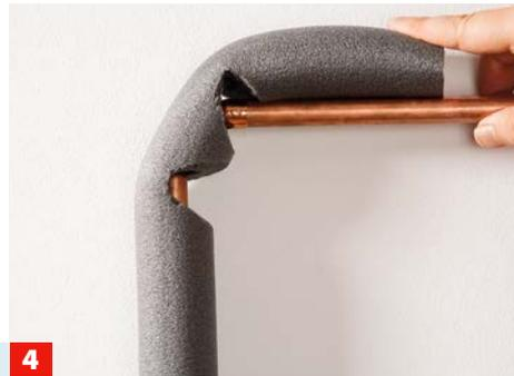
**4** Stülpen Sie die Schale über den Rohrbogen und drücken Sie sie zusammen. Dichten Sie die Stöße mit Klebeband ab.
