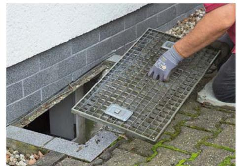
**ROST IN KETTEN** Ob mit Schiene oder variabler Kette, Gitterrostsicherungen verhindern den Lichtschacht-Einstieg.
