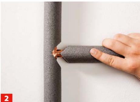
**2** Spitzen Sie eine weitere Schale so mit zwei 45-Grad-Schnitten zu, dass sie genau in die Lücke passt und abgedichtet werden kann.
