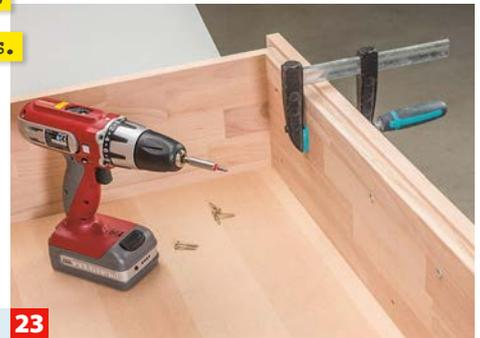
**23** Danach von innen Schubkastenfront und die Blenden mit Spanplattenschrauben zusätzlich verschrauben.
