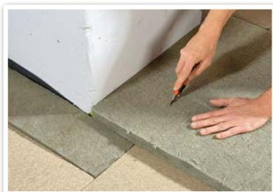
Auf dieses Maß schneiden Sie den nichtbrennbaren Dämmstoff zu ...
