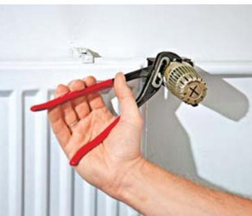
Packen Sie mit der Rohrzan-ge die Rändel-mutter am Kopf.
