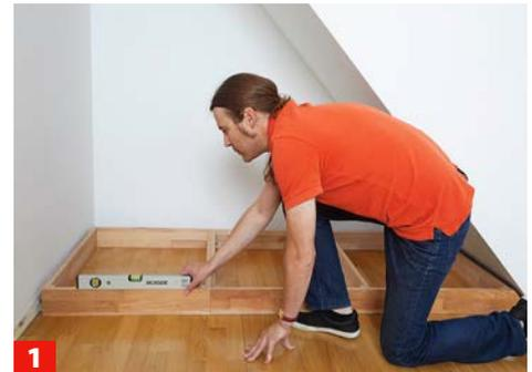
**1** Schieben Sie den Sockel in die Nische. Mit der Wasserwaage prüfen Sie, ob er waagrecht steht. Ggf. mit Zulagen unterfütern!
