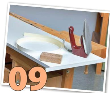
Das muss natürlich nicht so bleiben, denn für die Schnittkanten gibt es passende Umleimer. In der Regel sind sie auf der Rückseite mit Schmelzkleber versehen. Deshalb benötigt man zum Anbringen ein Bügeleisen. Damit erhitzt man den auf die Kante aufgelegten Streifen und
