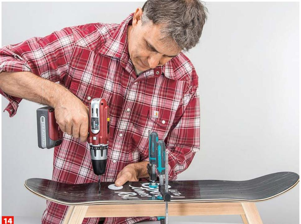
**14** Legen Sie nun das Skateboard mittig auf und durchbohren Sie durch die vorhandenen Montagelöcher die darunter liegenden Auflageplatten.
