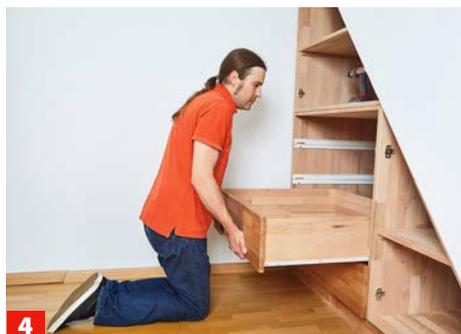
**4** Setzen Sie die Zwischenschienen und führen die Schubkästen ein. Anschließend ...
