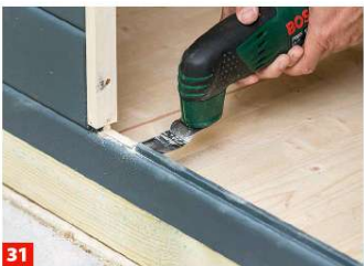
31 Entfernen Sie die Feder im Türbereich, um anschließend die Metallschiene der Tür befestigen zu können.
