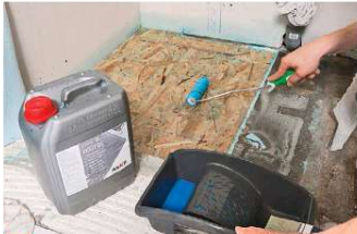
1 Das Duschelement wird mit Fliesenkleber verklebt. Dazu die Fläche darunter, hier OSB-Platten, mit Tiefengrund streichen.
