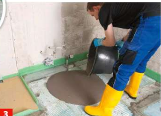
3 ... handlichen Kübel, um die Masse zügig in einem Arbeitsgang ausschütten zu können. Bei großen Schichtstärken zu zweit arbeiten!
