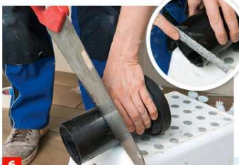
6 ... zwischen den beiden Markierungen plus 3 mm Zugabe gekürzt werden. Entgraten Sie die Schnittkanten mit einer Feile.
