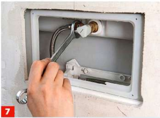
7 ... der Betätigungsplatte. Nun noch die Zuleitung an den Spülkasten anschließen, hier einfach verschraubt mittels Flexschlauch.
