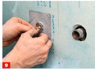
9 ... Ausgänge kleben zu können, musste der Ausschnitt etwas vergrößert werden.
