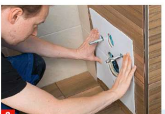
8 Schallschutzmatte fürs WC über die Gewindestangen an die Wand drücken.
