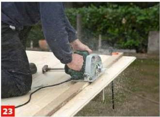
23 Passen Sie das letzte Brett mit der Handkreissäge entlang einer Führungsschiene auf die richtige Breite an.
