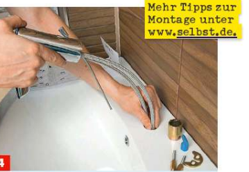
4 ... von oben durch das Loch führen und darunter an die Eckventile schrauben, die mit den Wandausgängen verschraubt sind.
