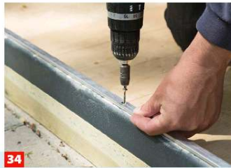
34 Schrauben Sie die Metallschiene an der Trittleiste fest. Anschließend können Sie die Türen am Rahmen einhängen.
