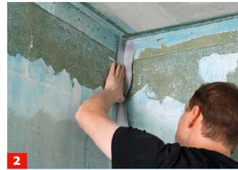
2 Als Erstes verkleben Sie dann das Dichtungsband in allen Eckbereichen und auf allen Anschlussfugen.
