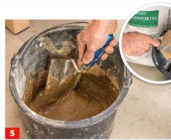
5 Den Zellulose stabilisierenden, sehr druckfesten Claytec Lehmklebe- und Armierungsmörtel mit Wasser anrühren.
