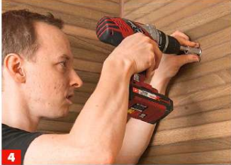
4 ... der Armatur und an einer Aufhängung befestigt. Diese wird entsprechend der Montageanleitung in der Wand verdrübelt.
