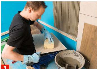
3 Die Fliesenrückseiten sind oft mit weißen Pulverrückständen bedeckt, die wie ein Trennfilm wirken und abgewischt werden sollten.
