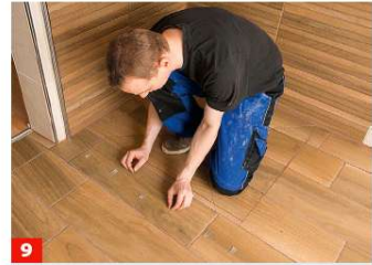
9 Bevor Sie das Glaselement in das Profil schieben, legen Sie als Rutschschutz und Abstandhalter 2) Gummistücke/Pappe aus.
