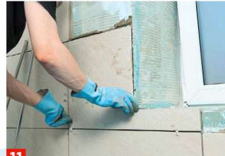
11 Die zugeschnittene Fliese bis an die Fugenkreuze heransetzen. An der Kante Richtung Laibung wieder Fliesenprofile einplanen!
