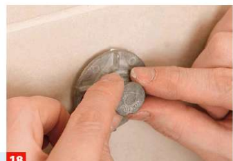
18 Drücken Sie den Sockel direkt danach an die gewünschte Position an der Wand.
