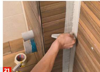
21 Ein Abziehkeil aus Kunststoff ermöglicht sauberes Glätten. Halten Sie ein Tuch bereit, um überschüssiges Silikon aufzunehmen.
