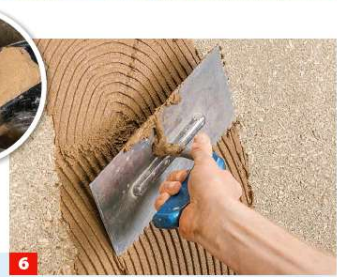
6 Diesen dann in 3 mm Stärke auf die staubfreien Platten aufziehen, Fugen und Schraublochvertiefungen ausspachteln.
