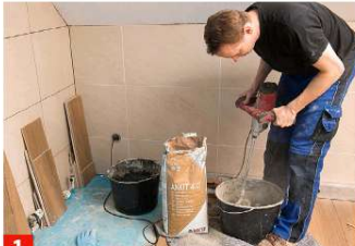
1 Fliesenkleber mit Wasser und langsam laufendem Rührwerk rund drei Minuten anrühren. Bevor Sie ihn aufziehen, anhand von ...
