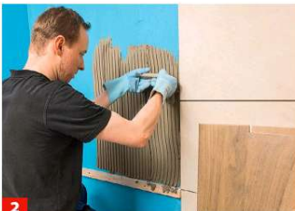
2 ... Raumgröße und Fliesenformat sinnvolle Bezugslinien festlegen und markieren, hier durch provisorisch verschraubte Leisten. 1)
