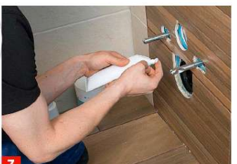
7 Dichtungen aufstecken und Rohrenden sowie Wandausgänge mit Rohrgleitmittel bestreichen.
