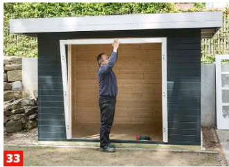
33 Der zusammengesetzte Holzrahmen wird nun aufgerichtet und im Türausschnitt befestigt.
