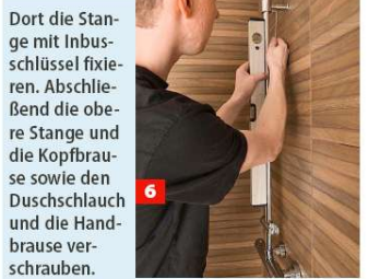
6 Dort die Stange mit Inbusschlüssel fixieren. Abschließend die obere Stange und die Kopfbrause sowie den Duschschlauch und die Handbrause verschrauben.
