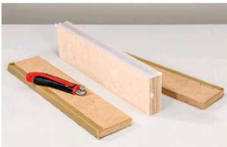
11 Nach dem Aushärten des Silikons entfernen Sie die Zulagen. Ggf. behutsam mit einem Cuttermesser anschneiden.
