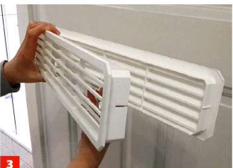
3 Die neuen, gleichfalls zweiteiligen Türgitter sahen nicht exakt gleich aus, passten aber wieder in die Lüftungsausschnitte. 1)
