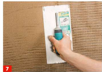
7 In die noch nasse Oberfläche der Putzlage Claytec Flachsgewebe flächig einarbeiten.
