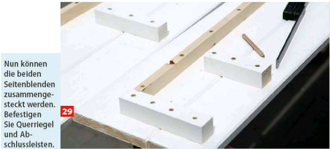
An beiden Seiten des Gartenhauses kann man nun auch die Seitenblenden festschrauben.
