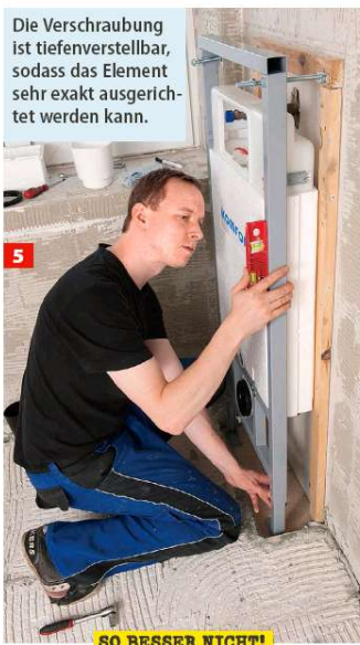
3 Damit das Vorwandelement die versprochenen 400 kg Tragkraft aufweist, muss es fest verankert sein. In Leichtbauwänden ...
