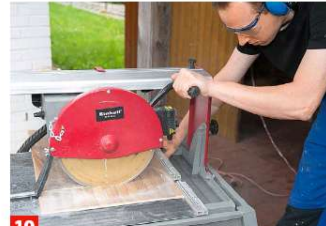
10 Längsschnitte gelingen besonders einfach mit elektrischem Nassschneider. Alternativ geht es auch mit Fliesenschneidemaschine.
