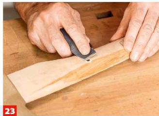
23 Für eine etwas großflächigere Leim-Kontaktstelle entfernen Sie behutsam den Klarlack an den Löchern der Axtstiele.
