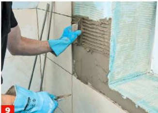
9 Den Fliesenkleber immer erst dünn aufziehen und dann mit Zahnkelle im Anstellwinkel von 45 bis 60 Grad durchkämmen.
