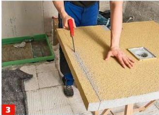
3 Bei Bedarf lässt sich das Hartschaumelement mit einer Säge etwas kürzen (bis auf 900 x 700 mm; gleichfalls erweiterbar auf 1500 mm).
