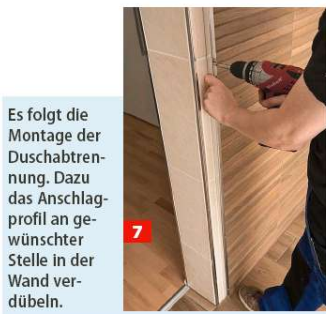
7 Es folgt die Montage der Duschabtrennung. Dazu das Anschlagprofil an gewünschter Stelle in der Wand verdrübeln.
