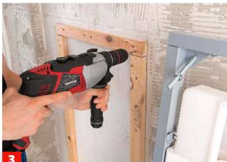
3 Damit das Vorwandelement die versprochenen 400 kg Tragkraft aufweist, muss es fest verankert sein. In Leichtbauwänden ...
