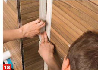
18 Sind alle Flächen verfugt, folgen nach rund 12 Stunden die Anschlussfugen. Dazu die Randbereiche mit Kreppband abkleben.
