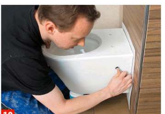
10 Durch die Löcher rechts und links das WC mit beiliegendem Inbusschlüssel festziehen und dann die Blindkappen aufstecken.
