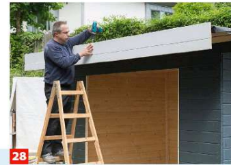
28 Richten Sie das Blendenelement waagrecht an der Dachkante aus und schrauben Sie es von oben fest.
