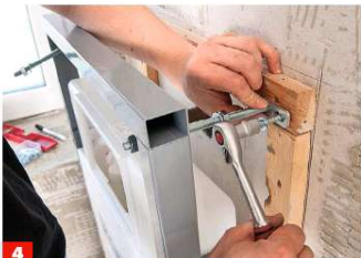
4 ... empfiehlt sich eine Unterkonstruktion aus Holzlaten, durch die hindurch Sie das Vorwandelement verschrauben.
