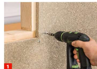
1 Die Platten mit wenigstens 25 cm Versatz dichtgestoßen an einer Unterkonstruktion aus Holz oder Metallprofilen befestigen. 1)
