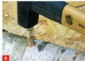
Schlagen Sie die Dübel behutsam bündig in den Stamm. Bei älteren, durch den Pilz brüchigen Dübeln ggf. 9-mm-Löcher bohren.
