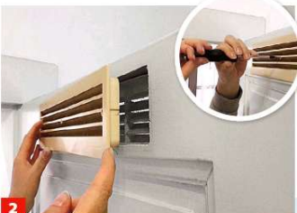
2 Anlass genug, die verstaubten, vergilbten Gitter an den drei Schrauben zu lösen und beidseits oben und unten abzunehmen.
