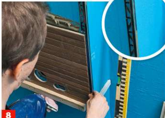
8 ... und Fliesenhammer. Die Fliese danach wie gehabt über den Rohrausgängen verkleben. An Kanten stets Fliesenprofile setzen!
