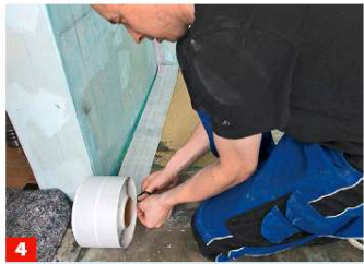
4 Dichtbandanschlüsse überlappend verkleben und das Band entsprechend ablängen.
