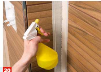
20 Um das Silikon geschmeidig glatt abziehen zu können, sprüht man es ein bisschen mit Wasser und Spülmittel ein.
