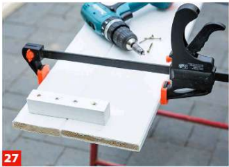
27 Die Bohlen für das vordere Blendenelement werden zusammengesteckt. Dann werden die Querriegel angeschraubt.
