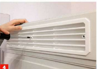
4 Die übereinandergreifenden Gitterteile von beiden Seiten in die Ausschnitte stecken und an den vorgesehenen Stellen verschrauben.
