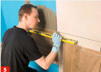
5 Für gleichmäßige Fugenabstände am besten Fugenkreuze setzen. Kontrollieren Sie auch die vertikale Ausrichtung der Fliesen.
