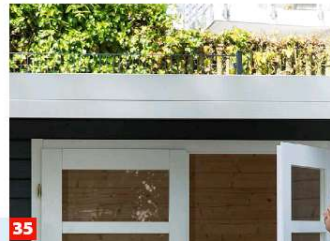
35 Die Türen sollten nicht zur Wetterseite des Gartens ausgerichtet werden, da sie sonst von der Witterung als erstes angegriffen werden.
