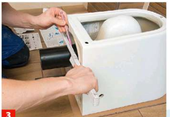
3 Spül- und Ablaufrohr hinten ins WC stecken und bündig zur WC-Rückseite eine Markierung vornehmen.
