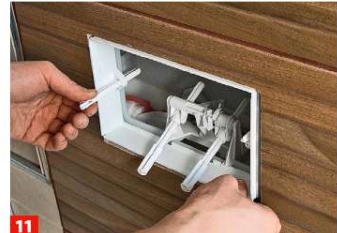
11 Bowdenzugeinheit einstecken; sie verbindet die Betätigungsplatte mit dem Ablaufventil.
