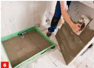
6 Kämmen Sie den Kleber mit einer Zahnkelle auf den Untergrund und auf die Elementrückseite auf.
