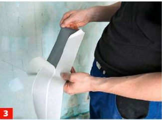
3 Das Dichtband hat eine mit Butylkautschuk beschichtete Polypropylenoberseite, die mit überlappendem Silikonpapier abgedeckt ist.
