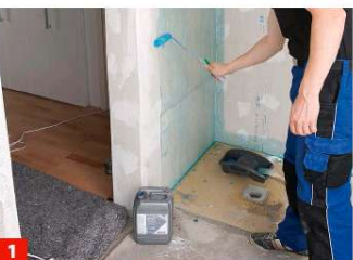
1 Unser Bauherr grundierte zunächst noch die Gipsfaserplatten, was die Haftfestigkeit dieses saugenden Untergrundes verbessert.
