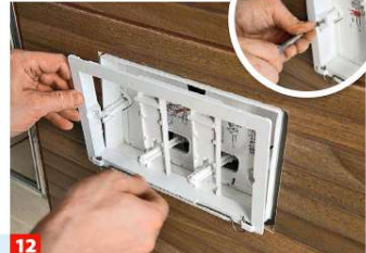
12 Den Rahmen der Drückerplatte aufstecken und mit dem Vorwandelement verschrauben.
