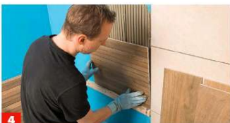
4 Die Fliese an der Bezugslinie anlegen und mit gewünschtem Fugenabstand (hier nach rechts) ins Mörtelbett „einreiben“.
