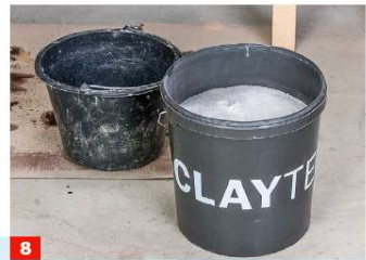
8 Es folgt ein feiner Lehmoberputz. Diesen ebenfalls mit Wasser klumpenfrei anrühren.
