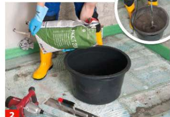
2 Für eine fließfähige Konsistenz rühren Sie den Trockenmörtel mit 5 l Wasser an. Nehmen Sie einen ausreichend großen, aber ...
