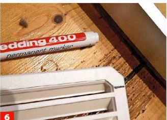
6 Nehmen Sie entsprechende Markierungen am neuen Türgitter vor. Türform und Höhe des Trockenestrichs bestimmen die Maße.
