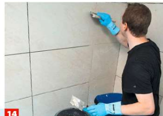
14 Bringen Sie den Mörtel mit Fuggummi diagonal zum Fugennetz ein, die Fugen müssen bündig gefüllt sein. Alle Anschlussfugen ...
