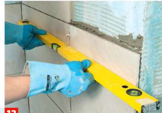
12 Fliese andrücken und die vertikale Ausrichtung überprüfen – die Fliesen sind 15 Minuten im Kleberbett korrigierbar.
