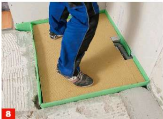
8 Das Element ausrichten und andrücken. Treten Sie dabei nicht auf den mittig platzierten Ablauf.
