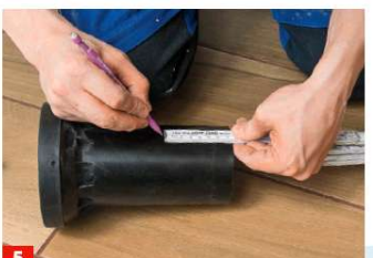
5 ... den Rohrüberstand abmessen und dann auf das Rohrende übertragen. In jedem Fall müssen die Rohre um den Abstand ...
