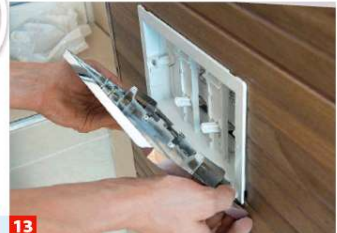
13 Abschließend einfach die Drücker- bzw. Betätigungsplatte aufstecken.
