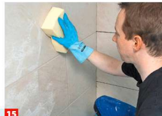
15 ... offen lassen. 2) Nach dem ersten Antrocknen die Fläche mit nassem Schwamm oder mit Hilfe eines Schwammbretts reinigen.
