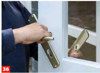
36 Nun muss noch der Türbeschlag angebracht und befestigt werden.
