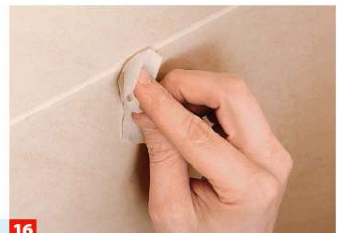
16 Gleichfalls reinigen Sie den Untergrund mit Alkohol, er muss sauber und fettfrei sein.
