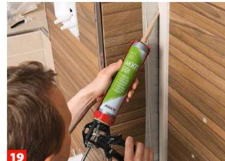
19 Die Kartusche gleichmäßig entlang der Fugen führen und das Silikon darin ausspritzen.
