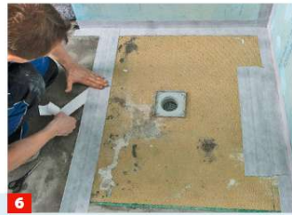
6 ... sondern nur auf einer Seite. Setzen Sie das Dichtband mit dieser Seite an und ziehen dann erst die andere Folienhälfte ab.
