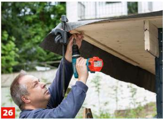
26 Schrauben Sie eine Leiste unter den vorderen Überstand der Dachschalung. An ihr kann nun die Blende angebracht werden.
