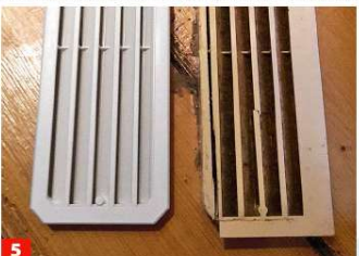
5 Soweit, so einfach. Unten musste das Gitter jedoch wie das alte gekürzt werden, damit die Tür am Trockenestrich noch schließt.
