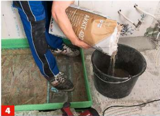
4 Zur Verklebung des Elements Flexkleber mit Wasser anrühren.
