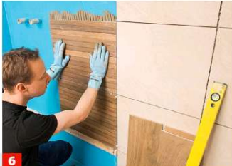
6 Weiteren Kleber aufkämmen und die nächste Fliese bis an die Kreuze heransetzen. Mörtelreste auf den Fliesen direkt entfernen!
