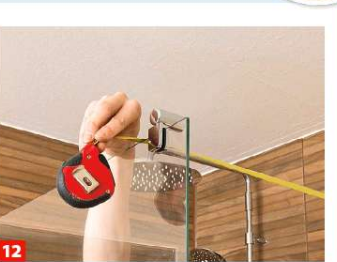
12 An der einen Seite wird er auf die Glasplatte gesteckt, auf der anderen Seite mittels Aufhängung in der Wand verdrübelt.
