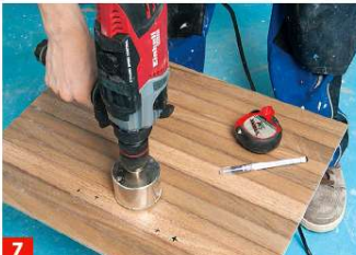
7 Um Löcher sägen zu können, benötigt man Diamantbohrkronen für Fliesen. Mechanisch, aber schwieriger geht es mit Lochzange ...
