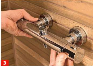
3 Dann schrauben Sie die Thermostat-Armatur an. Ziehen Sie die Muttern mit Schraubenschlüssel fest. Die Duschsäule wird nun an ...
