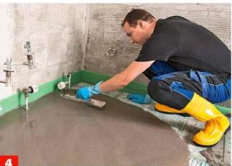
4 Ggf. beschleunigen Sie das Verlaufen mit einer Kelle, aber nicht zu lange: Schnell arbeiten – die Masse bindet nach 30 Min. ab!
