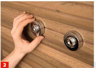
2 Armatur probeweise anhalten. Passt sie, stülpen Sie jetzt die Rosetten auf die Rohrausgänge.
