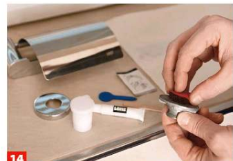
14 Bei der Montage des Papierhalters heißt die Devise „Nie wieder bohren“. Mit beiliegendem Schleifpad gehen Sie über die ...
