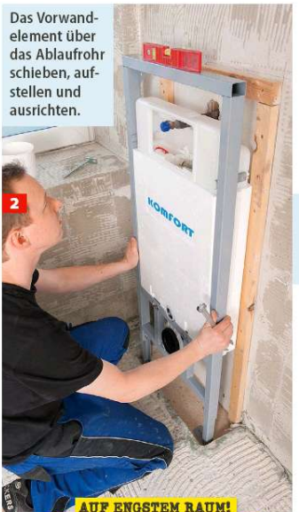
3 Damit das Vorwandelement die versprochenen 400 kg Tragkraft aufweist, muss es fest verankert sein. In Leichtbauwänden ...
