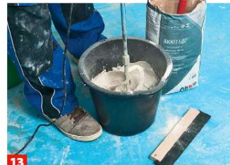
13 Nach 24 Stunden hat dieser Kleber abge bunden und die Flächen können verfugt werden. Flexfugenmörtel mit Wasser anrühren.
