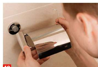
19 Nach rund 12 Stunden ist der Sockel voll belastbar und der Papierhalter kann daran befestigt werden.
