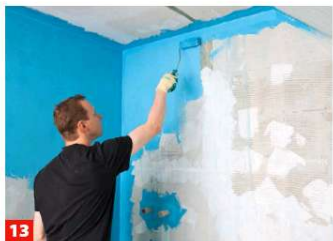
13 Die Fläche streichen Sie mit Schaumstoff- oder Lammfellrolle/-walze in gleichmäßiger Schichtstärke.
