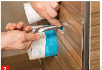
2 ... Innenliegendem Gewinde bis auf 10 mm an die Wand aufschrauben, die Einbuchungen müssen jeweils nach außen zeigen.
