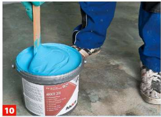
10 Jetzt folgt ein zweimaliger Auftrag der Flüssigabdichtung (zwischendurch gut trocknen lassen). Rühren Sie sie erst gut durch.
