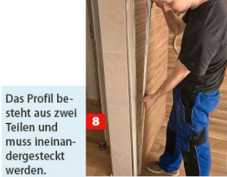
8 Das Profil besteht aus zwei Teilen und muss ineinander gesteckt werden.
