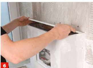
6 Ob es gerade ausgerichtet ist, zeigt sich dann bei der Verkleidung mit Bauplatten. Offen bleibt der Abfluss und der Bereich ...
