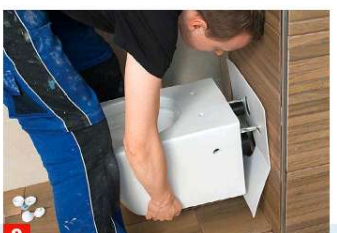
9 Jetzt das WC mit aufgesteckten Rohren über die Gewindestangen und Aufhängungen bis an die Wand schieben.
