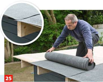
25 Weitere Bahnen werden mit etwa 6 cm Überlappung ausgelegt. Achten Sie auf einen seitlich bündigen Abschluss.
