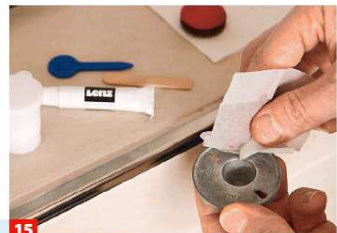
15 ... Rückseite der Sockelplatte. Anschließend reinigen Sie sie mit einem Reinigungstuch.
