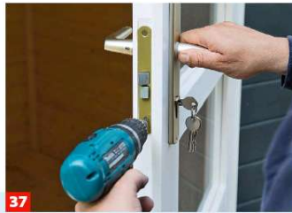
37 Zum Schluss schrauben Sie das Einsteckschloss an. Überprüfen Sie, ob es sich einwandfrei abschließen lässt.
