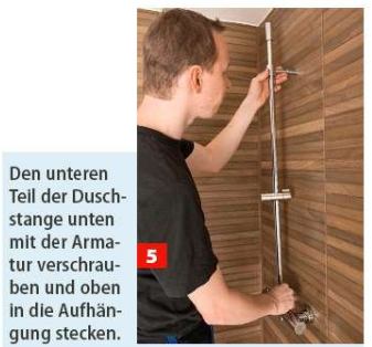
5 Den unteren Teil der Duschstange unten mit der Armatur verschrauben und oben in die Aufhängung stecken.
