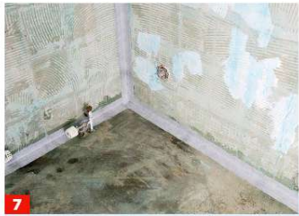
7 Vermeiden Sie beim Verkleben Knicke im Dichtband, es muss glatt über alle Eck- und Anschlussbereiche verklebt werden.
