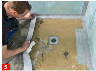
5 Wie gesagt, auch Anschlussfugen überkleben, hier rund ums Duschelement. Ziehen Sie die Schutzfolie nicht direkt ganz ab, ...
