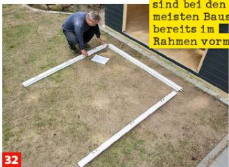
32 Legen Sie den Blendrahmen der Tür auf einer ebenen Fläche aus und verschrauben Sie die Eckverbindungen.
