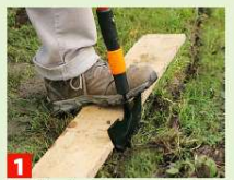
1 Den Umriss an einem Schlauch oder Brett entlang abstecken.
