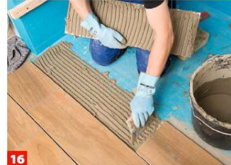
16 Nach den Wänden folgt der Boden. Da hier die Belastung größer ist, den Kleber auf Boden und Fliesenrückseite auftragen. 3)
