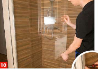
10 Das Glaselement nun ins Profil schieben und an den vorgesehenen Stellen damit verschrauben.
