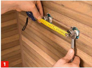
1 Die der Armatur beiliegenden S-Anschlüsse so in die Zuleitungen eindrehen, dass sie exakt 150 mm auseinanderliegen. 1)
