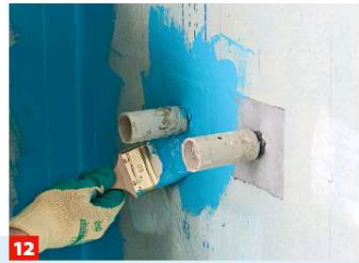
12 Auch rund um Rohre eher mit Pinsel als mit Rolle arbeiten. Und am besten Baustopfen zum Schutz über die Rohre schrauben.
