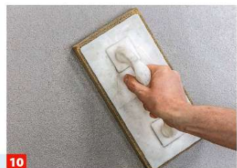
10 Hat der Putz leicht angezogen, reiben Sie ihn mit einem Schwammbrett glatt ab. Dann wird grundiert und mit Lehmfarbe gestrichen.
