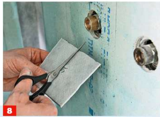
8 Für Rohrausgänge gibt es praktische Dichtmanschetten, die aber nicht jeden Zuschnitt vermeiden: Um sie hier über die ...
