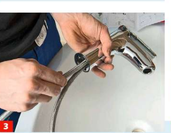
3 ... an den Stockschrauben befestigen. Die beiliegenden 400 mm langen Anschlussschläuche mit der Armatur verbinden, ...
