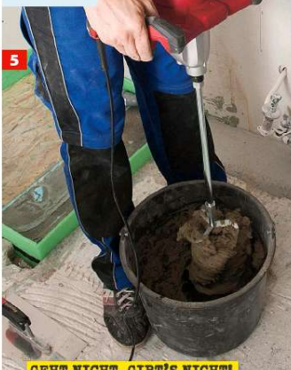
5 GEHT NICHT, GIBT'S NICHT! Verwendet man statt Rührquirl und Bohrmaschine ein richtiges Rührgerät, gelingt das Anmischen mühelos.
