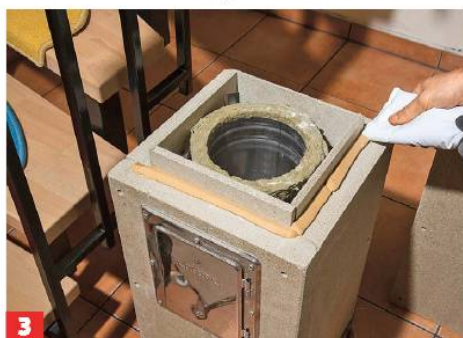
3 Die Schachtelemente verklebt man mit hochtemperaturfestem Brandschutzkleber, hier aus dem Schlauchbeutel aufgetragen.
