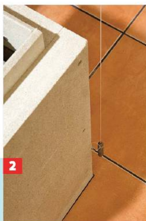
2 Neben Wasserwaage/Richtlatte hilft auch ein Senklot beim fortlaufenden Ausrichten der Elemente. Es kann hier sehr gut oben am Geländer befestigt werden.
