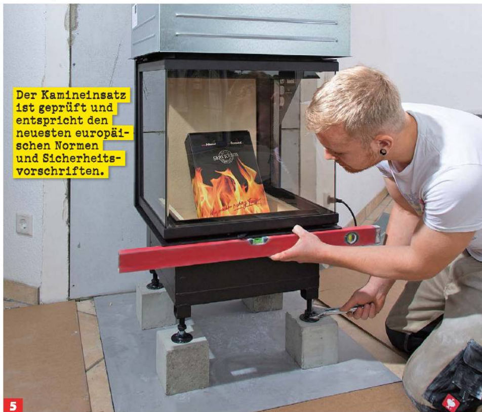
Die Montage des Kamins beginnt mit dem Aufstellen des Kamineinsatzes. Diesen auf die zum Bausatz gehörenden 12 cm Betonfüße stellen. Mit Hilfe der Verstellerschrauben richten Sie ihn auf 403 mm Höhe (Fertigfußboden bis Unterkante Türtransverse) waagrecht aus.
