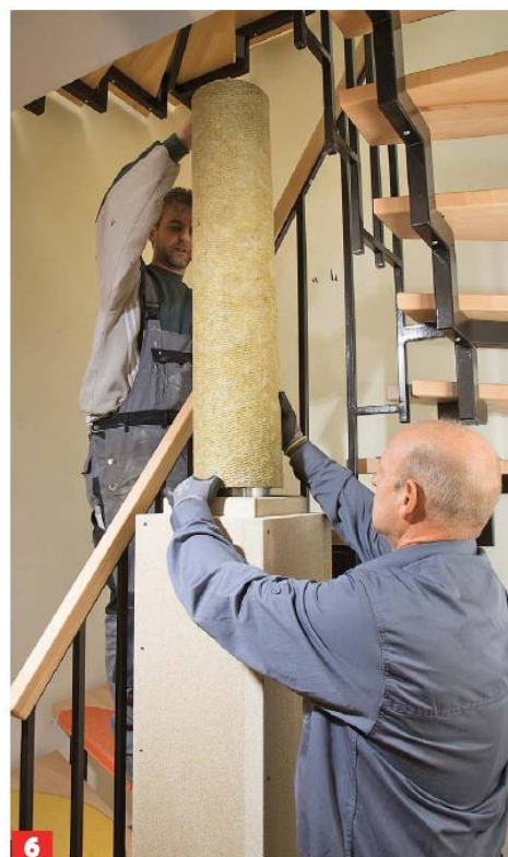
6 Es folgt ein Edelstahlrohr (Längenelement) samt Dämmung**, das man in das Schachtelement einführt.
