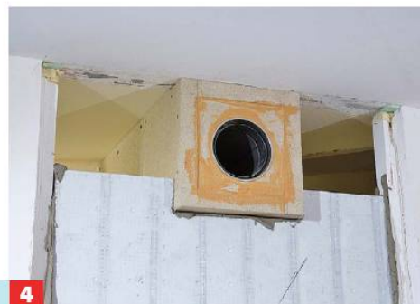
So sind auch Ausschnitte rund um die Abgasstrecke kein Problem. Die Platten werden mit Klimaplattenkleber vermörtelt.
