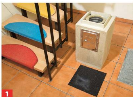
1 Der Schornsteinaufbau beginnt hier am Kellerboden mittig im Treppenhaus.* Zuunterst wird eine 4-mm-Bautenschutzmatte gelegt.
