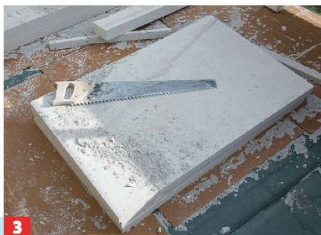
Diese Platten lassen sich gut mit einer Säge zuschneiden. Übrigens: Nur nicht brennbare Baustoffe verwenden*, keinesfalls Styropor!
