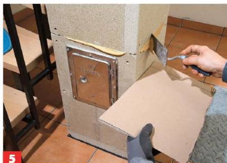
5 Den aus der Fuge ausgetretenen Kleber mit einem Spachtel oder der Maurerkelle direkt abziehen (Bodenbelag abdecken!).
