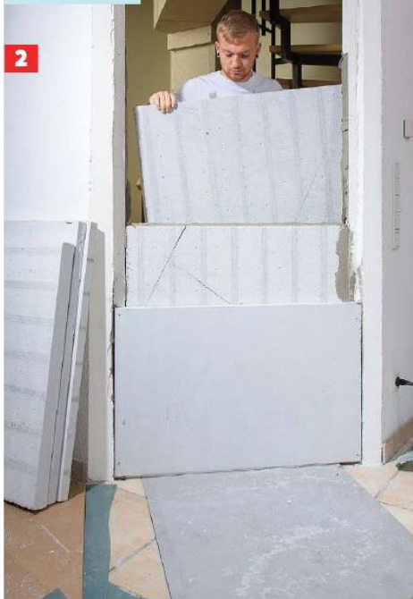
Diese Platten lassen sich gut mit einer Säge zuschneiden. Übrigens: Nur nicht brennbare Baustoffe verwenden*, keinesfalls Styropor!
