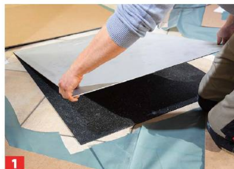
1 Zur Lastverteilung wurde hier unter den Kamin eine 4-mm-Bautenschutzmatte sowie darüber eine 3-mm-Edelstahlplatte gelegt.
