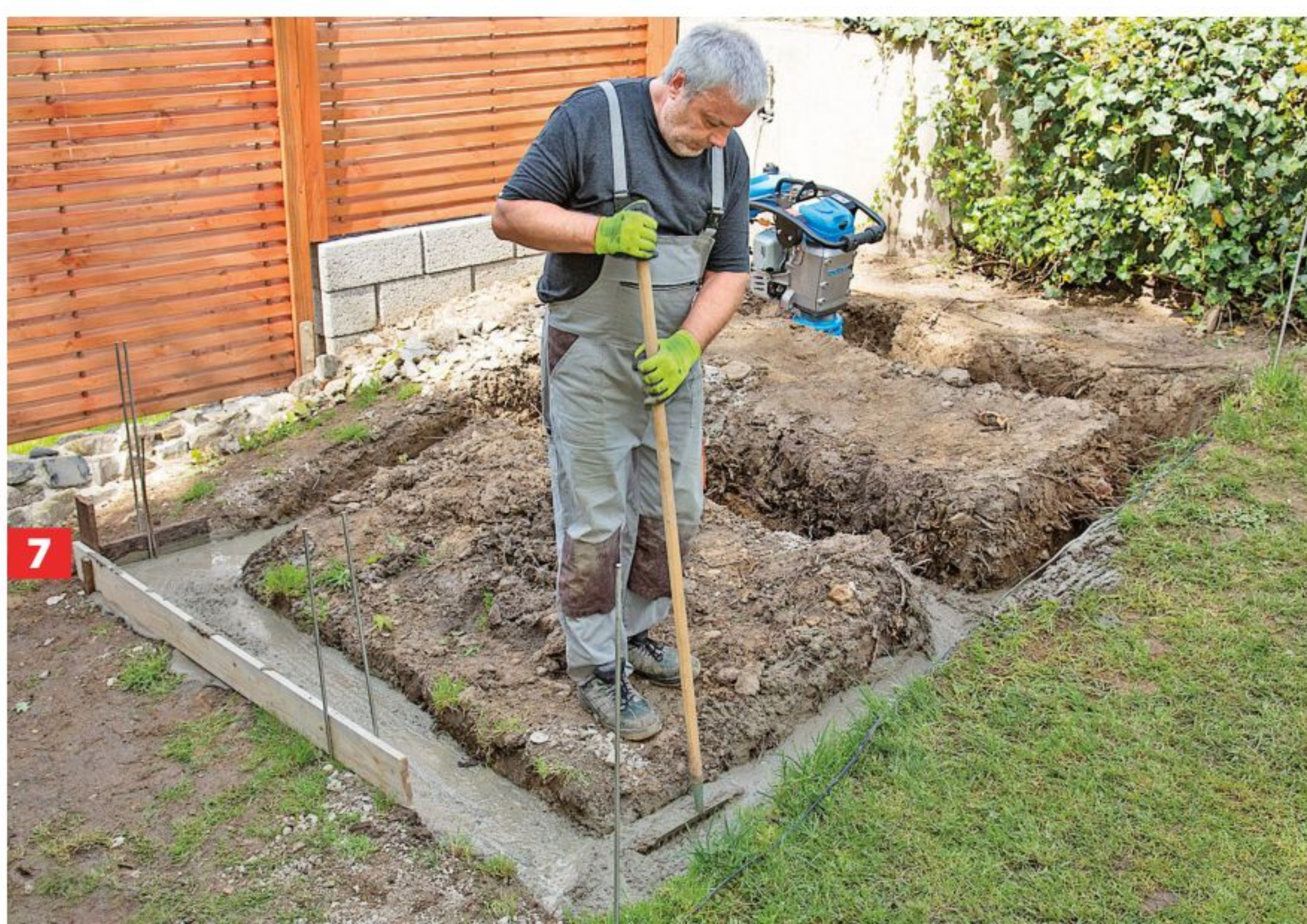
7 Dann können Sie den fertig angemischten Beton in die Gräben füllen und die Oberfläche ebnen. Zuerst wird der untere Teil des Fundaments gegossen.
