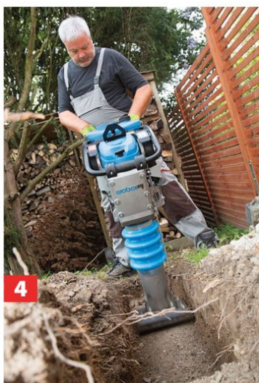
4 Diese Schicht wird nun mit einem Rüttler gut verfestigt, alternativ geht das auch mit einem Handstampfer.
