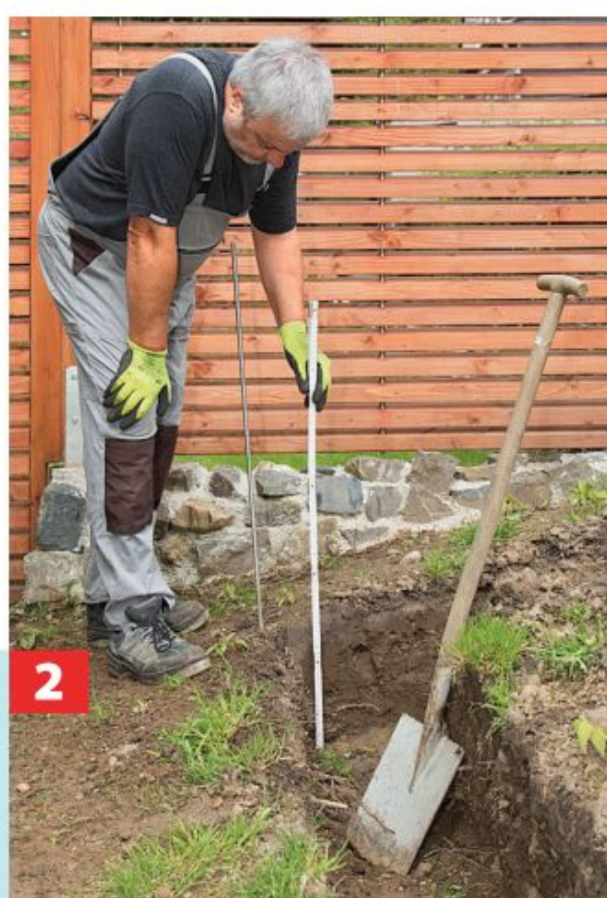
2 Kontrollieren Sie die Tiefe – eine frostfeste Gründung benötigt dazu 80 cm.
