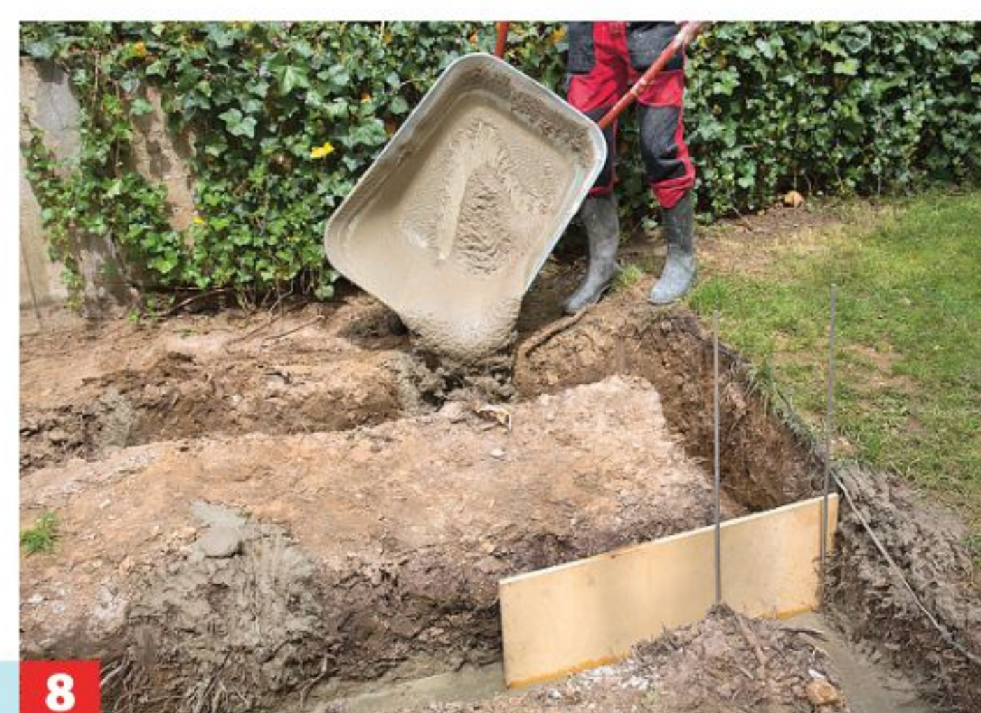
7 Dann können Sie den fertig angemischten Beton in die Gräben füllen und die Oberfläche ebnen. Zuerst wird der untere Teil des Fundaments gegossen.
