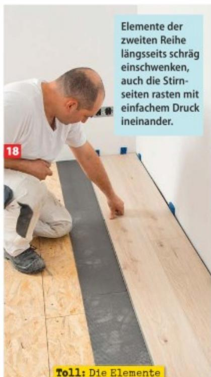
Elemente der zweiten Reihe längsseits schräg einschwenken, auch die Stirnseiten rasten mit einfachem Druck ineinander.
