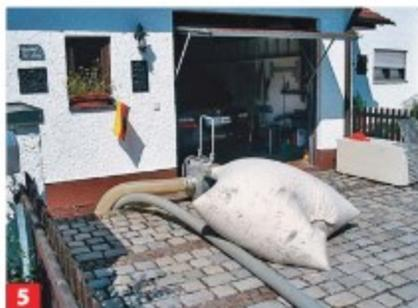
5 Bei der Pellets-Befüllung wird die abgesaugte Luft über einen Beutel zurückgeführt, um Überdruck abzubauen und Staub zu sammeln.
