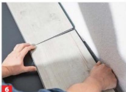
**6** ... Lichteinfall verlegt werden. Das nächste Element stirnseitig schräg einhebeln.
