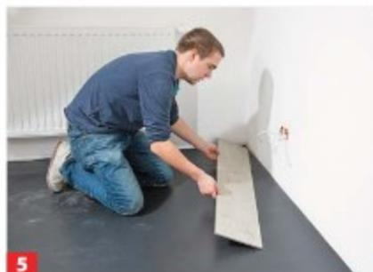
**5** Beginnen Sie die Verlegung in einer linken Raumecke, Federseite Richtung Wand. Die Elemente sollten am besten parallel zum ...
