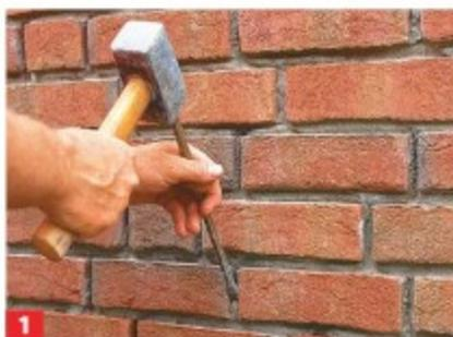
**1** Erst die Fugen 15 bis 20 mm tief auskratzen. Hierfür einen dünnen Meißel oder eine konisch geformte Hartholzleiste verwenden.
