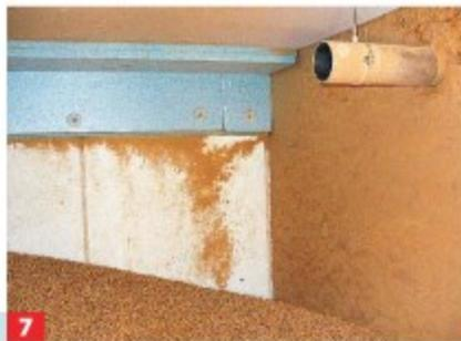
7 So gelangen die Pellets von oben ins Lager. Die Pellets-Ansaugstutzen am Boden führen die Pellets dann über weitere Rohre zum Kessel.
