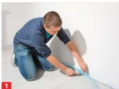
**1** Überstehende Randdämmstreifen zur Entkopplung des Estrichs (hier Trockenestrich) bündig zur Oberfläche abschneiden.
