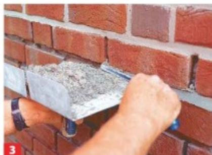
**3** Neben einem praktischen Fugblech brauchen Sie zum Verfugen zwei unterschiedliche Fugeisen: Ein längeres für Lagerfugen, ...
