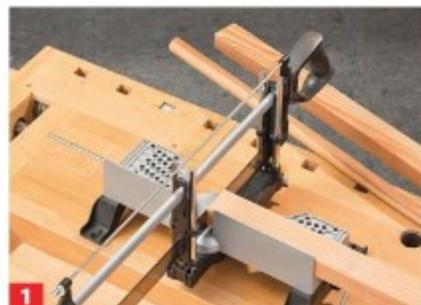
**1** Längen Sie die Holzleisten und Rundhölzer mit einer Kapp- und Gehrungssäge ab.
