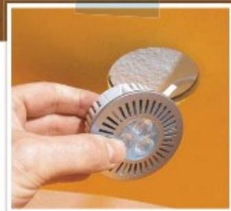
Die Leuchten werden einfach direkt an 230 Volt angeschlossen und eingeklippt.
