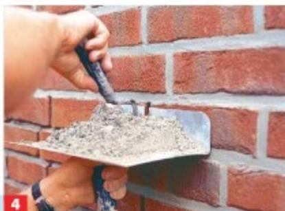
**4** ... ein kurzes für Stoßfugen. Den Fugenmörtel möglichst flächig zur Mauer einbringen. Dies sollte durch mehrfaches Andrücken ...
