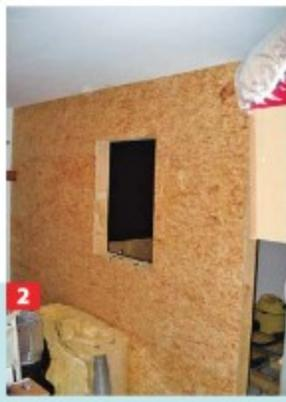
2 Dieses Ständerwerk wurde innen und außen mit 18-mm-OSB-Platten verkleidet, der Zwischenraum wurde mit Mineralwolle gefüllt.
