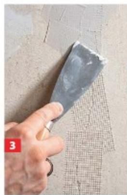
**3** Putzrisse etwas aufweiten, leicht vornässen und mit Spachtelmasse verschließen. Eine Rissbrücke als Armierung einarbeiten.
