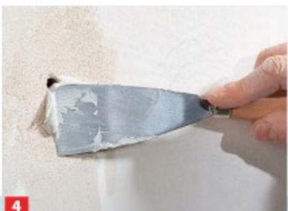
**4** Bohrlöcher mit Spachtelmasse verschließen. Danach die Reparaturstellen mit grobem Schlefpapier oder mit Schleifgitter glätten.
