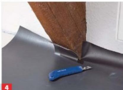
**4** ... Unterlagsmatten (siehe Kasten rechts). Diese flächig im Raum auslegen. Zuschnitte können mit einem Cutter erfolgen.
