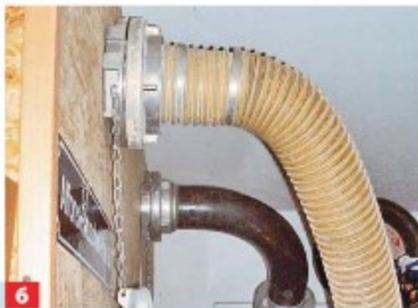
6 Einblasrohr und Luftabsaugung schließt man innen an die Befüllstutzen in der Lagerwand an.
