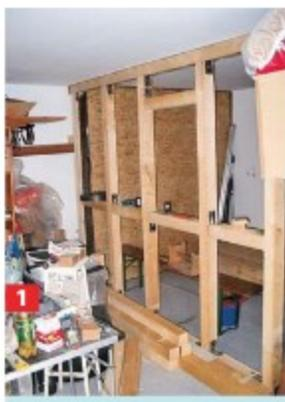
1 Drei Seiten des Lagers bilden Holz-wände, hier das Grundgerüst aus mit Winkeln verschraubten Kanthölzern.
