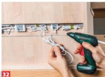
**32** Power-Supply, Junction-Box und Dimm-Switch-Controller anschließen und die Leitungen mit Kabelbindern und Heißkleber\* bündeln.
