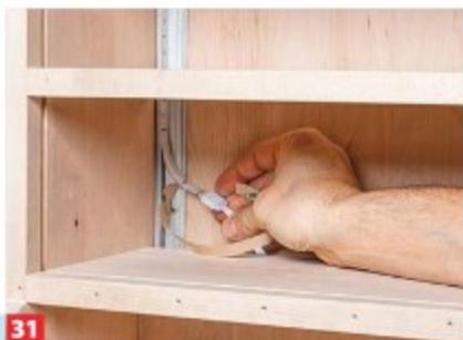
**31** LED-Strips zuschneiden, seitlich aufkleben und mit Steckern anschließen. Diffusoren aufclippen und Leitungen hinter die Blende führen.
