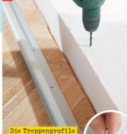
Die Treppenprofile sind für Bodenhöhen von 8 bis 10 mm und 14 bis 16 mm erhältlich.
