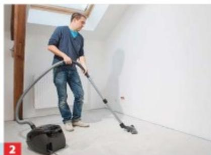
**2** Den Untergrund dann absaugen/fegen, Staub und körnige Schmutzpartikel müssen entfernt werden.
