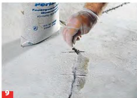
**9** Saniergießharze (z. B. Epoxidharz) bilden eine sehr glatte Oberfläche. Damit anschließender Belagskleber gut haftet, streuen ...
