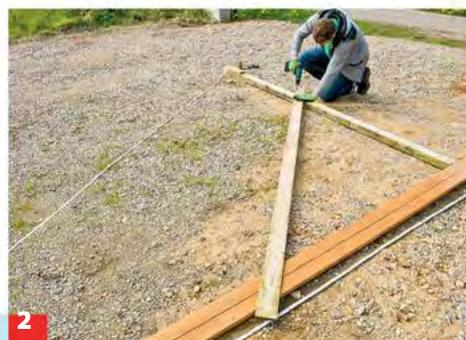
... rechten Winkel muss die Diagonale zwischen einer drei und einer vier Meter langen Latte fünf Meter betragen. Winkel fixieren.
