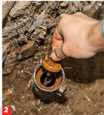
**2** ... das Rückschlagventil entfernt. Deutlich sind im Rohr Ablagerungen erkennbar.
