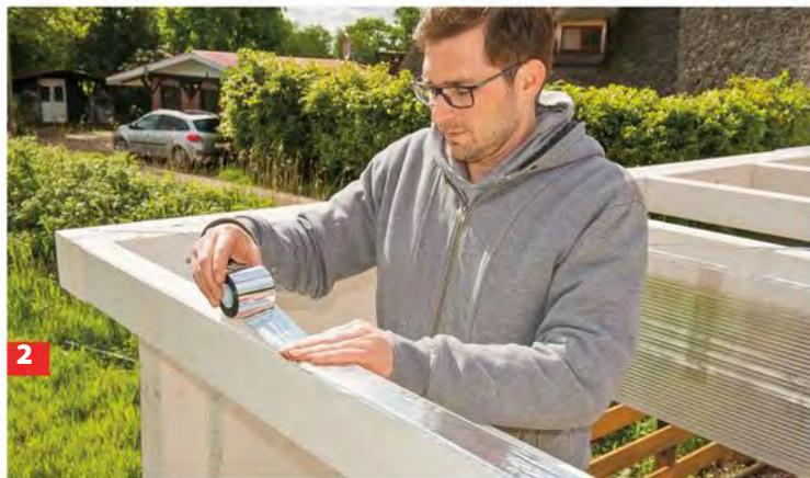
Die oben liegenden Holzflächen werden mit einem das Sonnenlicht reflektierenden Klebeband versehen. So erhitzt sich das Holz nicht so stark.
