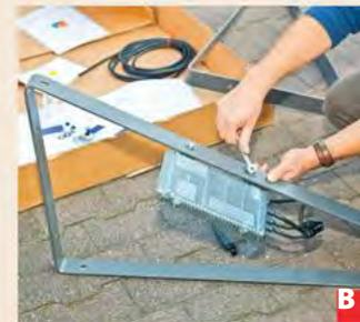
B Zunächst schrauben Sie den Wechselrichter an eine der beiden Haltestreben des Untergestells.
