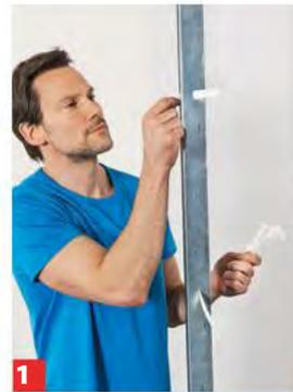
1 CW- und UW-Profile zum Ständerwerk montieren. Dann *Zips* durch die ...
