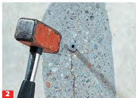
**2** Zur Injektion des Reaktionsharzes werden nun Packer in den Riss gesetzt. Dies können Bohrpacker sein wie hier im Bild ...
