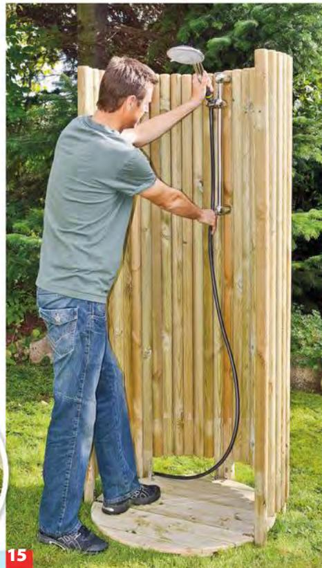
**15** Stützen entfernen und weitere Seitenteile ebenso montieren. Von innen wird dann die Duscharmatur angeschraubt.
