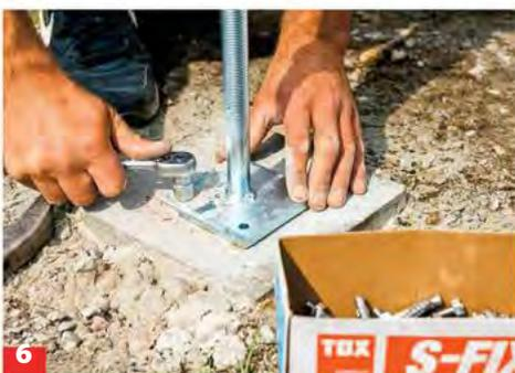
**6** Mit einer Ratsche die Muttern festziehen. So alle Stützenschuh montieren.
