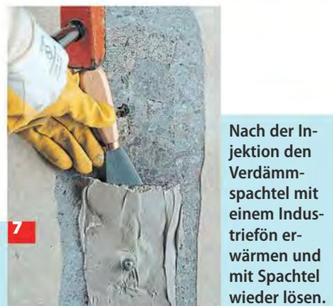
Nach der Injektion den Verdämmspachtel mit einem Industriefön erwärmen und mit Spachtel wieder lösen.
