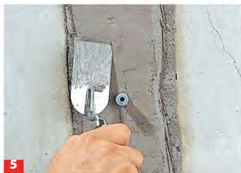
**5** Über den Riss trägt man nun Verdämmspachtel auf, um den Injektionsdruck aufbauen zu können und das Auslaufen des ...
