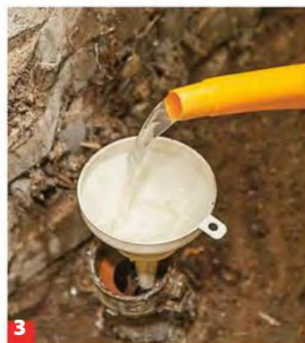
**3** Nun die fertig gemischte Reinigungslösung in das Brunnenrohr einfüllen und 12 bis 24 Stunden ...
