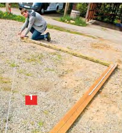
Mit Brettern, Maßband (und dem Satz des Pythagoras) werden die Positionen der Punktfundamente festgelegt. Für einen ...
