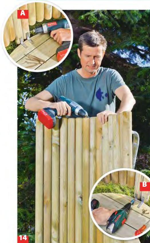
**14** Beide Teile unten **A** wie oben (großes Bild) schräg durchbohren und verschrauben. Die Pfosten mit den Winkeln **B** verbinden.
