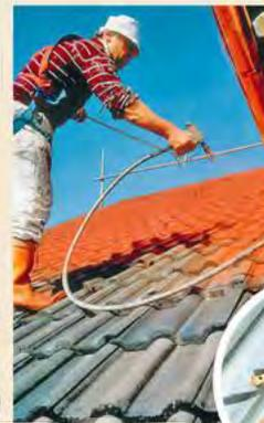
Mit Flächenstreicher oder Sprühgerät<sup>2)</sup> lässt sich das Dach gut beschichten.
