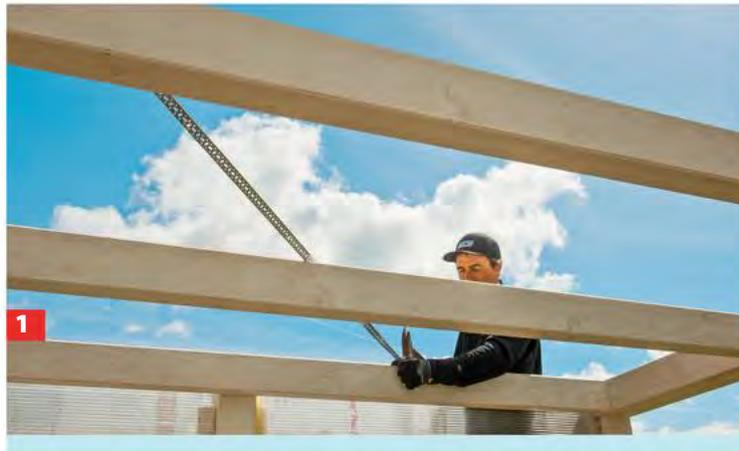
Diagonal über die Dachkonstruktion wird ein gelochtes Stahlband genagelt. Das dient der zusätzlichen Verstärkung und verhindert eine parallele Verschiebung der Sparren.
