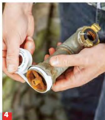
**4** ... einwirken lassen. Brunnenkopf mit Hanf oder (hier gezeigt) Dichtband wieder montieren.
