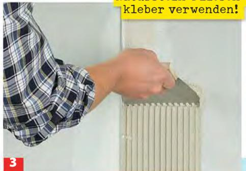
3 Tragen Sie auf einer Seite entlang der Markierung Fliesenkleber auf und drücken die ge- löchte Schenkelseite des Profils in den Kleber.
