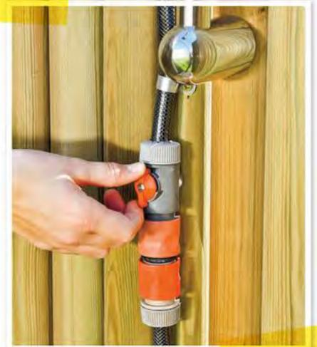
Um den Wasserdurchfluss in der Dusche zu regulieren, können Sie ein Absperrventil einsetzen (z. B. von Gardena). Dazu den Schlauch durchtrennen, mit einer Kupplung und einem Schlauchstück die Verbindung unten wieder herstellen.
