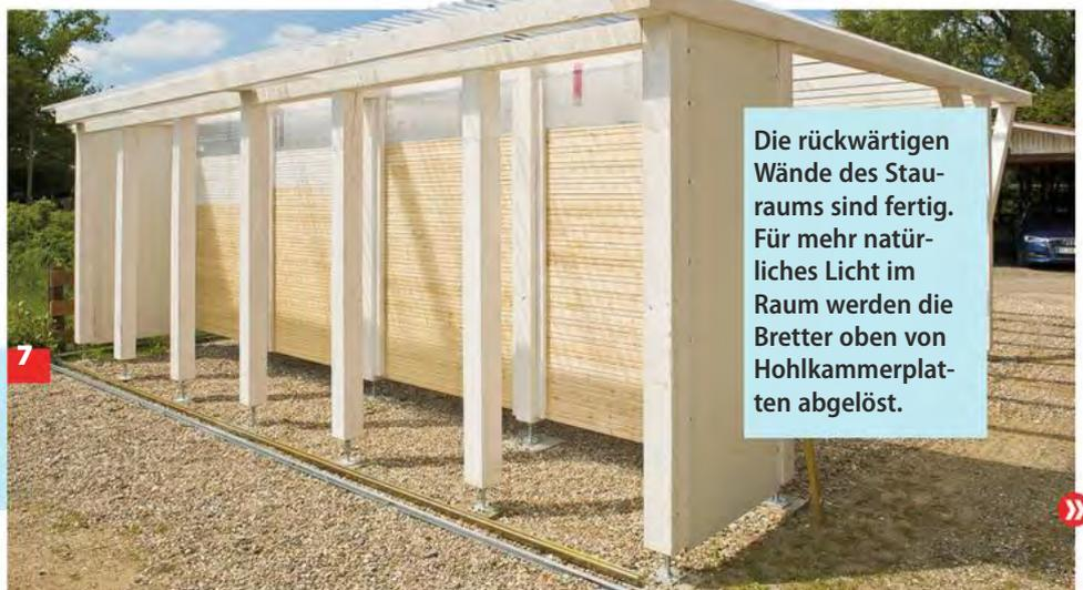
Die rückwärtigen Wände des Stauraums sind fertig. Für mehr natürliches Licht im Raum werden die Bretter oben von Hohlkammerplatten abgelöst.
