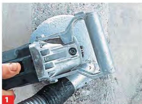
**1** Zunächst loses Material entlang des Risses entfernen, den Riss ggf. etwas ausfräsen oder mit Hammer und Meißel vergrößern.
