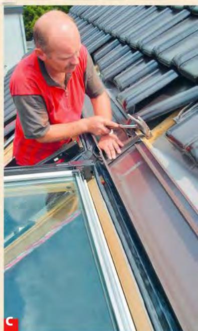
Fensterhersteller empfehlen den Einbau durch einen Profi, z. B. Dachdecker. Aus Gründen der Gewährleistung ist dies auch ratsam. Bei der Montage kommt es vor allem auf die Abdichtung an. **A** Diese bildet der Eindeckrahmen rund ums Fenster, dessen Montage von unten nach oben erfolgt, hier das Unterteil. **B** Es folgen die Seitenteile und das Oberteil. **C** Zum Vernageln Kammnägel verwenden. **D** Die Bleischürze/Abdichtung unten muss bündig mit den Dachpfannen abschließen.
