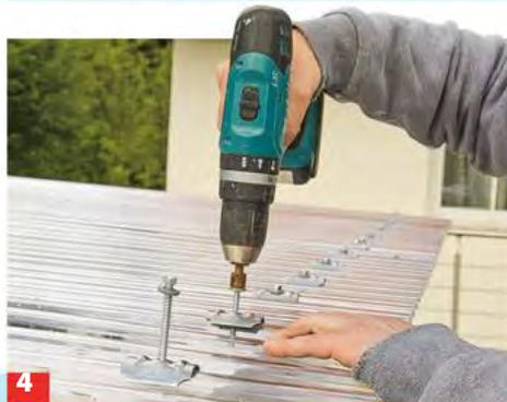
An diesen Stellen werden die Platten dann mit speziellen Kalotten mit der Dachkonstruktion verbunden.
