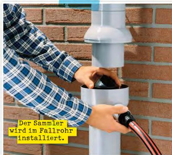
Gartenfreunde schätzen es, mit Regenwasser zu gießen – automatische Sammler füllen Regentonnen und Tanks aus dem Fallrohr.
