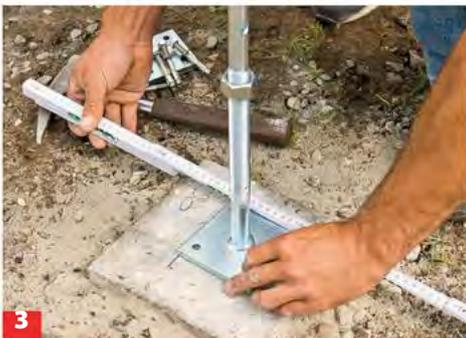
**3** Die Stützen auf den Fundamenten positionieren und ausrichten – das heißt nicht zwingend mittig!
