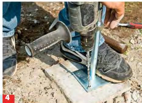
**4** Die 8-mm-Bohrlöcher für die Befestigung der Pfostenschuhe anzeichnen und bohren.
