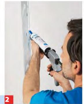
2 ... Schlitzte der CW-Profile führen; Kleber an der inneren Profilkante auftragen.
