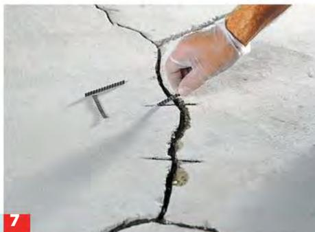
**7** Dann setzen Sie die Estrichklammern in die vorgefrästen Schlitzte und übergießen sie ...
