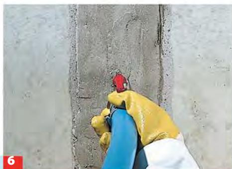
**6** ... einzufüllenden Reaktionsharzes zu verhindern. Über die Packer wird dann also Epoxid- oder Polyurethanharz eingefüllt.
