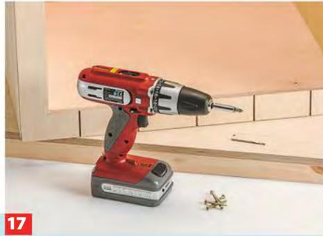
**17** Schrank auf dem Boden platzieren, Umriss anreißen. Löcher entsprechend vorbohren. Dann den Schrank mit dem Boden verbinden.
