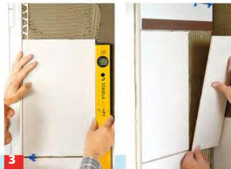
**3** ... sauber am Eck sitzt. Anschließend die Fliesen bis ans Profil heranlegen und mit Wasserwaage ausrichten; dann weitere Fliesen legen.
