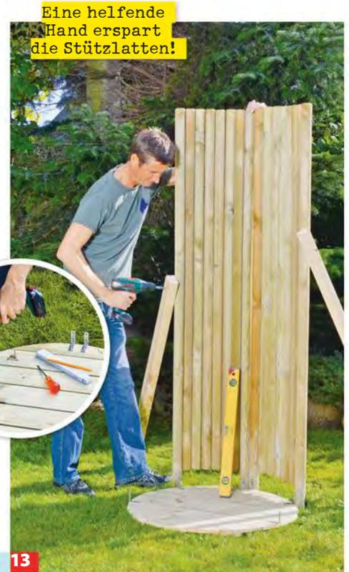
**13** Auf einem möglichst ebenen Platz zusammenbauen. Die ersten beiden Seitenteile mit Stützlatte aufstellen und ausrichten.
