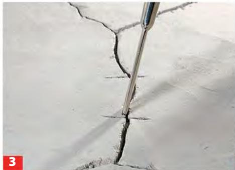
**3** ... 20 bis 30 cm Schlitzte in den Estrich. Die Schlitztiefe sollte  $\frac{1}{2}$  bis  $\frac{2}{3}$  der Estrichstärke betragen. Den Riss dann säubern!
