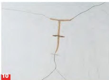
**10** ... Sie vorm Abbinden des Harzes Quarzsand darüber. Der Bodenbelag kann nun darauf verlegt werden, ohne dass er zu reißen droht.
