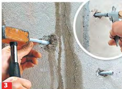
**3** ... oder spezielle Schlagbohrpacker, mit denen bei hohem Injektionsdruck Risse von innen nach außen verfüllt werden.
