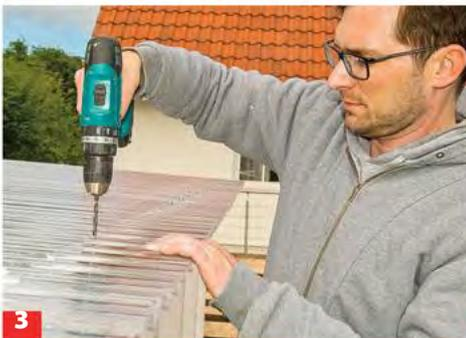
Das Dach besteht aus 3 mm dicken Acrylplatten. Jede zweite bis dritte Welle des Profils wird vorgebohrt.
