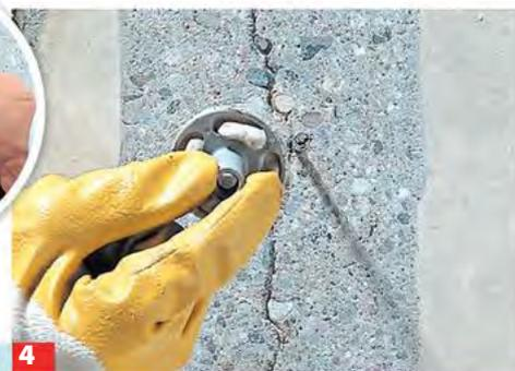
**4** Des Weiteren können Klebepacker gesetzt werden, die man bei trockenen Rissen und geringem Fülldruck verwendet.
