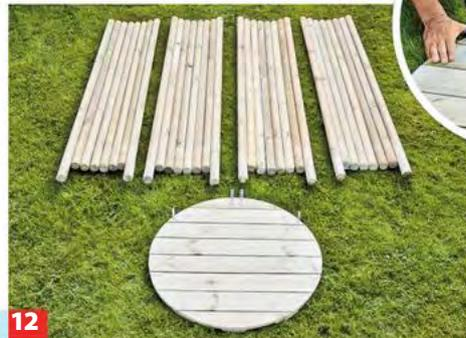
**12** Das Bodenrost wird noch mit Winkeln für die Befestigung der Seiten versehen (Detail). Dann ist alles bereit für die Montage!
