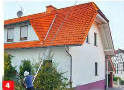
4 Das gelingt bei vielen Häusern komplett von unten. Der Reiniger löst Grünbelag an, dieser wird vom Regen abgespült.
