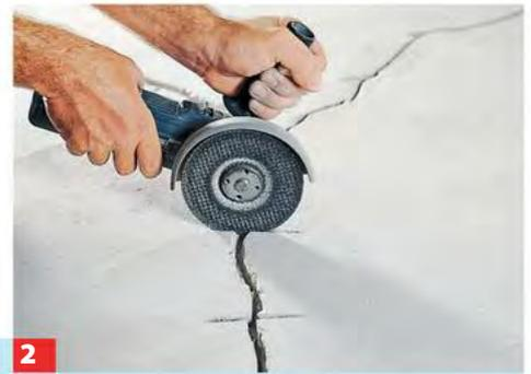
**2** Um die Sanierklammern setzen zu können, schneiden Sie mit Winkelschleifer und Trennscheibe quer über den Riss alle ...
