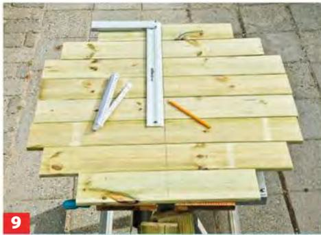
**9** Auf der Unterseite des Bodenrosts die bereits abgelängten Bretter markieren, wo diese mit weiteren Brettern verbunden ...
