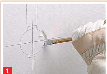
1 Verlauf der Leitungen und Lage der Dosen anzeichnen, Leitungswege aufstemmen.
