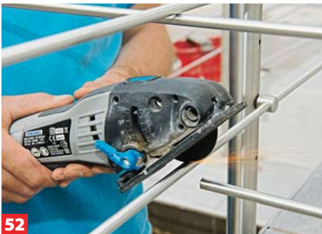
52 Anschließend die Edelstahlstäbe mit Trennscheibe durchschneiden.
