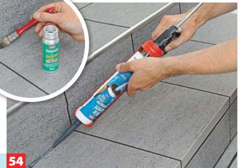
54 Am Ende alle Anschlussfugen elastisch ausfüllen. Ein Voranstrich für Silikondichtstoffe sorgt für bessere Haftung des Silikons.
