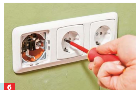
6 Steckdoseneinsätze ausrichten und mit den Geräteschrauben am Rand der Dosen befestigen. Rahmen und Blenden montieren.
