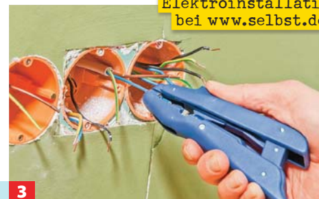
3 Adern abisolieren. Für Schraubklemmen sollte die abisolierte Länge etwa 6 mm, für Steckklemmen 10 bis 12 mm betragen.
