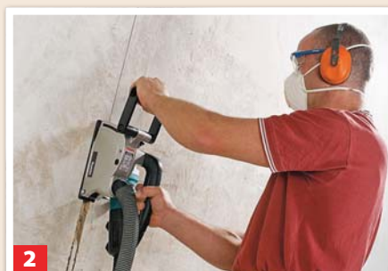
2 Bei umfangreichen Arbeiten sollten Sie eine Mauernutfräse einsetzen (ggf. leihen).
