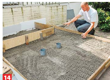
13 Nun Beton anmischen, je nach Menge mit Kübel, Rührquirl und Bohrmaschine oder mit einer ausgeliehenen Mischmaschine.
