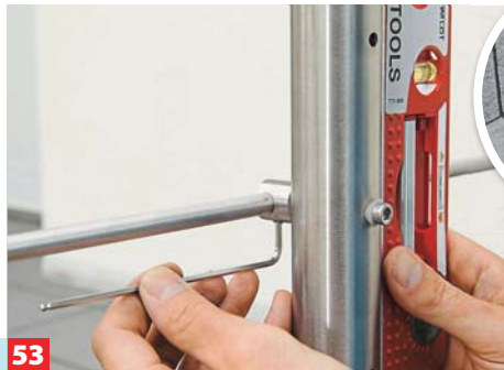
53 Geländerstäbe durch die Aufnahmen schieben und mit den Inbusschrauben festziehen.
