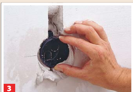
3 Dosen mit Elektrikergips bündig einsetzen, Leitungen verlegen und in Dosen einführen.
