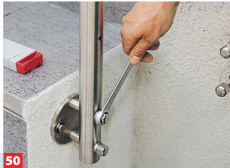
50 Dann Hutmuttern aufsetzen und bis an die Geländerstäbe heran festschrauben.
