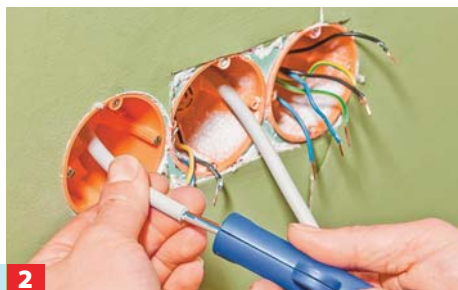
2 Kabelmantel der Verbindungsleitung mit einem Kabelmesser oder Entmantler in ausreichender Länge vorsichtig entfernen.
