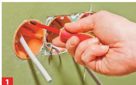
1 Befestigungsschrauben am Dosenrand festziehen, bis sich die seitlichen Haltenasen an der Wandrückseite verkrallen.
