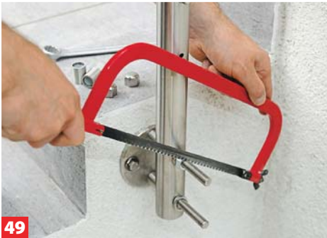
49 Stützkonsole befestigen und Geländerstäbe aufstecken, ggf. die Gewindestangen kürzen und entgraten.
