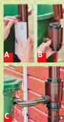
3 Das Loch für den Dachrinnenstutzen können Sie mit einer Stichsäge einbringen (Metallsägeblatt).
