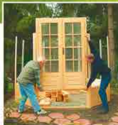
ACHTECKIGE FORM: Ein ungewöhnlicher Grundriss wie bei diesem Pavillon stellt beim Fundament eine Herausforderung dar.
