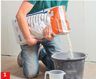
1 Fugenspachtelmasse ist meist als Trockenmörtel erhältlich und muss mit Wasser angerührt werden.
