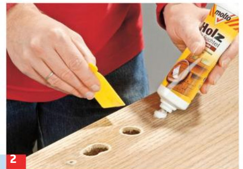
2 Beschädigungen der Oberfläche ggf. zweimal spachteln und schleifen, Kanten mit Schleifklotz von Hand brechen.
