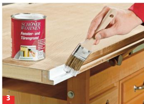
3 Zunächst den Falz mit LH-Grundierung streichen und die Flächen rollen. Für LH-Lack geeignetes Werkzeug verwenden!
