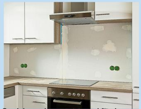
Steckdosen lassen sich problemlos in die Mosaikoberfläche integrieren.
