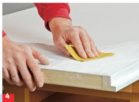
4 Nach vollständigem Trocknen in einem möglichst staubarmen Raum alle Flächen ggf. mit dem Schwingschleifer fein ...
