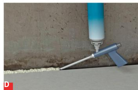
D Am Ende offene Rand- und Anschlussfugen mit Montageschaum füllen.
