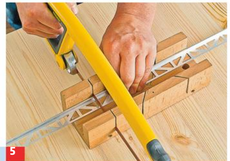
5 Schneiden Sie das Profil mit der Eisensäge auf Länge. Sie benötigen hier ein Abschlussprofil für 8-mm-Fliesenstärke!
