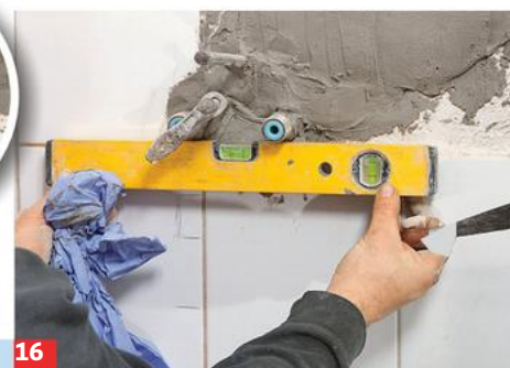
13 Die flexiblen Anschlusschläuche müssen nun fixiert werden. Dazu wurden hier Putz- bzw. Maurerhaken verwendet.
