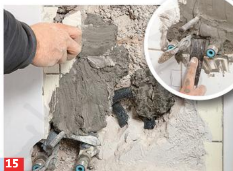
12 Lagen die Anschlüsse vormals im oberen Bereich des Aufgestemmt, liegen sie jetzt wie gewünscht unten links.
