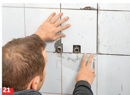
18 Im Bereich der Anschlüsse müssen bei einer Fliese entsprechende Aussparungen vorgenommen werden. Dies gelingt mit ...
