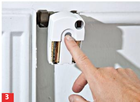
1 Die von der Funkzentrale angesteuerten Stellantriebe ersetzen die bisherigen Heizregler. Die Montage ist ohne ...
