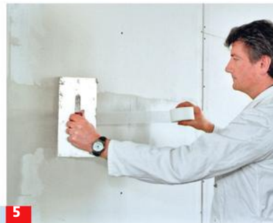
5 Bei abgeflachten Kanten folgen im zweiten Arbeitsgang nochmals Spachtelmasse und Fugenband. Dieses ...
