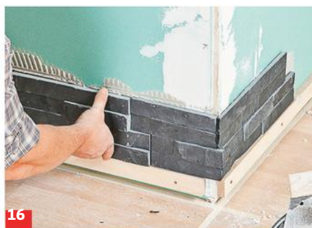
14 Beginnen Sie unten an der Außenecke: Klebstoff mit der Kelle auftragen und anschließend mit dem Zahnpachtel ...
