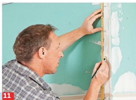
8 Mit der Richtlatte waagrecht den Sockelbereich aufreißen. Sollte der Boden Gefälle aufweisen, muss dieser durch ...
