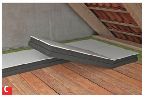
C Ohne Kreuzfugen verlegen, mit Reststück der ersten Reihe die zweite beginnen.
