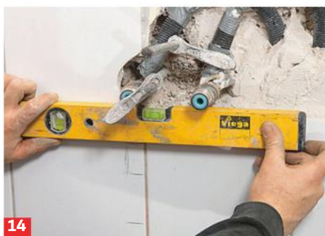
11 Ist alles soweit freigelegt, werden die Wasseranschlüsse in die korrekte Position gerückt.
