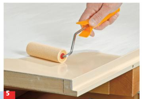
5 ... zwischenschleifen (P240). Es folgen zwei Decklackanstriche ebenfalls mit einem feinen Zwischenschliff.
