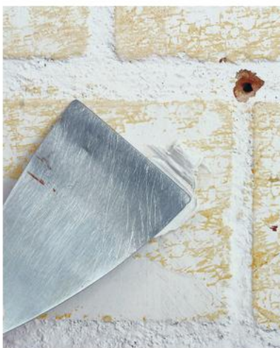
LÖCHER VERSPACHTELN Zum Schließen kleiner Löcher eignen sich gebrauchsfertige Kunstharzspachtelmassen.
