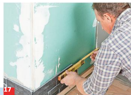
15 ... durchkämmen. Dann den ersten Stein setzen und an der Ecke ausrichten. Kleber immer nur auf kleine Flächen auftragen.
