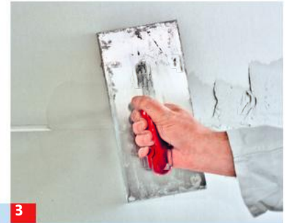
3 Beim Verspachteln der Fugen die Masse zuerst quer einarbeiten, dann in Längsrichtung sauber abziehen.
