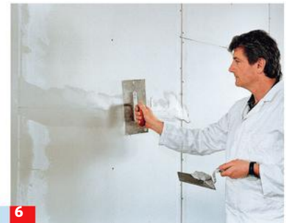
6 ... mit Kelle andrücken und Masse glatt darüber abziehen. Ggf. mit gebrauchsfertigem Feinspachtel überarbeiten.
