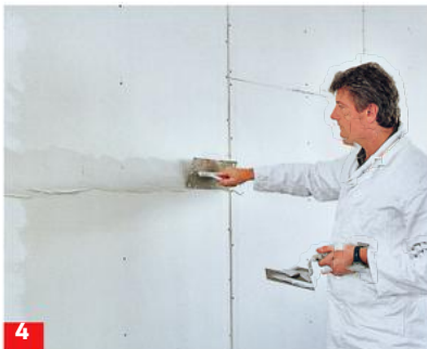
4 Je nach Fugenkante/Materialbedarf nach dem Trocknen überstehende Spachtelgrate abstoßen/abschleifen.
