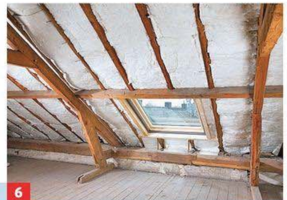
6 ... kann man auch unter der Decke dämmen. Hier bleibt das Dach offen und es wird bis zum First gedämmt.
