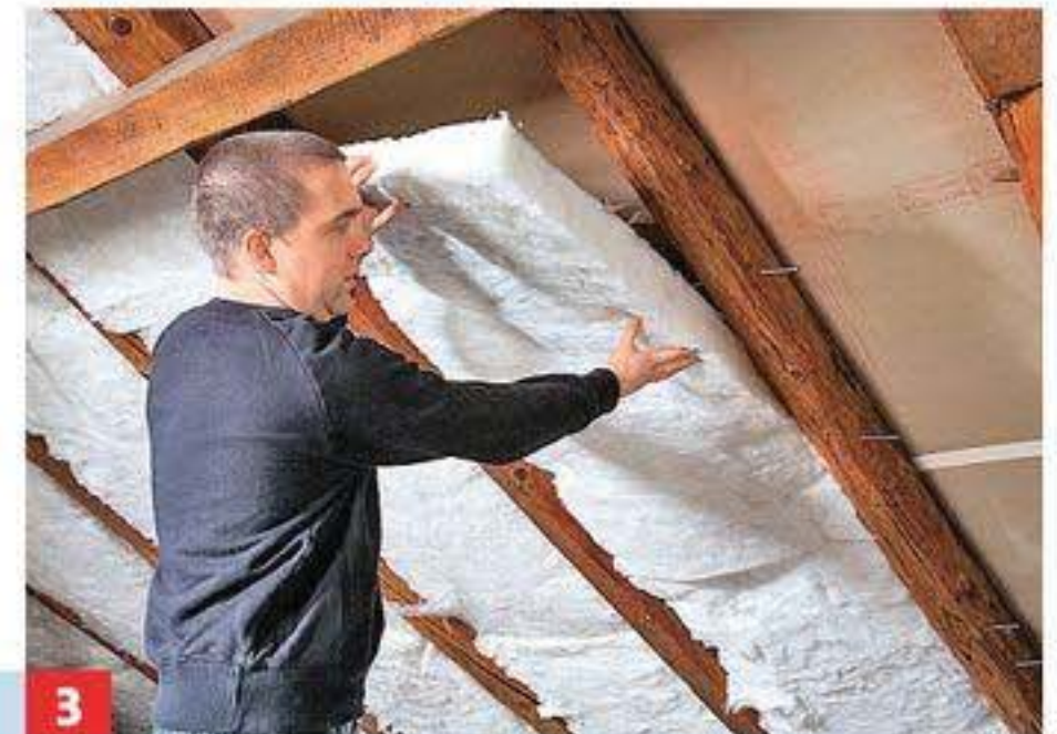
3 Den Dämmstoff bündig mit der Sparrenunterseite zwischen die Sparren klemmen.
