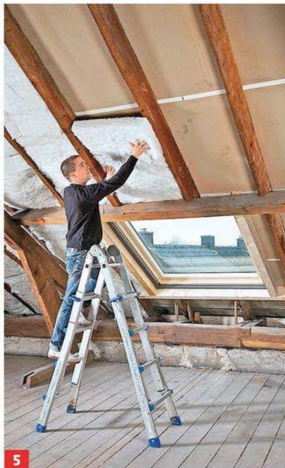
5 Für höhere Dachstühle sollte man entsprechend hohe Leitern bereithalten. Wird die Decke noch abgehangen, ...
