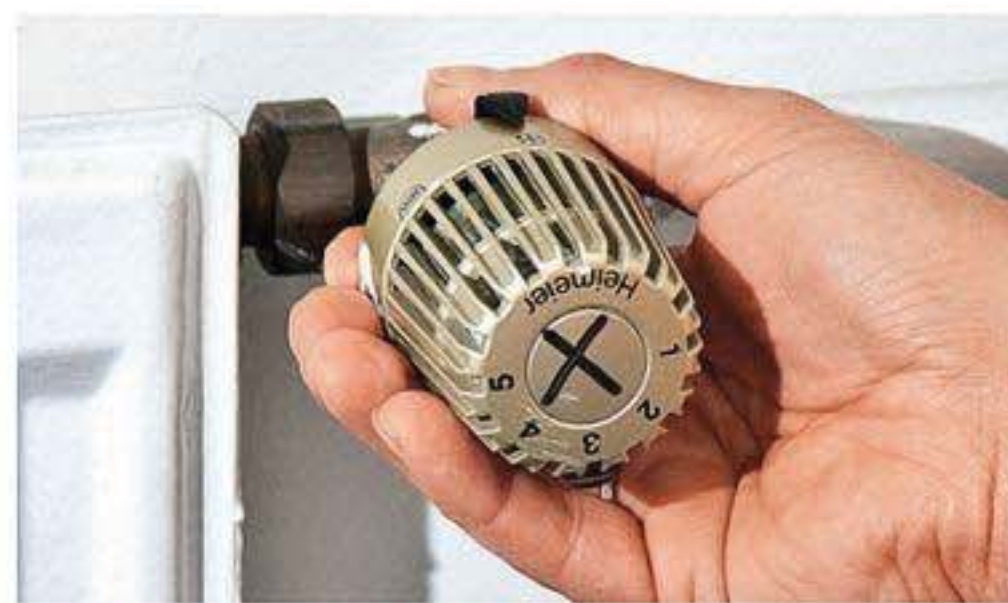
KLEINTHERMOSTATE beeinflussen das Temperaturniveau in einzelnen Räumen.
