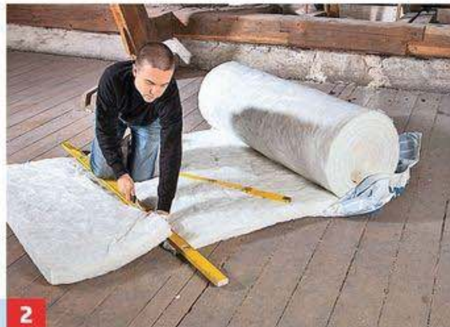
2 Mittels Messer die 80-mm-Zwischensparrendämmung entsprechend zuschneiden (gemessener Abstand plus 1 cm).
