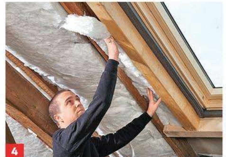
4 Auch schmale Lücken, hier entstanden durch neue Hilfssparren, vollständig dämmen.
