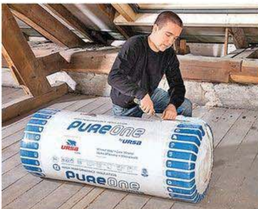
Der Dämmfilz ist aufgerollt und kompakt verschweißt. Folie einfach auftrennen und Dämmung entrollen.
