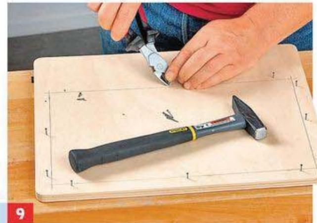
**9** ... zuschneiden. Dann werden Drahtstifte rundum etwas außerhalb der Markierung eingeschlagen und abgekniffen.
