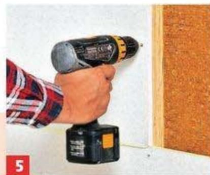
**5** ... auftragen. Platten auf Stoß setzen, Fugenversatz von 200 mm einplanen.
