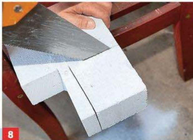
**8** Porenbeton lässt sich ganz einfach mit einem Fuchsschwanz passend zusägen, sogar abschleifen ist möglich.
