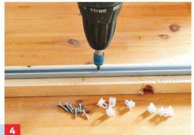
**4** Nun eine einläufige Gardinenschiene auf die eigentliche Führungslatte schrauben.
