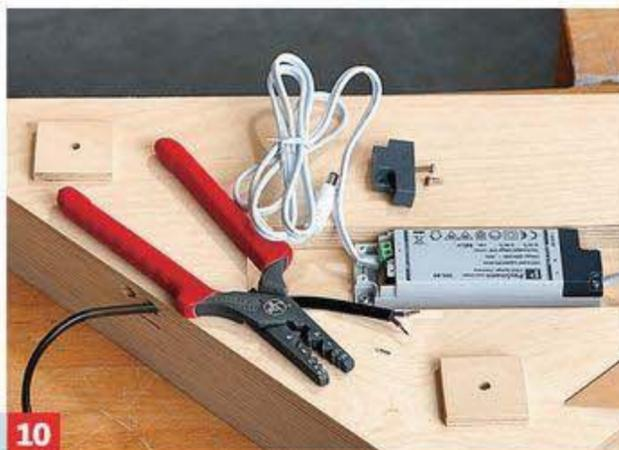
**10** Trafo festschrauben, Anschlusskappen lösen und die Schlauchleitungen gegen die angeschlossenen Kabel tauschen.
