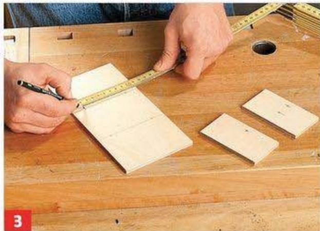
**3** Markieren Sie die Positionen der Neodym-Magnete sorgfältig auf der Front. Dann die Montagebohrungen und ...
