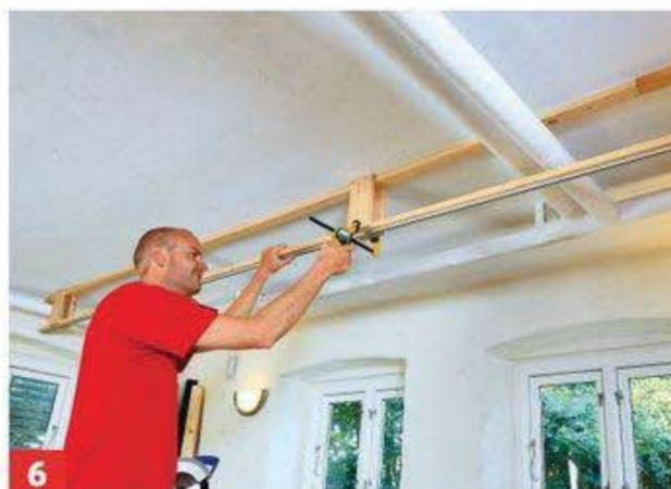
**6** Fixieren Sie sie zunächst mit Zwingen. **Tipp:** Wenn die Führungslatte aus mehreren Teilen besteht, sollte der ...
