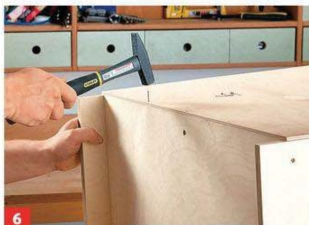
**6** Die Rückwand wird mit Nägeln am Boden und den Seiten befestigt.
