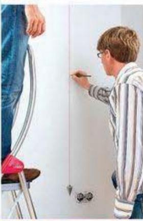
Mittels Senklot, dessen Schnur man unter der Decke mit einem Nagel befestigen kann, lässt sich auch eine senkrechte Linie zeichnen. Mit einer langen Wasserwaage ist es aber einfacher!
