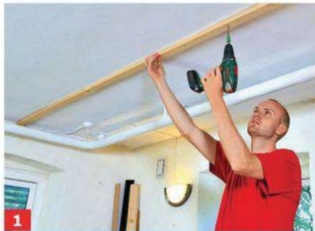
**1** Bringen Sie an der Decke über die gesamte Raumlänge eine Dachlatte mit geeigneten Dübeln und Schrauben an.
