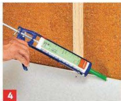
**4** Platten im Abstand von 250 mm verschrauben, zwischen den Platten Fugenkleber ...
