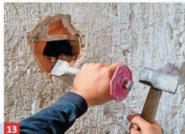
**13** ... die nötige Öffnung in den Schornstein markieren. Diese dann mit Hammer und Meißel, ggf. mit Bohrhämmer vornehmen.
