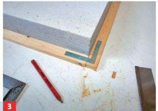
**3** ... dann ggf. eine Holzschalung um die positionierten Platten anfertigen, um einen glatten Untergrund anzulegen.
