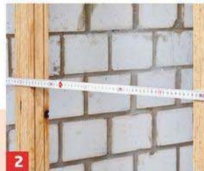
**2** ... alle 70 cm verdübeln. Ständer einsetzen, Achsabstand bei 10-mm-Platten 50 cm.
