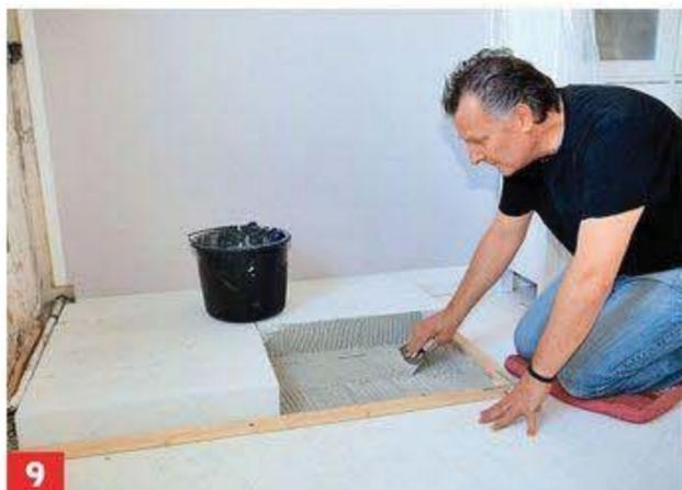
**9** Setzen Sie so nach und nach den Sockel aus Planbauplatten zusammen. Vor dem Fliesenlegen die Oberfläche grundieren.
