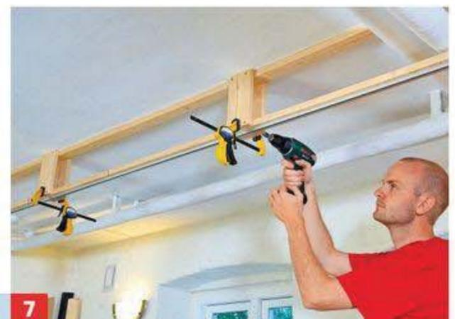
**7** ... Stoß von einer Lasche gestützt werden. Jetzt die Laschen mit der Führungslatte verschrauben.
