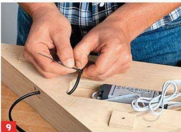
**9** Als Zugentlastung im Lampenfuß dient ein stramm festgezogener Kabelbinder für die Eingangs- und Ausgangsleitung.
