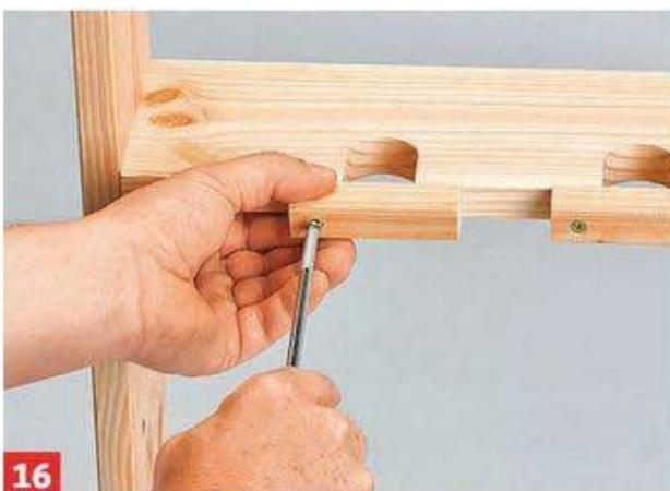
**16** Damit die Geräte nach vorne sicheren Halt haben, werden an einem Brett Riegel angebracht.
