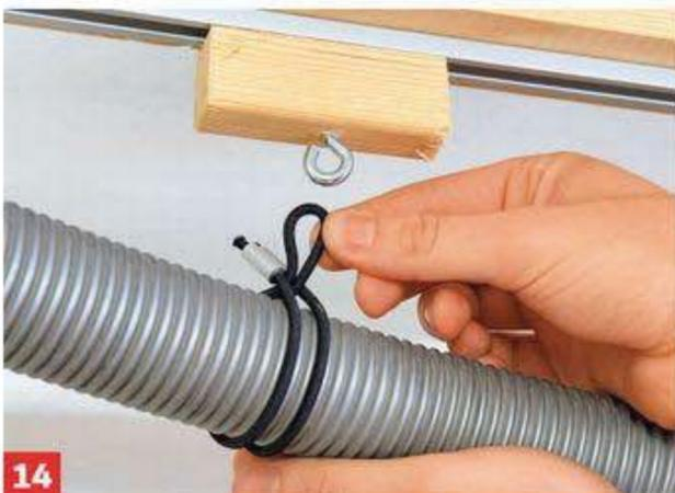
**14** ... übrig ist, um die durchgeführte Schlaufe in die aufgebogene Ösen-schraube einzufädeln.
