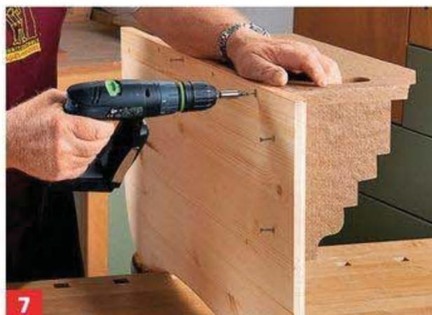
**7** Bohren Sie einige Löcher im Bereich der Wände (halbe Materialstärke), senken diese von der Rückseite und schrauben ...
