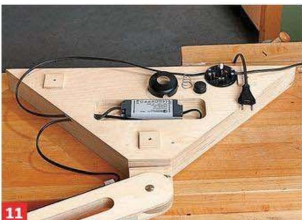
**11** Den Tret-Zwischenschalter an der gewünschten Stelle der Eingangsleitung einbauen und den Stecker montieren.
