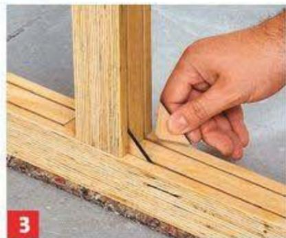
**3** In die Nuten zwischen Ständer und Boden- bzw. Deckenprofil Montagechips stecken.
