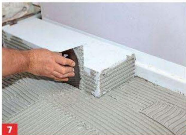
**7** Den Klebemörtel dünn mit einer Zahnkelle bzw. mit kleinem Zahnspachtel aufziehen, auch die Stöße vermörteln.
