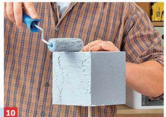
**10** Gestaltet haben wir die Teile mit *Beton-Art* von *Alpina*. Zuerst die Basis mit dem Pinsel oder der Rolle außen auftragen.
