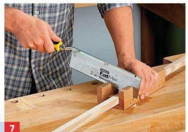
**7** Damit die Kisten rundum gut belüftet sind, liegen sie auf Kiefernholzleisten (20x20mm) auf. Diese abmessen und ...
