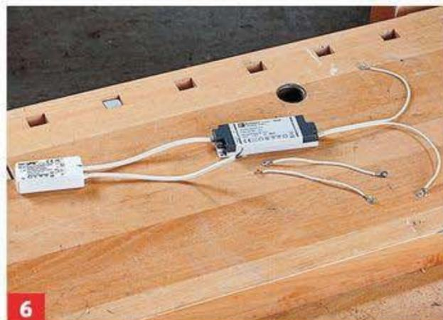
**6** Auch hier von dem Rest ein Stück abschneiden, auftrennen und beide Kabel mit je zwei Ringkabelschuhen ausstatten.
