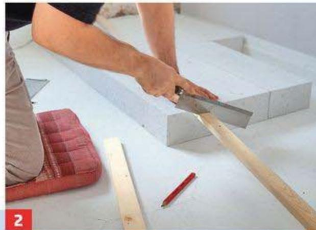
**2** Die Eigenleistung begann beim Mauern des Ofensockels. Planbauplatten aus Porenbeton wunschgemäß zusägen, ...
