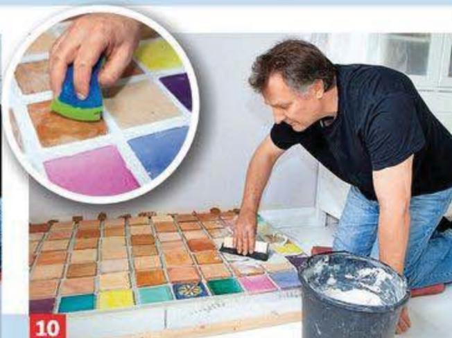
**10** Fliesenkleber mit der Zahnkelle aufziehen, Fliesen verlegen und verfugen. Die Oberfläche abwaschen, die Schalung entfernen.
