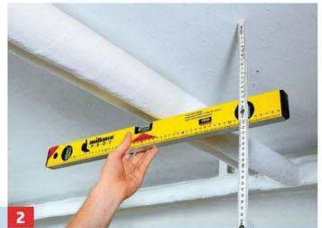
**2** Bei unter der Decke verlaufenden Rohrleitungen zum Abhängen die erforderliche Länge der Laschen ausmessen.
