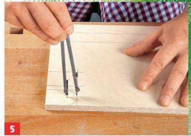
**5** Die Achslager für den Hebel (50x35 mm) aufzeichnen und ausschneiden.
