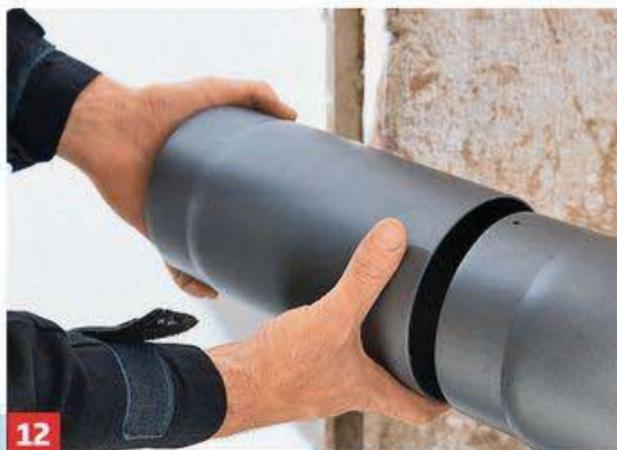
**12** Der Anschlussdurchmesser des Ofens beträgt 130 mm. Entsprechende Rohre probeweise zusammenstecken und ...
