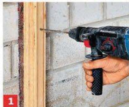
**1** Hölzer mit Dämmstreifen unterlegen; seitlich jeden Meter, an Boden und Decke ...
