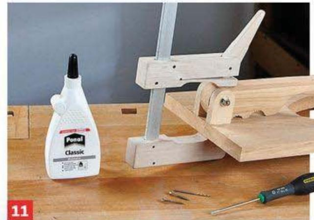
**11** Lager und Grundplatte verleimen und verschrauben, die Zwinde dient nur der Fixierung, bis die Schrauben sitzen.
