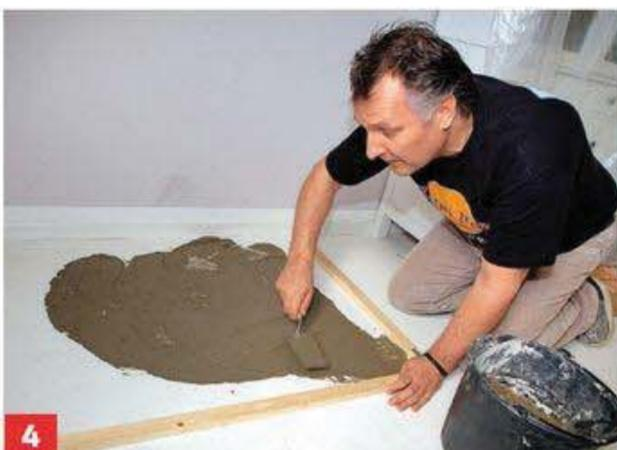
**4** Platten aufnehmen, je nach Schichtstärke Ausgleichsmasse oder geeigneten Estrich anrühren und in der Schalung verteilen.
