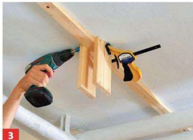
**3** Diese schrauben Sie – im Abstand von etwa 80 bis 100 cm – jeweils rechts und links an die montierte Latte.
