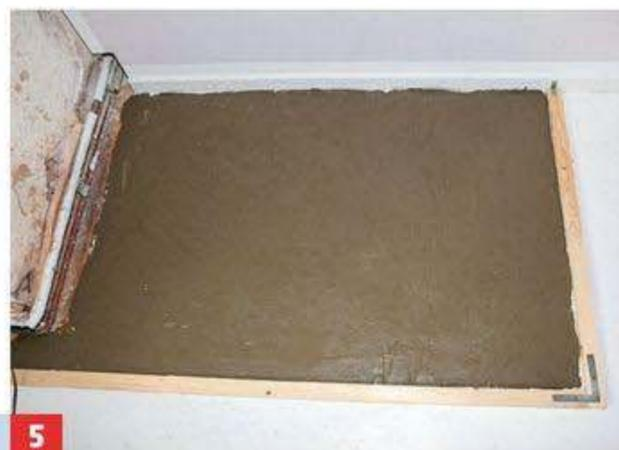
**5** Die Oberfläche absolut eben abziehen, dann das Material trocknen lassen (bis zu 8 Tage – Herstellerangaben beachten!).
