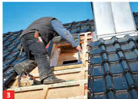
3 Oben und unten Montagelatten wie in der Anleitung skizziert festschrauben, dann erst den Dämmrahmen und ...
