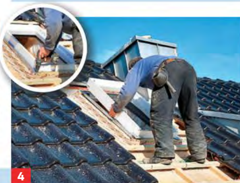
4 ... anschließend den Fensterrahmen auflegen und an der Lattung festschrauben.
