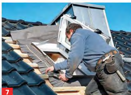
7 ... Dampfsperrschürze luftdicht verkleben, dann eine Anschlussschürze für die Regendichtheit befestigen.
