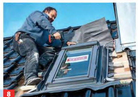
8 Es folgt die Montage des Eindeckrahmens. Abschließend die Dachpfannen ans Fenster heranlegen.
