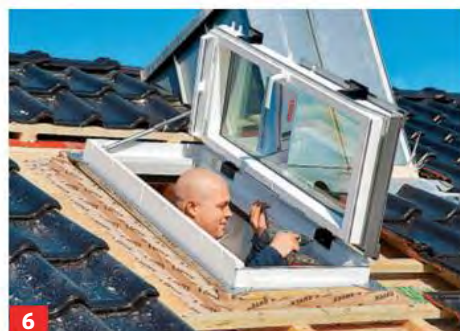
6 Scharniere und Gasdruckfedern, die die Öffnungsfunktion unterstützen, müssen befestigt werden. Rund ums Fenster ...
