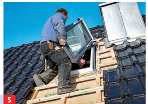
5 Nun kann der Fensterflügel herausgereicht und eingehängt werden.
