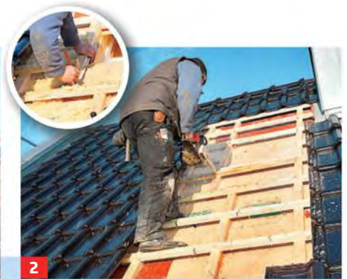
2 ... entsprechenden Stelle öffnen, also Dachpfannen aufnehmen sowie Lattung und Dämmung heraustrennen.
