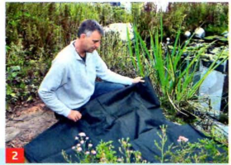
Im unmittelbaren Uferbereich wird als Schutz gegen durchwachsende Pflanzen ein Wurzelvlies ausgelegt.
