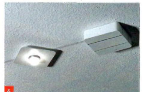
**4** Die Leuchten werden auf dem Socket per Magnethaftung fixiert. Sie können gerade oder schräg ausgerichtet werden.
