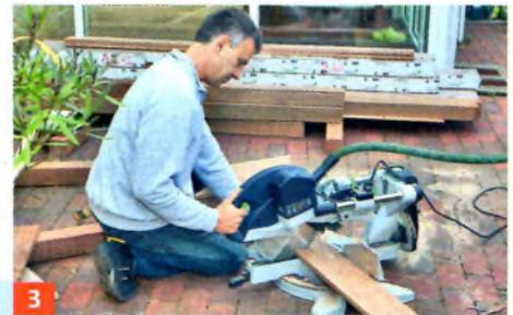
Schneiden Sie dann mit der Kappsäge die einzelnen Dielen zu. Bedenken Sie dabei die Nut-und-Feder-Verbindung.
