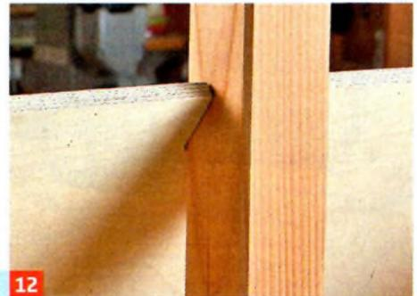
**12** ... Kantholz hineinstellen und anhand der Ausklinkung mit einer Wasserwaage den lotrechten Stand prüfen.
