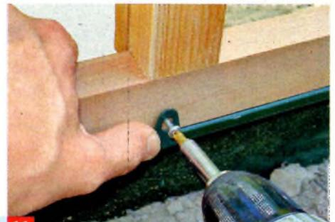
11 Mit Klammern werden die Wände innen am Fundament fixiert. Da auch die Zwischenstege der Wände verschraubt sind, ...
