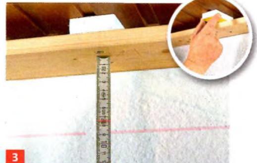
Mit Hilfe eines Lasergerätes wird ein gleichmäßiges Niveau der Holzlatten ermittelt, ggf. muss man manche Punkte ...
