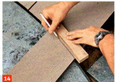
**14** An der Rundung des Poolrands zeichnen Sie den gewünschten Schnitt mit einer kleinen Hilfsleiste an.
