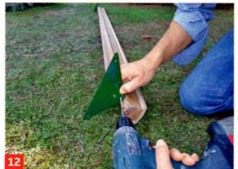
12 ... sollten Sie Ihre Schrauben dort leicht versetzt einbringen. Am Firstbalken montieren Sie dann die beiden Halbleche.
