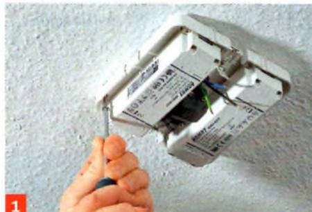
**1** Der Anschluss des Trafos erfolgt an der Brennstelle, die beiden Ausgänge liegen einander gegenüber. Pro Seite lassen ...
