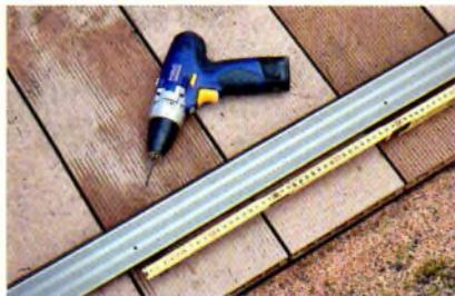
Bohren Sie die Löcher zum Verschrauben mit max. Abstand von 400 mm vor.
