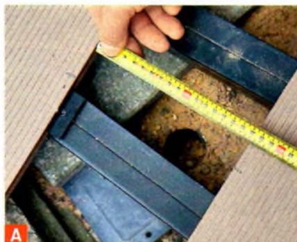
**A** Messen Sie die Lage der einbetonierten Aufnahmerohre für die Leiter aus.
