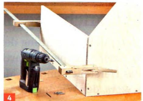
4 Die beiden Platten mit einer langen Zwinne fixieren, die Traufplatte durch die Giebellöcher vorbohren und verschrauben.
