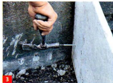
Die Seitenwände für optimalen Halt an den alten Betonstufen befestigen.
