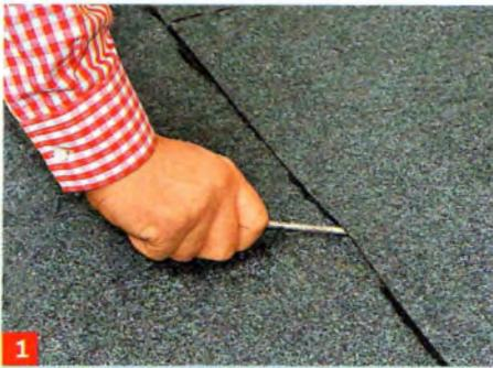
**1** Die Reparatur einer Bitumenbahn ist nicht schwer: Oberfläche abfegen, lose, undichte Stellen ein wenig anheben.
