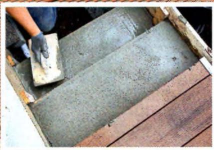
**Ab Seite 12:** Auf eine alte Treppe werden neue Betonstufen gesetzt.
