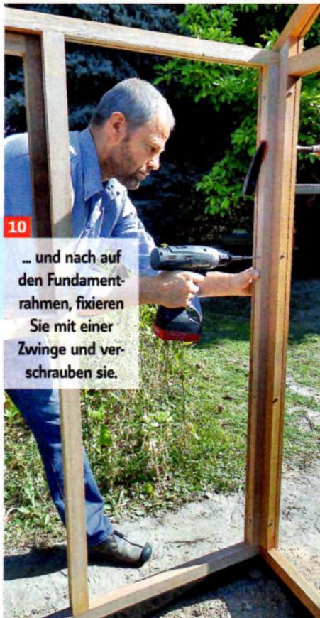
10 ... und nach auf den Fundamentrahmen, fixieren Sie mit einer Zwinde und verschrauben sie.
