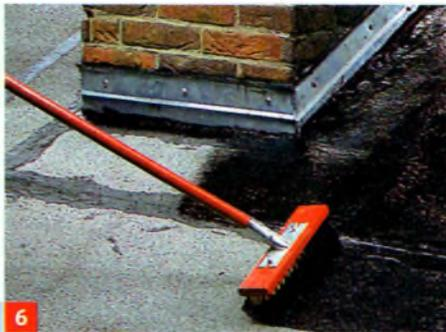
**6** ... neue Dachbahn (z.B. Typ R 333 oder R 500) andrücken; ggf. Bitumenschutzlack auftragen (diesen mit Sand bestreuen).
