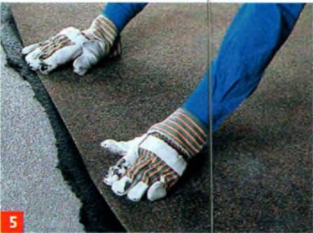
**5** Schadhafte Stellen können auch mit einem neuen Bahnenabschnitt belegt werden. Spachtelmasse auftragen und ...
