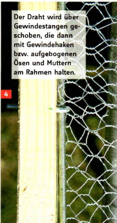
Der Draht wird über Gewindestangen geschoben, die dann mit Gewindehaken bzw. aufgebogenen Ösen und Muttern am Rahmen halten.
