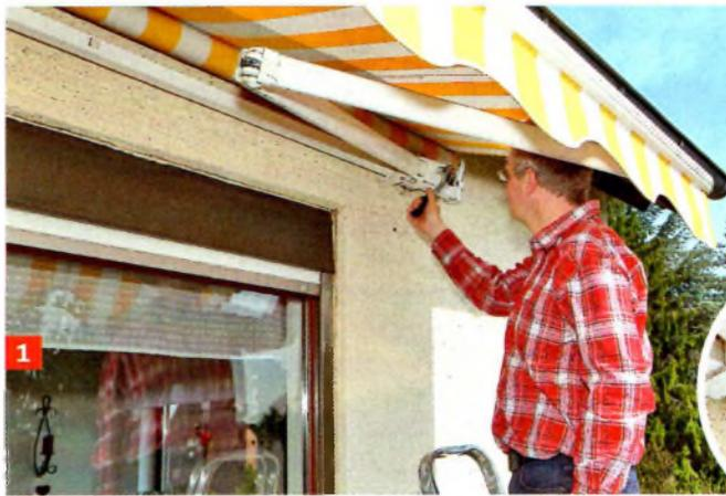
Gelenkarm-Markisen können zur Reinigung abgesenkt werden. Stellschraube bis zum Gewindeende herausdrehen.
