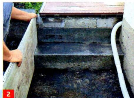
Deshalb wird mit Holz eine passgenaue Verschalung gebaut, um zwei neue Stufen aus Beton zu gießen.
