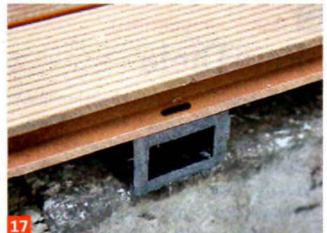
**17** Am oberen und unteren Ende der Terrasse wird die Diele bündig in einem Langloch verschraubt.
