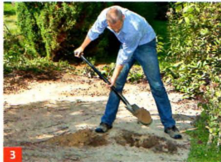
**3** Dort graben Sie etwa 60 bis 80 cm tiefe und im Durchmesser etwa 30 cm große Löcher für die Betonfundamente.
