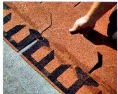
**Große Klebefelder an den Dachschindeln erlauben die Verlegung auch bei flach geneigteren Dächern.**
