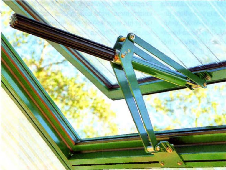
**BELASTUNG:** Bis zu 60 kg darf das Dachfenster schwer sein, da der Öffner in der Regel nur das halbe Gewicht trägt.
