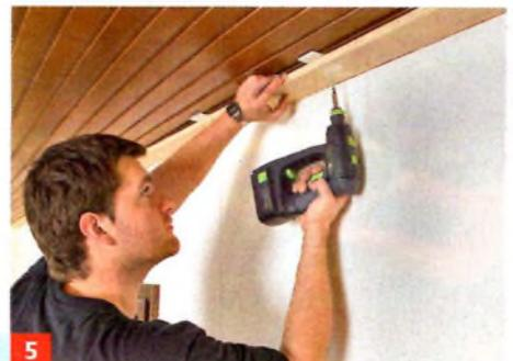
Die Holzlatten dann durch die untergelegten Holzstücke an die Decke schrauben.
