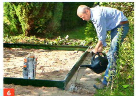
**6** ... Wechsel mit Wasser herstellen. Schon zwei Tage später sind sie so fest, dass Sie den Aufbau fortsetzen können.
