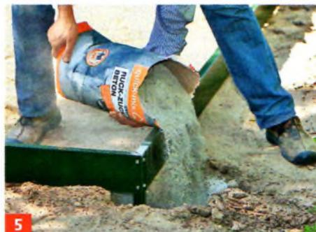
**5** Unterfüttern Sie hierzu ggf. den Rahmen. Die Fundamente können Sie z. B. mit Ruck-Zuck-Beton schichtweise im ...
