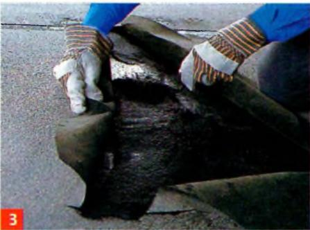
**3** Hohlstellen aufschneiden, zurückschlagen und Bitumenspachtelmasse auf den trockenen Untergrund auftragen.
