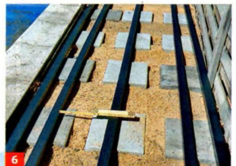
6 Legen Sie nun die Unterkonstruktion aus. Die Abstände sind im Randbereich kleiner, ansonsten bei maximal 35 cm.
