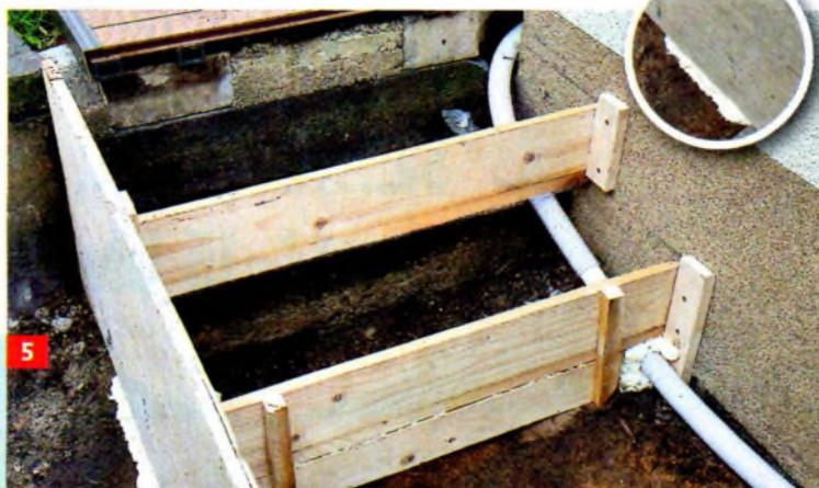
Damit kein Beton aus der Schalung läuft, größere Lücken mit Bauschaum abdichten.
