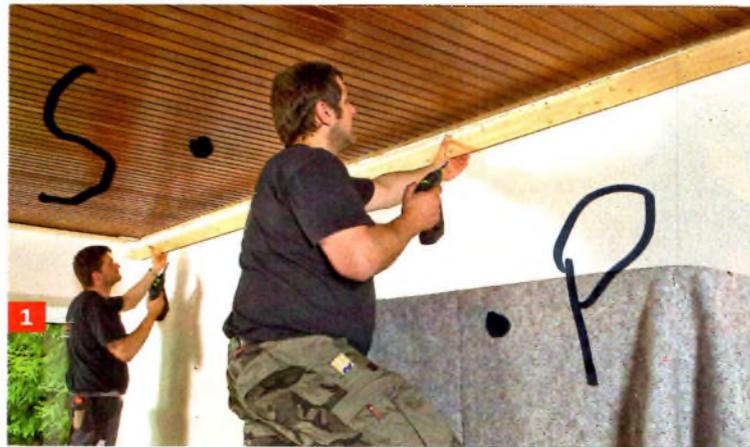
Zunächst werden Holzlatten umlaufend am Deckenabschluss montiert.
