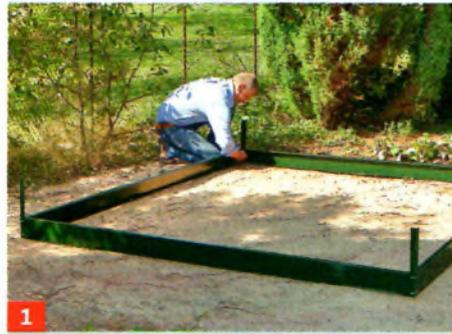
**1** Verschrauben Sie den Fundamentrahmen und die Ankerspieße an Ort und Stelle: Der Boden sollte einigermaßen eben sein.
