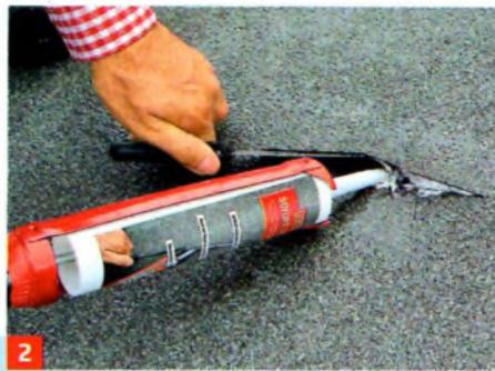
**2** Für Bitumenbahnen geeigneten Dichtstoff, hier Bitumen-Kautschuk, unter die angehobene Bahn spritzen und diese andrücken.
