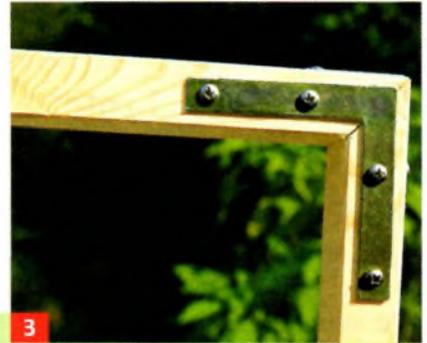
**3** Verstärken Sie die Ecken mit Flachwinkeln, dann wird der Rahmen stabiler. Nehmen Sie kurze Schrauben.
