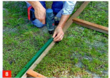
Zunächst wird die untere Führungsschiene der Schiebetür vorne an der Eingangsgiebelwand verschraubt.
