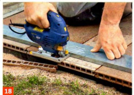
**18** Zum Schluss zeichnen Sie eine gerade Linie und längen die Dielen am Rand mithilfe einer Führungsschiene ab.
