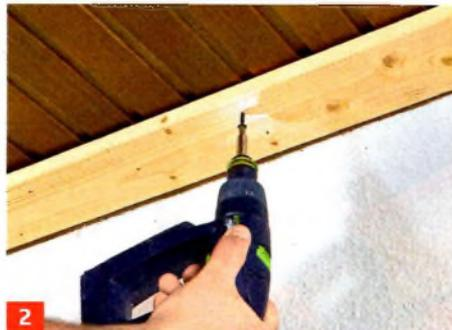
In diesem Fall können sie einfach mit Holzschrauben an der alten Paneeldecke befestigt werden; besser vorbohren!
