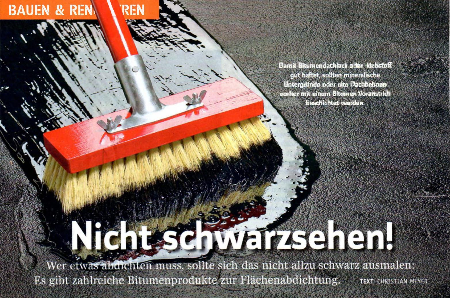
Damit Bitumendachlack oder -klebstoff gut haftet, sollten mineralische Untergründe oder alte Dachbahnen vorher mit einem Bitumen-Voranstrich beschichtet werden.
