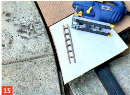
**15** Alternativ können Sie eine Papierschablone anfertigen, den Schnitt anzeichnen und mit der Stichsäge zuschneiden.
