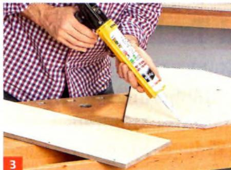
3 Tragen Sie wasserfesten Konstruktionskleber (z. B. aus der Kartusche von Ponal) auf den Plattenstoß Giebel/Traufseite auf.
