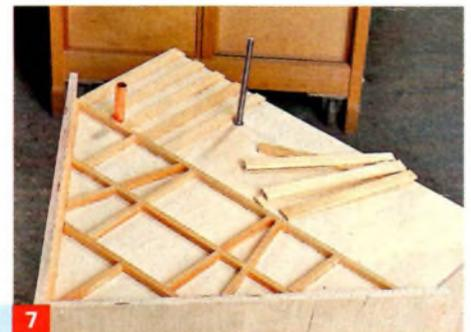
**7** ... die Revisionswand, deren Verschraubungen und das Wasserrohr frei bleiben! Dann kleben Sie die Blendleisten auf.
