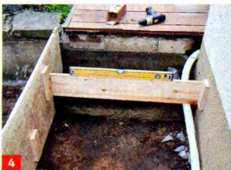
Die Querbretter werden von kleinen Leisten gestützt und hier ebenfalls verschraubt. Ausnivellieren!
