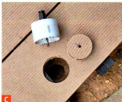
**C** Mit einer Lochsäge ausschneiden und kontrollieren, dann die Diele festschrauben.
