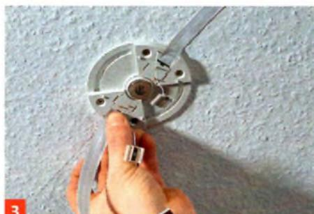
**3** ... folgen. Das Flachkabel zuschneiden, Klebeschutzband abziehen und auf die offenen Kabelschuhe kleben.
