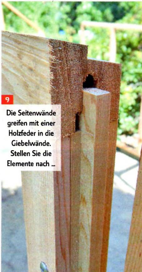
9 Die Seitenwände greifen mit einer Holzfeder in die Giebelwände. Stellen Sie die Elemente nach ...
