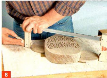
**8** Die Innenseiten der Flügel mit wasserfestem Kleber bestreichen, mit einer Klemme anpressen und trocknen lassen.
