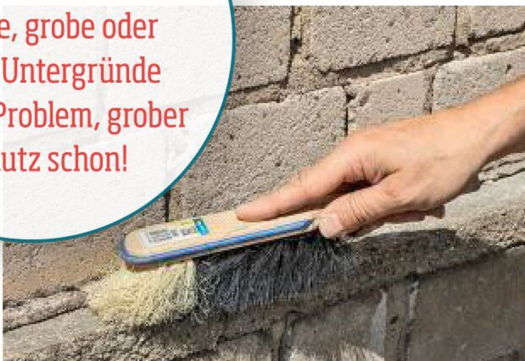
Lose Verschmutzungen kehrst du einfach ab, bevor du das Klebeband anbringst.
