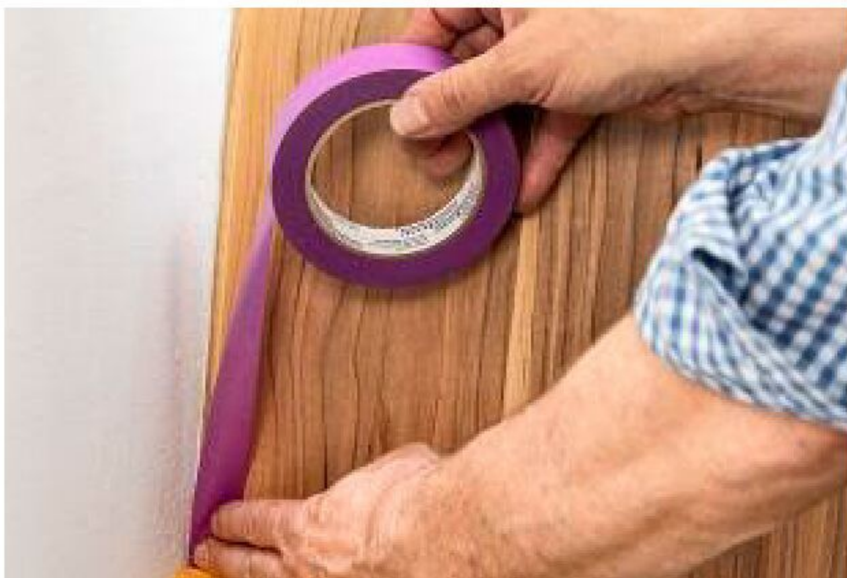
Das Band ist für glatte bis raue Untergründe geeignet. Dank der leicht reduzierten Klebekraft werden die Tapeten geschont.
