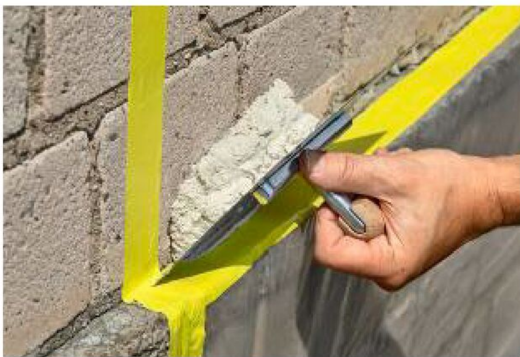
Das Gewebekband (ohne Folie) lässt sich von Hand abreißen, ist mechanisch stark belastbar und bis zu 14 Tage anwendbar.
