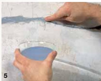
1 Zum Anmischen von Gips und pulvrigen Spachtelmassen wird das Pulver stets in das Anrührwasser gestreut.
