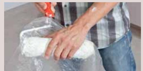
**Frischhaltefolie:** Wenn man die Arbeit mal unterbrechen muss, wird die Farbrolle einfach stramm in eine Folie gewickelt. So trocknet sie nicht aus.
