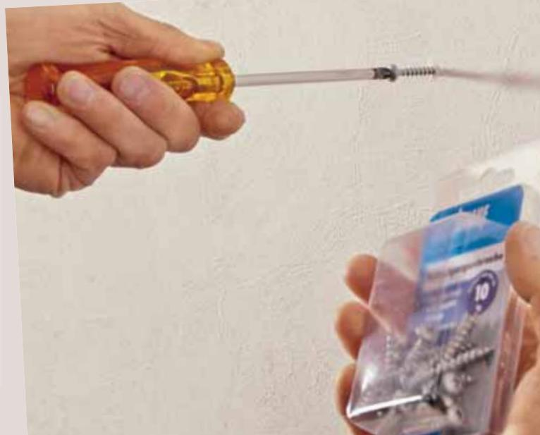
**Schnellmontage:** Die Knauf Befestigungsschraube hält bis zu 10 Kilo, bei üblicher Beplankung aber nur 4 Kilo. Das reicht für die meisten Bilder und Leuchten immer noch aus.
