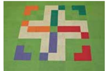
**1** Zuerst wird der Raum komplett mit den Fliesen in einer Farbe ausgelegt. Hierzu den Mittelpunkt des Raums ausmessen und aus der Mitte heraus zur Wand auslegen.
