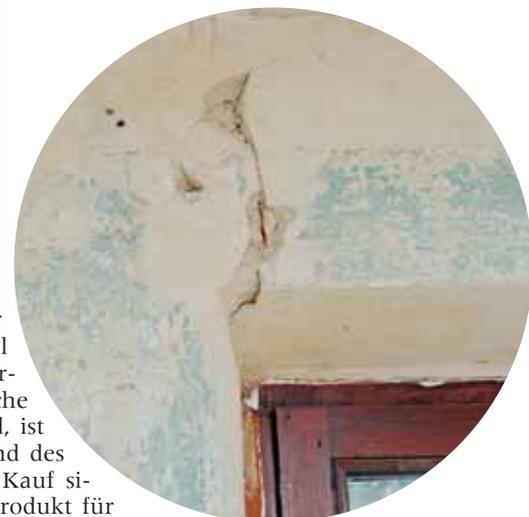
**SPANNUNGRISSE** sind in Altbauten typisch. Sie müssen mit einer Rissbrücke, die Spannungen aufnimmt, geschlossen werden.
