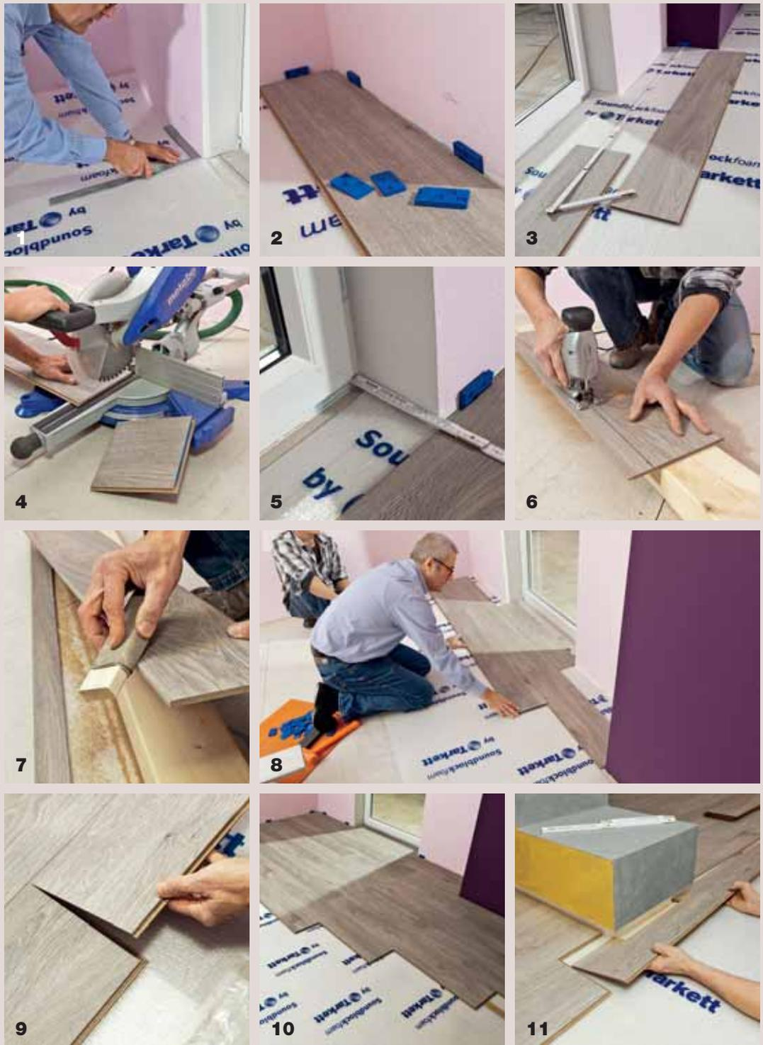
**1** Unter das Laminat kommt immer ein Trittschallschutz. An Nischen oder Vorsprüngen muss er vorm Legen entsprechend zugeschnitten werden. Dieser Trittschallschutz von Tarkett ist zusätzlich folienkaschiert mit überlappendem Folienstreifen. Das verhindert Feuchtigkeitstransport, beispielsweise aus frischem Betonestrich.
