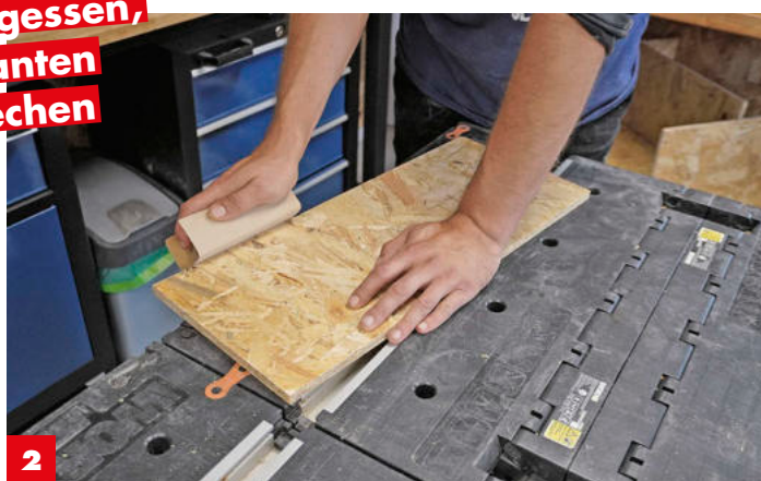
2 Kleinere Bauteile wie die Regalböden schleifen wir dagegen lieber von Hand mit dem Klotz .
