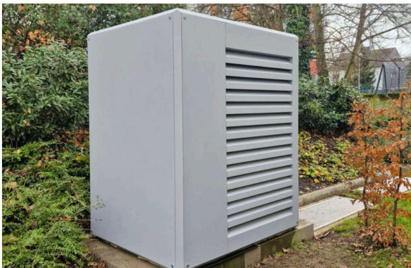
Die Schallschutzhauben verringern nicht nur den Geräuschpegel um bis zu 20 dB , sie sehen dabei noch attraktiv aus.
