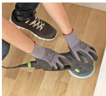
... oder einem Exzenter-schleifer zu Leibe rücken.
