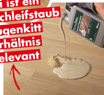
Die Fugen werden geschlossen.
