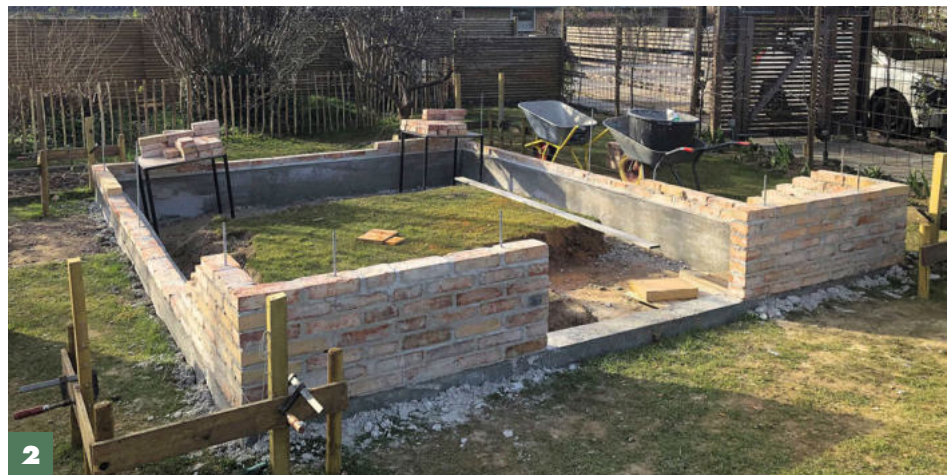
2 Zuerst wird eine Ecke aufgemauert. Sie dient als Bezugspunkt für die weiteren Lagen. Die Gewindestangen laufen bis zur Oberkante der Brüstung mit.
