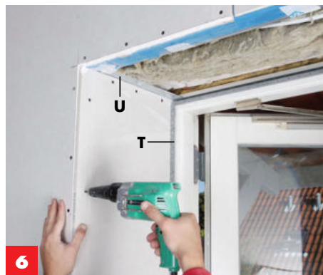
6 Zuletzt die Laibungsplatten zuschneiden, in das Kantenprofil (T) schieben und an der Unterkonstruktion verschrauben. Außenkanten mit Eckschutzprofilen (V) ...
