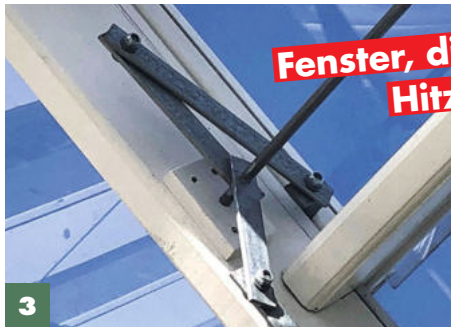
3 Kippbare Fenster erleichtern das Lüften. Im Beispiel werden sie über eine selbst gebaute Vorrichtung mit Griff bedient.
