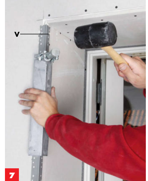
7 ... vor Beschädigungen schützen. Hier wird ein „Cinch-On“-Profil gesetzt. Sie können aber auch selbstklebende Eckprofile anbringen.
