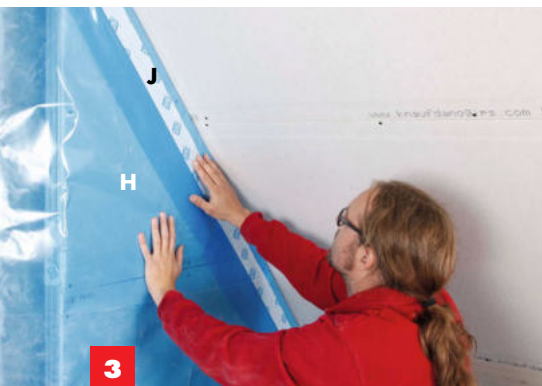
3 Den Folienüberstand (H) der Schräge auf die Giebelwand führen, mindestens 10 cm überlappen lassen und alle Stöße mit Systemklebeband (J) luftdicht verkleben.
