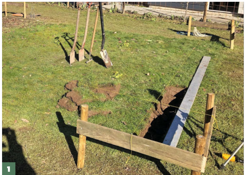
1 Fundament abstecken: An den Ecken werden Pflocke gesetzt, dazwischen markieren gespannte Schnüre den Verlauf der späteren Fundamentrinne.
