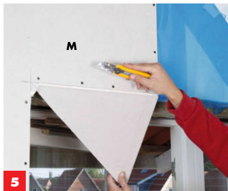
5 Gipskarton-Überstände an Laibungen erst nach dem Befestigen entfernen. Per Stichsäge schräg bis zur Ecke sägen, Karton an der Kante einschneiden und abbrechen.
