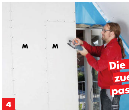
4 Nun die zweite Gipskartonlage (M) montieren, aber enger verschrauben als die erste Lage : alle 20 cm an den Plattenkanten, alle 30 cm auf der Mittellinie.
