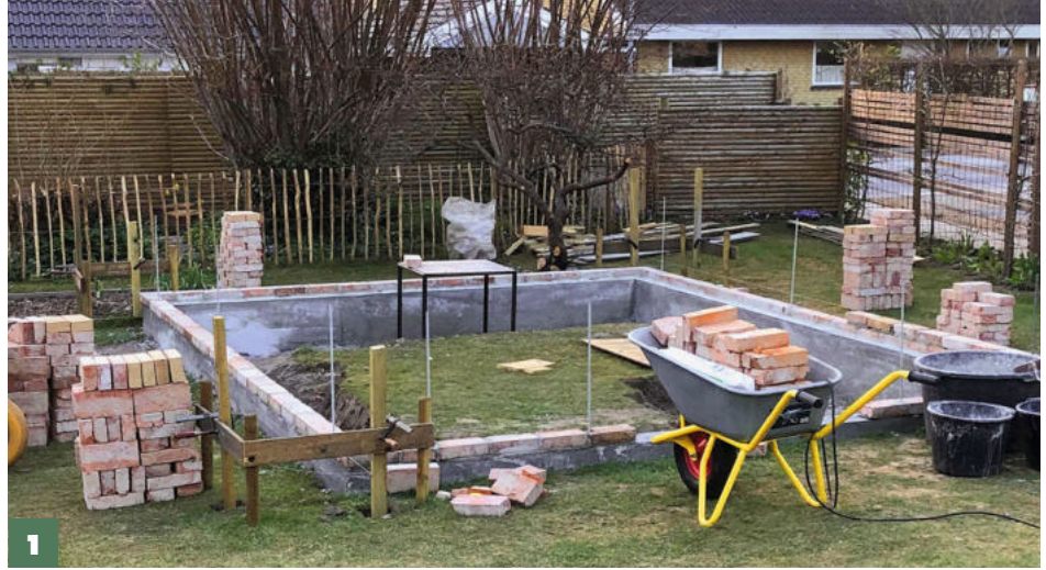
1 Eine Mauersperrbahn schützt die Brüstung vor aufsteigender Feuchtigkeit. Die Ziegel werden zunächst lose ausgelegt, um Verband und Zuschnitte zu prüfen.
