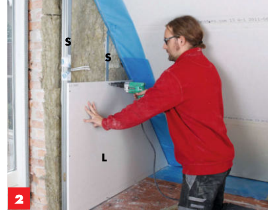
2 Die erste Lage (L) mit kurzen Schnellbauschrauben an den CW-Profilen (S) befestigen. Für die erste Lage genügen Schraubabstände von etwa 40 cm.
