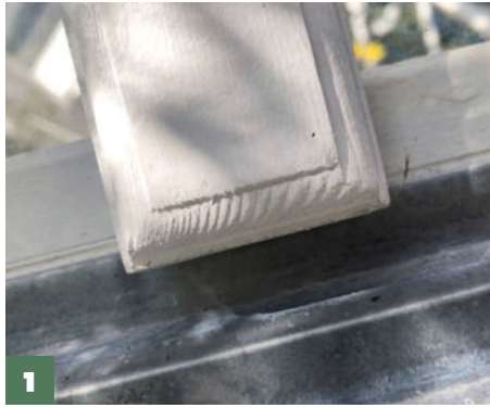
1 Die Glasleisten halten die Scheiben am Platz. Ein gefrästes Profil wertet die Leisten optisch auf und sorgt für saubere Kanten.
