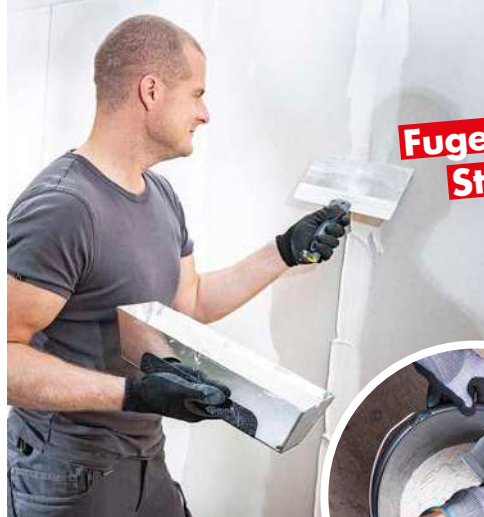
Spachtelkasten: sauber abstreifen, effizient entnehmen, mit einer Hand komfortabel verarbeiten (Wolfcraft)
