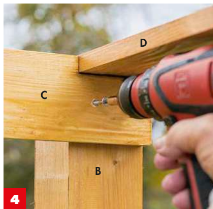
4 Die längere innere Vertikalstrebe (C) ausklinken (siehe Skizze); mit Spanplattenschrauben (50 x 60-mm) fixieren.
