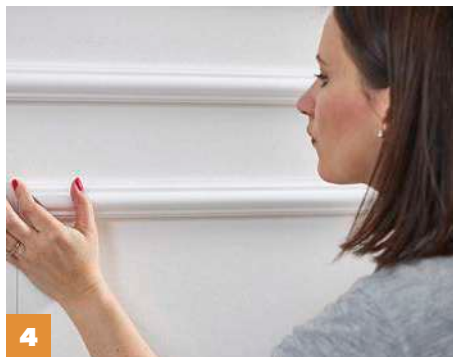
4 Leisten an die Wand kleben und nochmals mit Wasserwaage oder Laser prüfen, ob alles gerade ausgerichtet ist .
