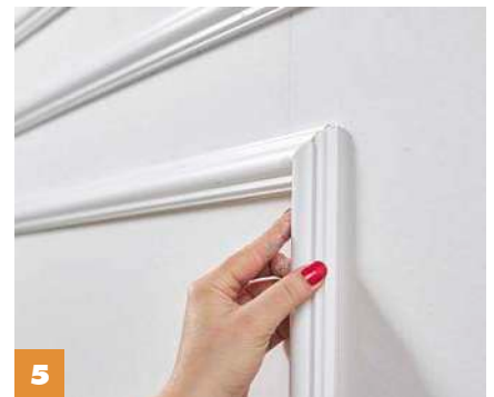
5 Kurz andrücken . Bei Bedarf können Sie die Klebekanten der Leisten mit etwas Acryl verschließen.
