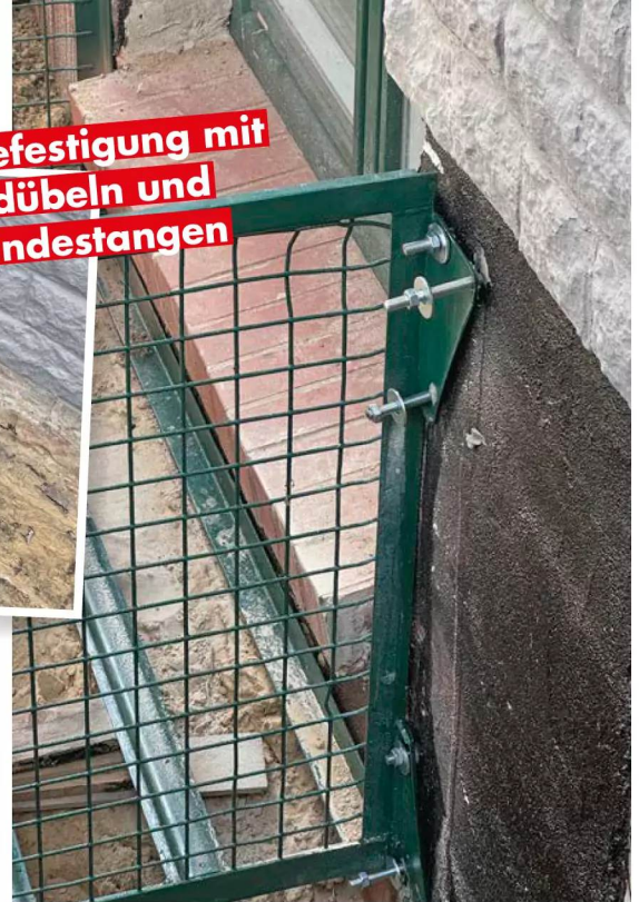
Nach dem Aushärten des Injektionsmörtels konnte die ehemalige Gitterbox, jetzt Lichtschacht, fest mit der Wand verschraubt werden
