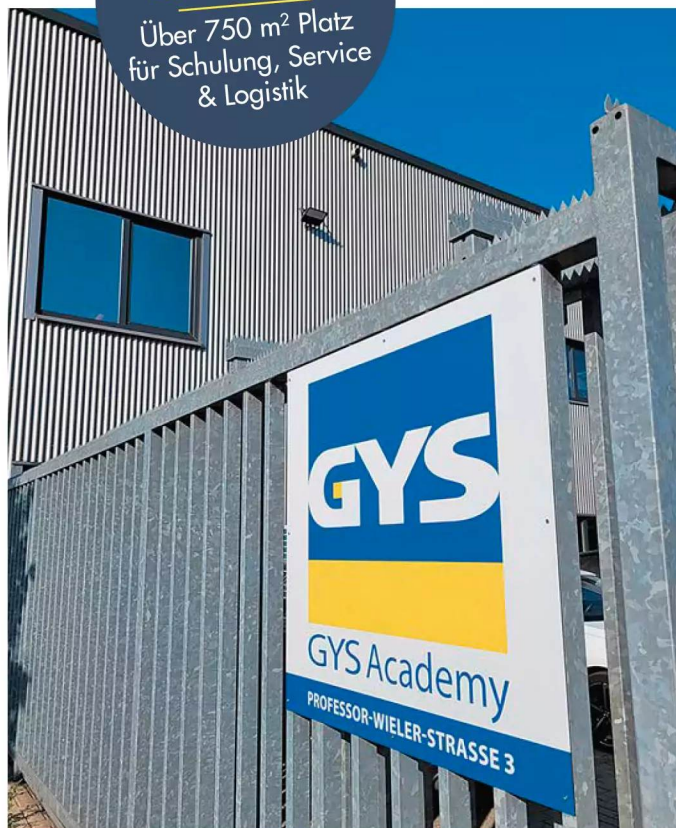
Der Neubau der GYS Akademie bietet moderne Infrastruktur für Schulung, Service und Logistik auf rund 800 m 2 Fläche
