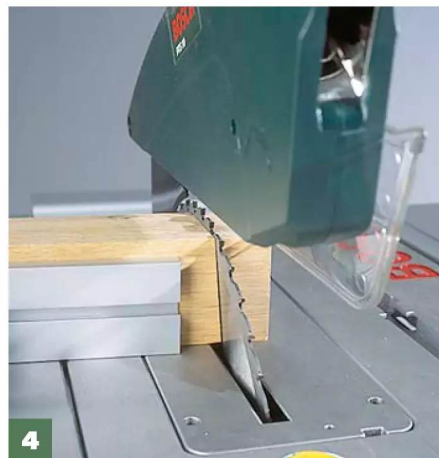
4 Beim Zuschneiden der Pfosten erhalten die Enden jeweils eine parallel verlaufende Schrägung von vier Grad.
