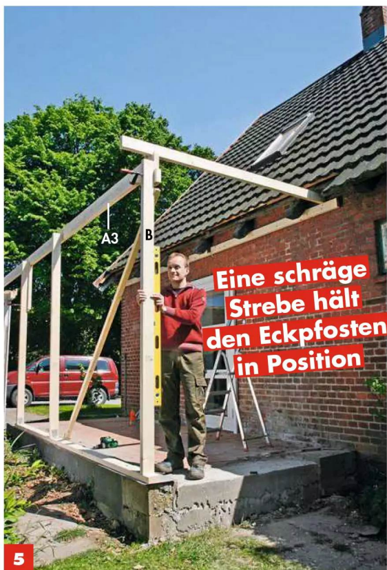
5 Obere Pfette (A3) an den Pfosten (B) befestigen, Eckpfosten in die andere Richtung loten und fixieren. Restliche Pfosten lotrecht zur Fassadenebene ausrichten.
