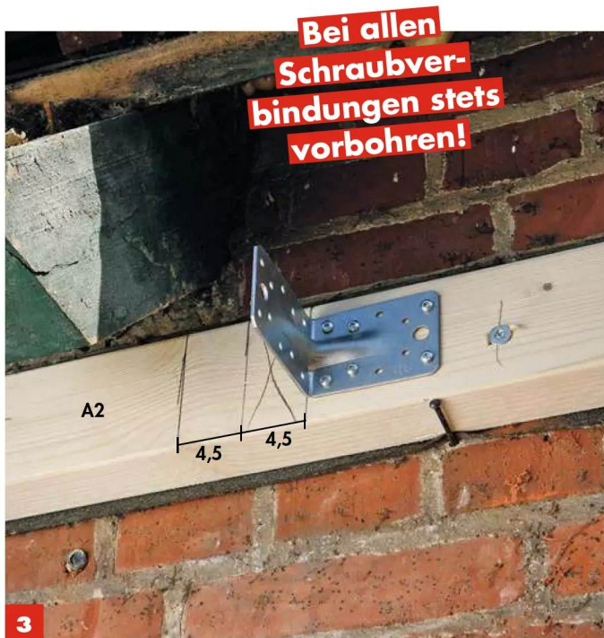
3 An der Auflage (A2) werden Winkel zur Montage der Balken (C) befestigt – mit 9 cm Abstand zu den Haussparren (= Breite des Balkens (C) + Breite der Stützen (E), die die Sparren (D) tragen).
