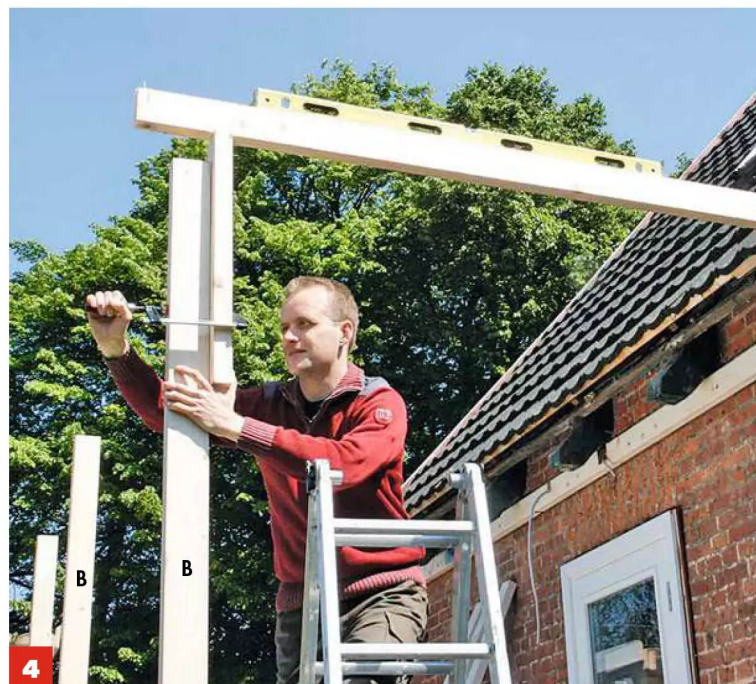
4 Nun die Pfosten (B) an beiden Enden und in der Mitte aufstellen. Durch Anbringen einer Strebe zur Wandauflage (A2) den ersten Eckpfosten zeitweise fixieren und lotrecht zur Wand ausrichten.
