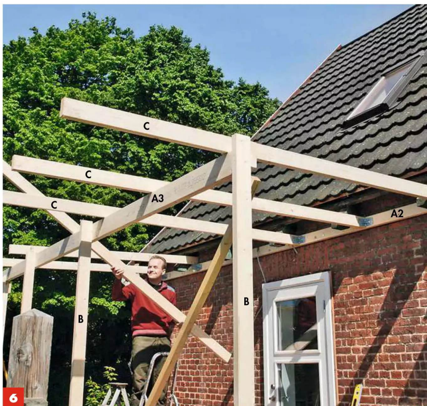
6 An den beiden oberen Längsbalken (A2 und A3) die Balken (C) neben jedem der Haussparren befestigen: an der Wand per Metallwinkeln; an der oberen Pfette (A3) werden sie aufgesetzt und mit Winkeln verschraubt.
