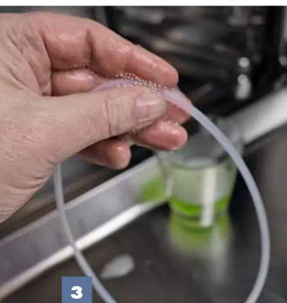
3 Damit die Dichtung nicht beschädigt wird, benetzen Sie sie großzügig mit Spülmittellösung als Gleitmittel.
