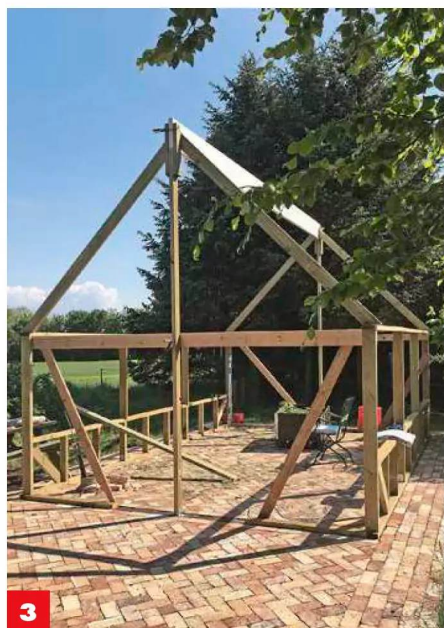
3 Mit einem Testsparren prüfen, ob die Enden überall gut an First und oberer Pfette sitzen. First ausrichten und alle Sparren mit denselben Maßen fertigen. Mit Giebelsparren beginnen, um den First zu sichern.
