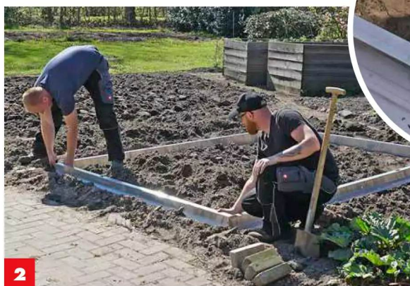
2 Den Fundamentrahmen mit den Winkeln verschrauben und in den Erdgraben setzen. Mit den Ziegelsteinen als Unterstützung der Eckpunkte alles in die Waage bringen.
