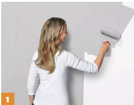
1 Weiße Grundfarbe aufbringen, 125 ml Vollton- und Abtönfarbe dazugeben. Farbmischung mit Kurzflorroller auftragen.
