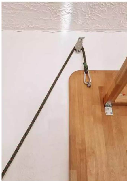
Die Seilschleife wurde mit einem dicken Haken in der Wand verdrübelt – eine von vielen Sicherheitsmaßnahmen
