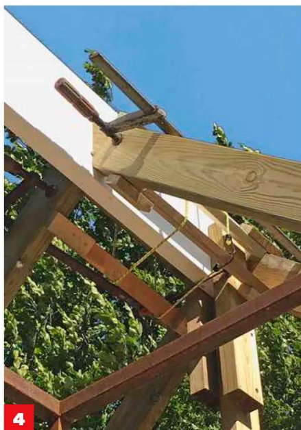
4 Oben werden die Sparren schräg zum First zugeschnitten und mit Schrauben in 5 x 120 mm befestigt. Weit genug unten am First platzieren, um Platz für Glasdach und Abdeckungen zu schaffen.
