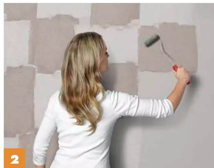
2 Nun beide Farbtöne des Effektpachtels abwechselnd und schachbrettartig auf die Wandfläche auftragen.
