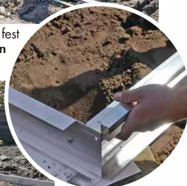
Nun setzen Sie die Bodenprofile für die Hohlkammerplatten in den Rahmen.
