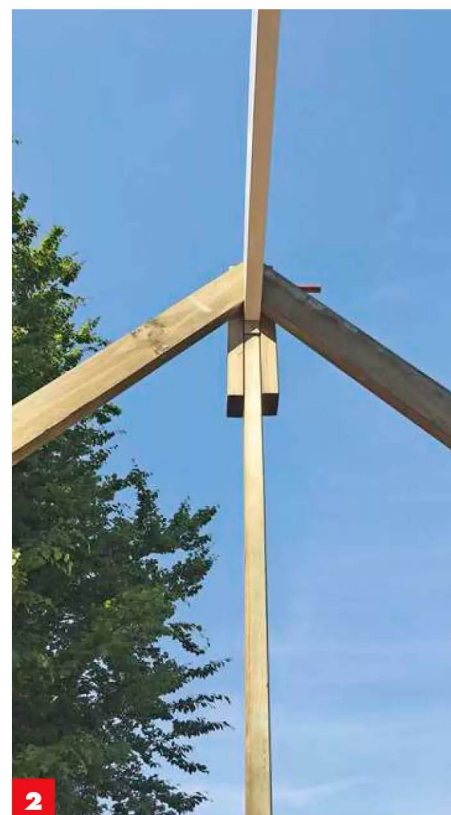
2 Der First wird oben temporär mit zwei Resthölzern abgestützt, um während der Montage der Sparren ein Umfallen zu verhindern.
