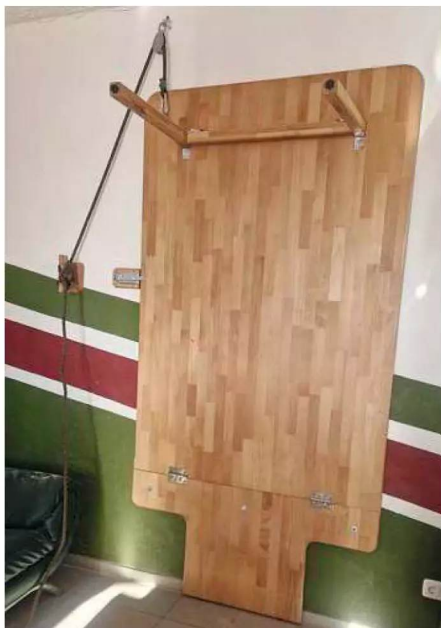
Mit 12er-Dübeln sowie drei massiven Schrauben ist das untere Basisteil fest mit der Wand verschraubt
