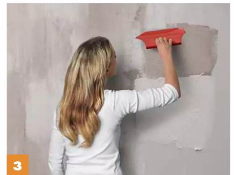
3 Glätter in flachem Winkel ansetzen und mit kräftigem Druck über die Farbfelder ziehen – zügig und gleichmäßig.
