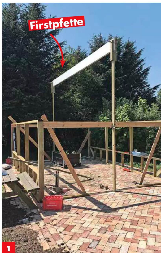
1 Der Firstbalken wird von zwei vertikalen Pfosten getragen, die an der Schwelle und an den Querbalken der Giebel verschraubt werden. Schräg montierte Resthölzer dienen vorübergehend zur Stabilisation.
