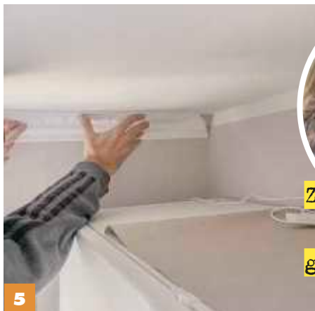
5 Für einen nahtlosen Übergang in den Ecken müssen die Endstücke auf Gehrung geschnitten sein.
