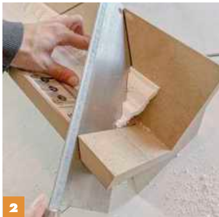
2 Mit einer Gehrungslade für Zierleisten und einer Gehrungsfeinsäge werden die Ecken zurechtgesägt.
