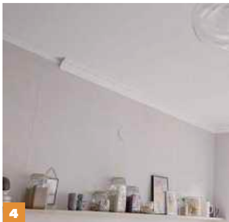
4 Dann geht es ans Anbringen der Leisten entlang der Decke . Nicht zu viel Kleber verwenden, damit nichts überquillt.
