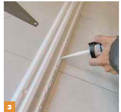
3 Die nach Plan zugeschnittenen Teile bereitet Tim mit Montagekleber für Zierprofile vor.
