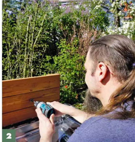
2 ... dann die Öffnung mit der Lochsäge ausführen und die Kanten versäubern.
