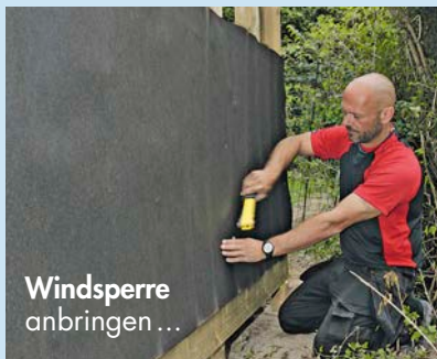
... und mit Konterleisten versehen
