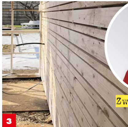
3 Die Abstandsleisten hinter der Verkleidung erleichtern die Verlegung der Kabel , ohne dass diese sichtbar sind.
