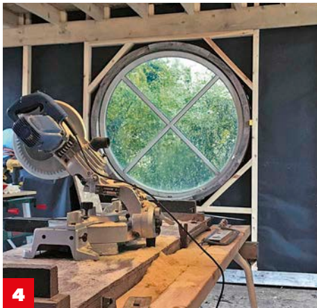
5 Das gesamte ursprüngliche Einscheibenglas wurde ersetzt und neu verkittet . Das gibt den Fenstern nicht nur eine frischere Optik, sondern macht sie auch wieder dicht.
