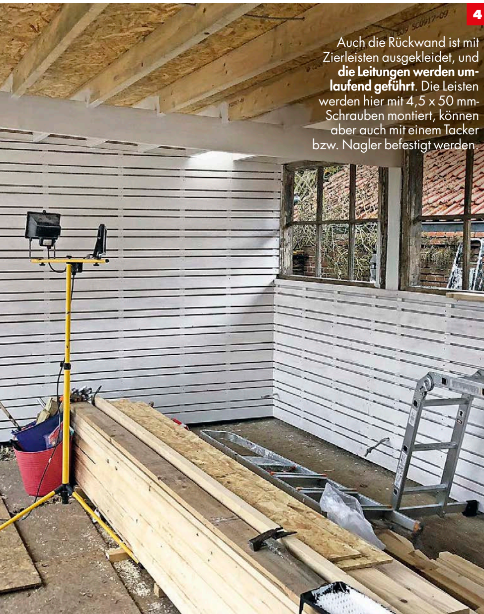
2 Die Verkleidung besteht aus gehobelten Schalungsbrettern , wobei jedes zweite in der Mitte geteilt ist . Der Abstand zwischen Leisten und Brettern beträgt ca. 8 mm.
