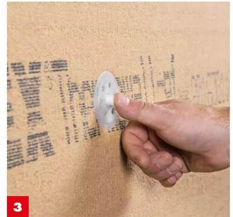
**3** Das Loch im Dübelschaft wird mit einem **EPS-Verschluss-Stopfen oberflächenbündig verschlossen**.
