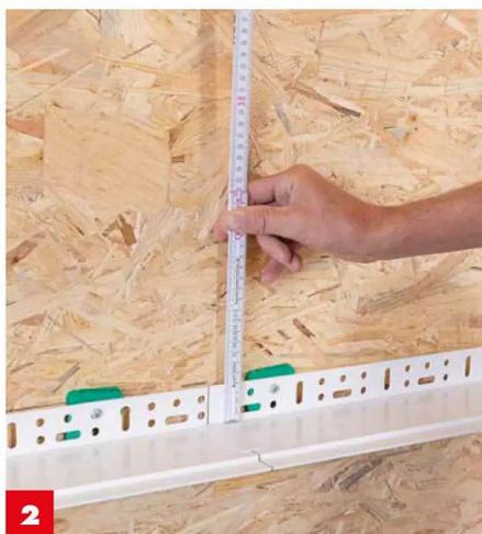
**2** Klinken Sie etwa **8 mm für das Sockelprofil** aus den Traghölzern aus. Am einfachsten geht das mit einem Akku-Hobel.
