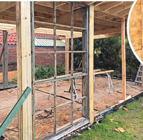
Das Einsetzen der Fenster **erfordert etwas Geduld beim Ausrichten** – und auf jeden Fall eine zweite Person, die mit anpackt
