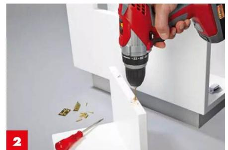
**2** Die Scharniere anhalten, anreißen und **ebenfalls vorstechen**. Anschließend mit 2 mm für die Schrauben vorbohren.
