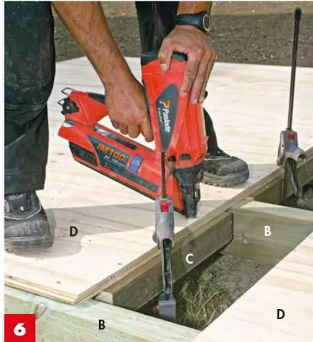
**6** Nun werden die Bodenplatten (D) per Nut und Feder auf den Balken (B) verlegt. **An den kurzen Seiten müssen sie auf einem Balken (C) aufliegen.** Mit Zwingen festklemmen und anschrauben oder -nageln.
