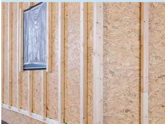
An den Ecken setzen Sie ein zusätzliches Tragh Holz so, dass dessen Außenkanten in beiden Ebenen in der Flucht liegen
