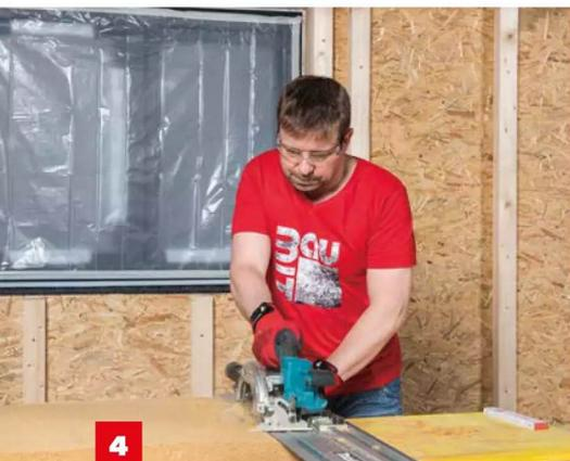
**4** Die dichteren Holzfaser-Fassadenplatten **schneiden Sie besser mit einer Handkreissäge** auf die benötigten Maße.
