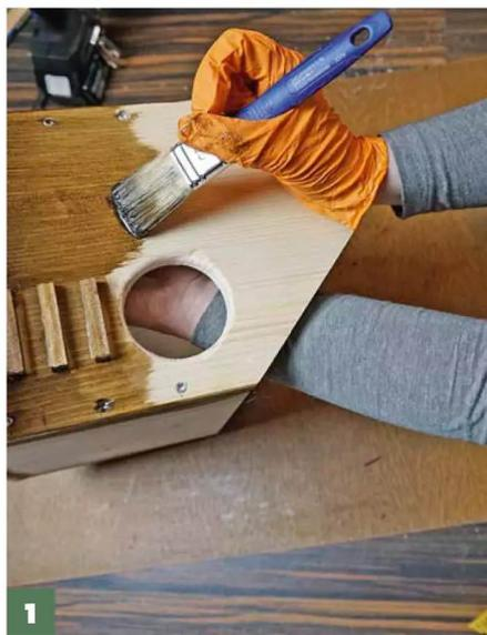
**1** Beim Streichen oder Lasieren **folgen Sie der Maserung des Holzes**. Überschüssige Lasur wird anschließend abgewischt.
