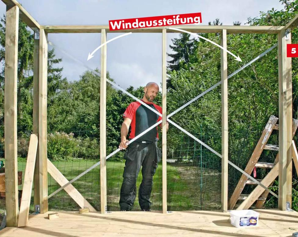
**5** Nach dem Aufbau der Wandständerwerke, aber bevor Sie die Windsperre anbringen, **installieren Sie die Kreuzstreben: Befestigen Sie dafür an zwei der Fassadenaußenseiten Lochbänder.** So sind sie nicht im Weg, falls Sie innen isolieren möchten. Spannen Sie die Windsicherung, indem Sie das Lochband einige Zentimeter vom Pfosten entfernt halten und dann eine Schraube eindrehen. Sobald das Band straff gezogen ist, eine zweite Schraube auf die übliche Weise eindrehen, um die Spannung zu halten.
