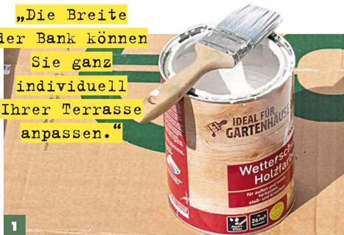
Zuerst die Leisten für den Unterbau, die Beine und die Bretter für die Sitzfläche **auf die gewünschten Maße sägen**, die Kanten glatt schleifen und alle Teile **mit Wetterschutzfarbe streichen**.
