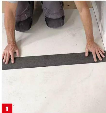
**1** Vor dem Mörtelauftrag einen Streifen **Dachpappe auslegen** (evtl. mit Silikon fixieren) – als Feuchtigkeitsschutz für den Boden.
