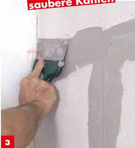
3 Wenn die Grundierung trocken ist, **Fugen, Löcher und Beschädigungen** gründlich ausbessern, damit die Oberfläche eben wird.
