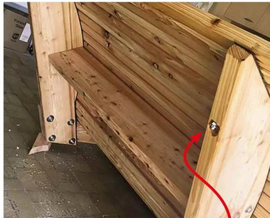
Die Gewindestange zur Befestigung der **vier Ösenmuttern für die Aufhängung** läuft zwecks Stabilität jeweils durch die gesamte Wange
