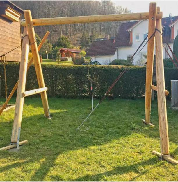
Das Gestell wurde **in einbetonierte H-Anker montiert**, damit es stabil steht und keinen direkten Kontakt mit dem Erdreich hat
