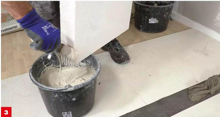
**3** Den ersten Stein unten anfeuchten und das Mörtelbett vorbereiten. Dann **Kleber auf die Fläche der ersten Platte auftragen**, die der Wand zugewandt ist, an die angeschlossen wird. Die Klebekelle wird dabei in einem Winkel von etwa 45° gehalten.
