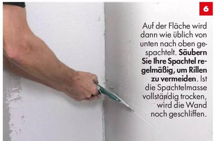
6 Auf der Fläche wird dann wie üblich von unten nach oben gespachtelt. **Säubern Sie Ihre Spachtel regelmäßig, um Rillen zu vermeiden**. Ist die Spachtelmasse vollständig trocken, wird die Wand noch geschliffen.
