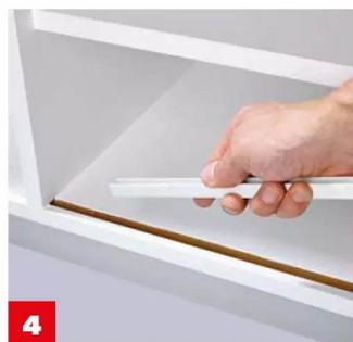
**4** **Schiene für die Tür** in die Bodennut einsetzen. Die obere Nut ist tiefer, für leichten Einbau der Tür.
