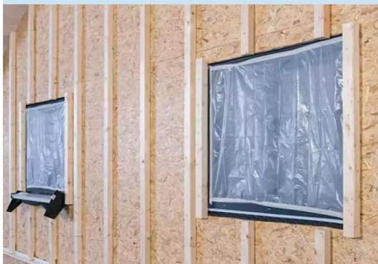
Bei den Wandöffnungen lassen Sie Traghölzer bis Ober- und Unterkante laufen und setzen zusätzliche Hölzer seitlich direkt daneben
