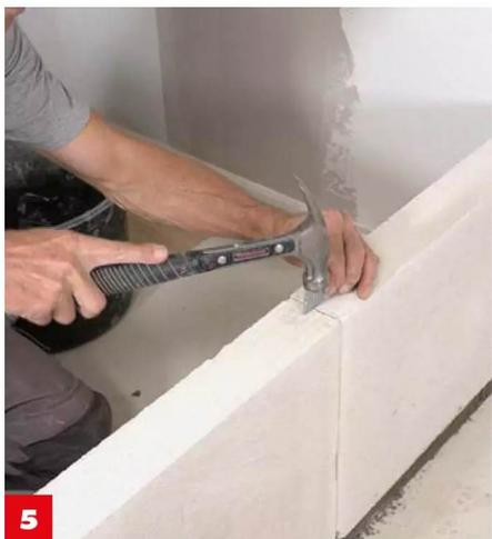
**5** Bauen Sie die nächsten Platten mit Mörtel und Kleber an, nivellieren Sie sie und **sichern Sie die Stöße mit Wellennägeln**.
