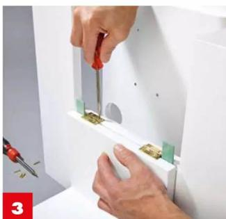
**3** Deckel des Klappfachs mit **dünnen Hölzern (2-3 mm) ausrichten**. Scharniere anschrauben.
