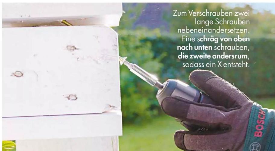
Zum Verschrauben zwei lange Schrauben nebeneinandersetzen. Eine **schräg von oben nach unten** schrauben, die **zweite andersrum**, sodass ein X entsteht.
