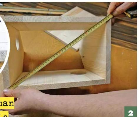
2 Nun die beiden **Diagonalen messen**, um sicherzustellen, dass der **Korpus rechteckig** ist. Sie müssen identische Längen aufweisen.
