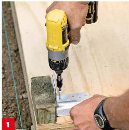
**1** Markieren Sie auf dem Boden, wo die vertikalen Pfosten (F) stehen sollen. **Ein Pfostenstumpf hilft beim Positionieren. Schrauben Sie dann die Winkel an.** Beim Türausschnitt auf jeder Seite 1,5 cm Luft lassen.
