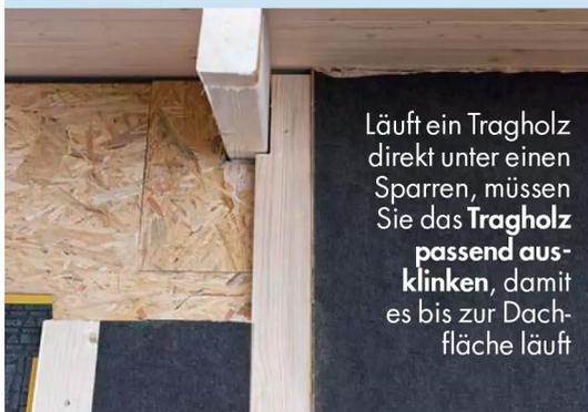
Läuft ein Tragh Holz direkt unter einen Sparren, müssen Sie das Tragh Holz passend ausklinken, damit es bis zur Dachfläche läuft
