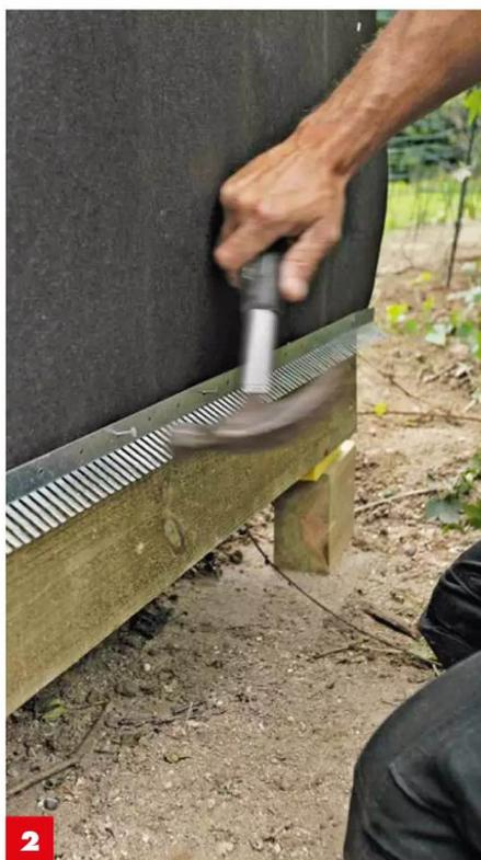
**2** So halten Sie die Mäuse fern: Befestigen Sie am unteren Ende der Fassade **ein Mäusegitter bündig an der Oberkante des Bodenbalkens** – genauso auf Spannung bringen wie die Kreuzstreben.
