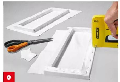
**9** Die Rahmen für die seitlichen Lautsprecherabteile mit **Akustikstoff einschlagen** und mit Tackerklammern fixieren.
