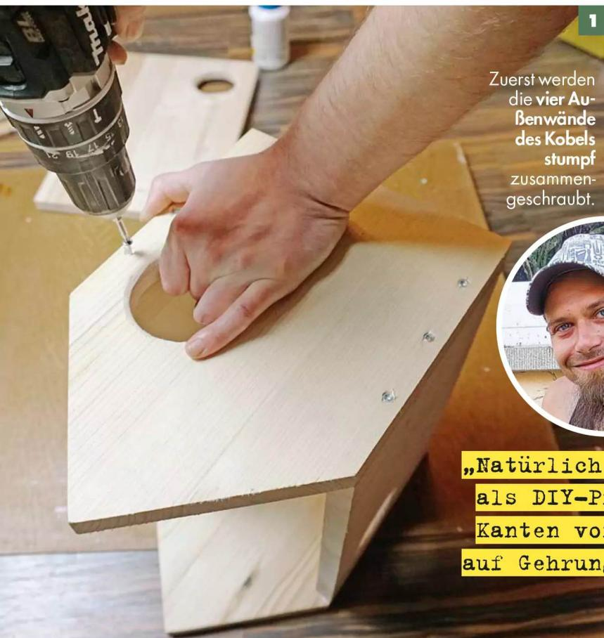
1 Zuerst werden die **vier Außenwände des Kobels stumpf** zusammengeschraubt.
