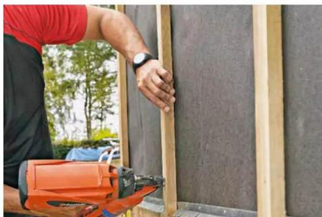
Zwischen den Streben bleibt **Raum für eine Dämmung**, um das Haus zu isolieren
