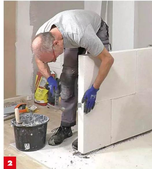
**2** Frei stehende **Wandenden mit Wellennägeln sichern**: Die Verbindner werden sorgsam mit einem Hammer eingeschlagen.
