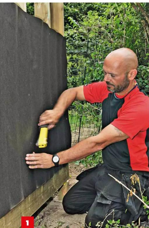
**1** Bringen Sie nun an allen Wänden mit einem Hammer- oder Handtacker winddichte Pappe an. **Die Streifen müssen dabei um 20 cm überlappen** – auch die oberste, schmalere Bahn.
