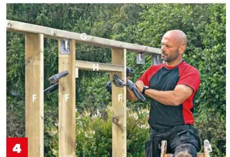
**4** Nun den horizontalen Sturz (H) in den Türausschnitt schrauben. **Der Türrahmen wird auf 2-mm-Klötzchen auf den Boden gestellt und der Sturz (H) so angeschraubt, dass beim Einbau der Tür 1,5 cm Luft bleiben.**
