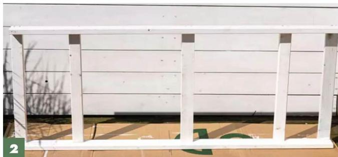
Nun den Auflagerahmen zusammenschrauben: Die **kurzen Holzleisten von außen nach innen an einer der langen Leisten anschrauben**. Anschließend die zweite lange Leiste parallel fixieren.
