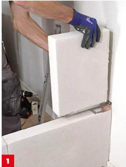
**1** Die nächsten Reihen folgen im **Läuferverband**. Sie werden mit Plattenkleber an der Wand und der Reihe darunter verklebt.
