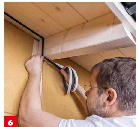
**6** Vor der Montage der Dämmplatten kleben Sie ein **Fugendichtband am Dachanschluss und den Sparren** auf.
