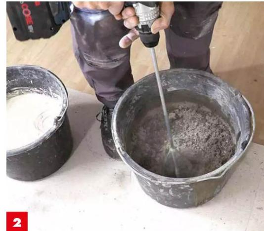
**2** Mörtel und Plattenkleber mit Bohrmaschine und Quirl **in separaten Eimern anmischen**. Erst Wasser, dann Pulver zugeben.
