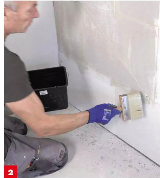
2 Porenbeton ist stark saugfähig. **Versiegeln Sie die Wand daher vor dem Spachteln** mit einem passenden Dichtmittel.
