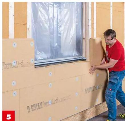
**5** Die Plattenkante **unter dem Fenster wird in einem Winkel von 5°** geschnitten, passend zur später folgenden Fensterbank.
