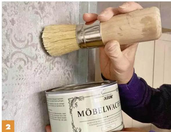
2 Grobe Unebenheiten mit 240er-Schleifpapier glatt schleifen. Mit farblosem Wachs **versiegeln**. Dunkles Wachs für Ecken und Kanten, weißes für Flächen.
