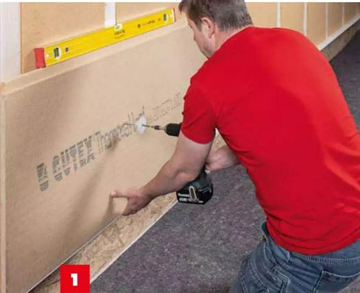
**1** Die Holzfaserplatten werden mit **Schraubdübeln mindestens 35 mm tief** in der Tragkonstruktion befestigt.
