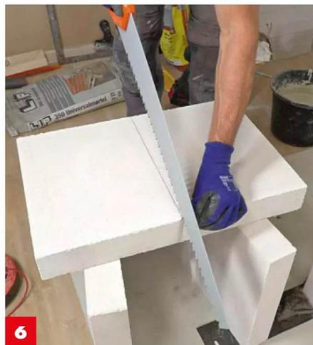
**6** Die letzte Platte der Reihe mit einem alten Fuchsschwanz oder besser **mit einer Porenbetonsäge** passend auf Maß bringen.
