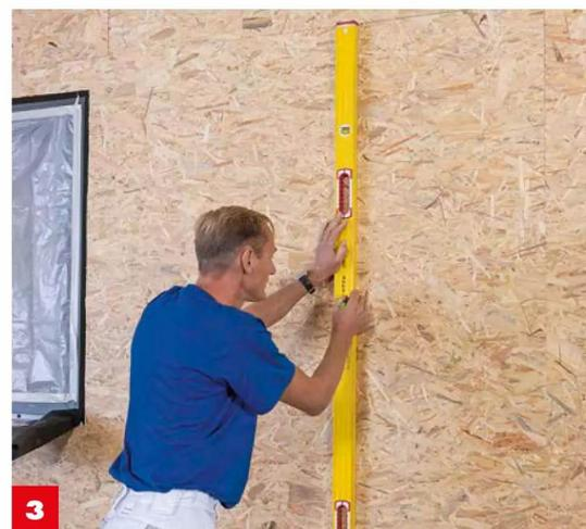
**3** Berechnen Sie den **Abstand der Traghölzer nach der Dämmstoffbreite**. Markieren Sie das erste Tragh Holz in der Mitte der Wand.
