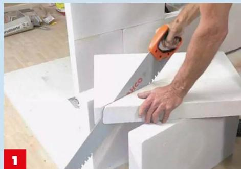
**1** Sägen Sie das Brett diagonal durch. Es **muss kein perfekter Schnitt von Ecke zu Ecke sein**, solange er schräg verläuft.
