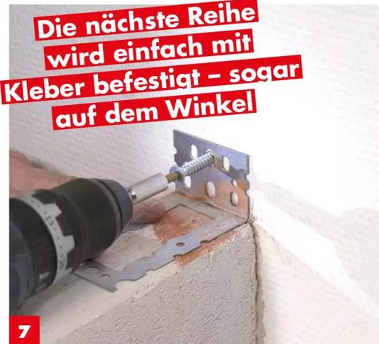
**Die nächste Reihe wird einfach mit Kleber befestigt – sogar auf dem Winkel**
