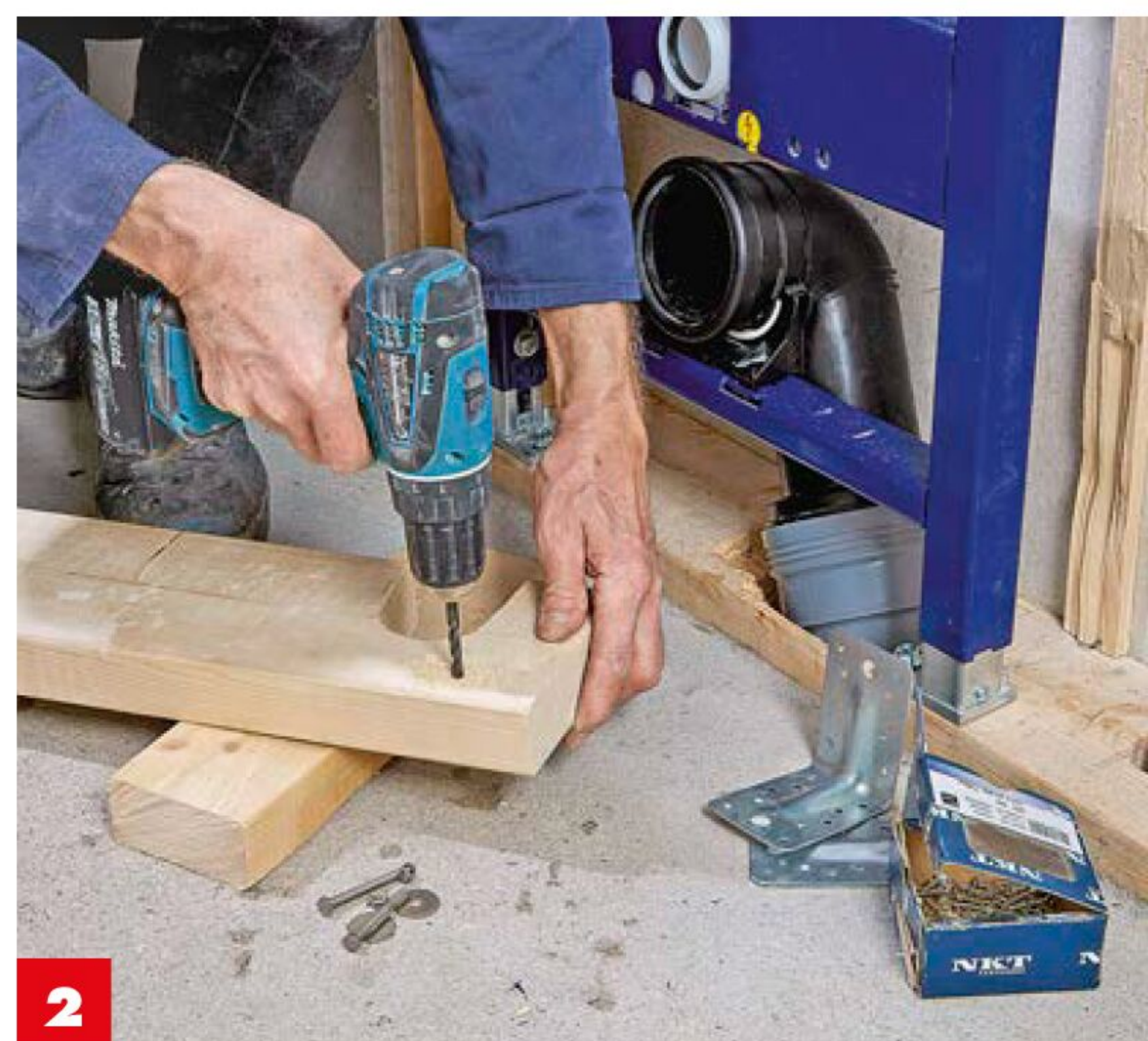
2 Bohren Sie die Bohle für die metrischen Verbindungsschrauben mit dem Vorwandelement vor.
