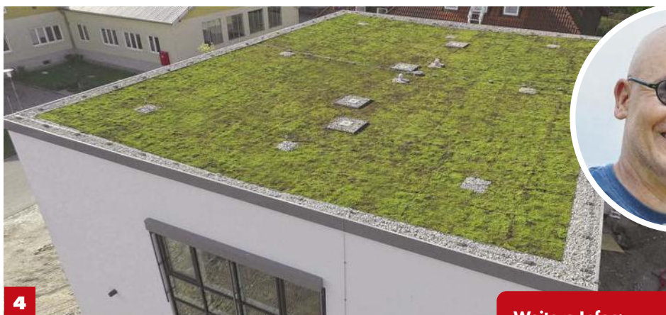
4 Brandschutztechnisch gelten Gründächer als harte Bedachung , weil sie gegen Flugfeuer und Strahlungswärme beständig sind.
