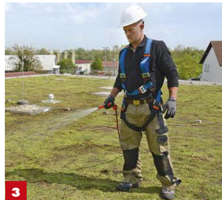
3 Das Bewässern der Fläche erfolgt so lange, bis alle Schichten mit Wasser vollgesogen sind.
