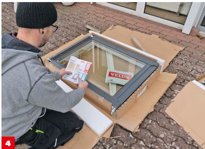
4 Das neue Dachflächenfenster auf einer großen, freien Fläche vorsichtig auspacken. Die Anleitung lesen!
