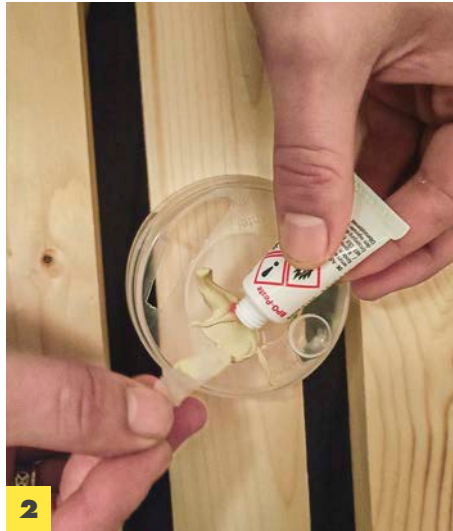
2 Größere Fehlstellen sowie Astlöcher mit Kfz-Füll-Spachtelmasse füllen. Dazu die 2K-Spachtelmasse mit Härter anrühren.
