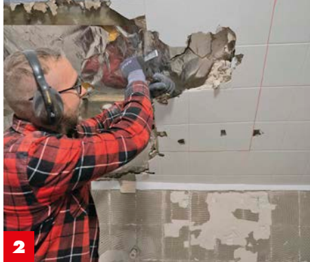
2 Jetzt wird der gewünschte Ausschnitt freigelegt. In diesem Fall wird die gesamte Dachschräge auf den Sparren freigelegt.
