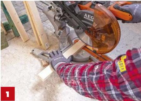
**1** Im ersten Schritt die Decke ausmessen und alle Konstruktionshölzer 48 x 24 mm mit der Säge auf Länge schneiden.
