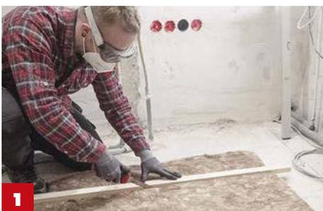
**1** Der Klemmfilz wird mit einer Dachlatte oder langen Wasserwaage und einem Dämmstoffmesser auf Maß geschnitten.
