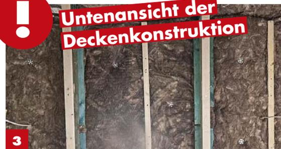
**3** Die eingepassten Klemmfilzstreifen halten von allein zwischen den Konstruktionshölzern und Dachlatten.
