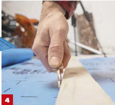
**4** Über der Dämmung wird die Dampfbremse angebracht. Sie lässt sich entlang einer Latte mit dem Messer ablängen.
