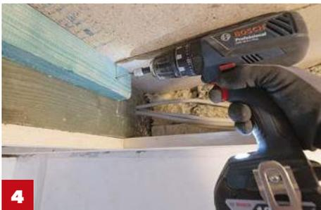
**4** Der Abstand der Balkenunterseite zur eingelassenen Decke lässt sich über die seitlich montierten Dachlatten einstellen.
