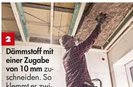
**2** Dämmstoff mit einer Zugabe von 10 mm zuschneiden. So klemmt er zwischen den Balken, wird aber nicht gestaucht.
