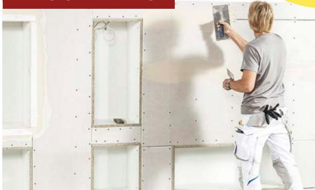
Keine Bauart für Trennwände ist so vielfältig und bietet so viele Detaillösungen wie der Trockenbau. Wir zeigen, wie Sie Nischen und Regale in Ihre Wand integrieren oder den Schallschutz zum lauten Nachbarn verbessern.
