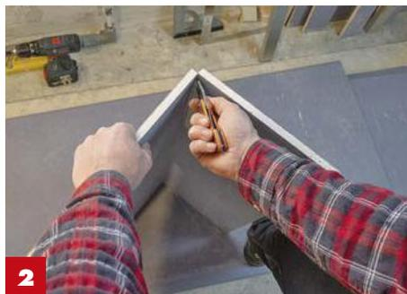
**2** ... und über eine Kante gebrochen. Abschließend muss nur noch der Karton der Rückseite geschnitten werden.
