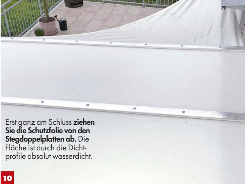
Erst ganz am Schluss **ziehen Sie die Schutzfolie von den Stegdoppelplatten ab**. Die Fläche ist durch die Dichtprofile absolut wasserdicht.
