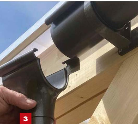
**3** Am Ende der 3-m-Rinne stecken Sie den Ablaufstutzen auf, welcher den Übergang zum Fallrohr bildet.
