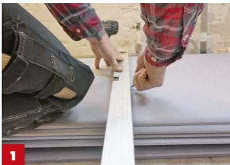
**1** Die **12,5 mm starken** Diamant-Platten werden für den Zuschnitt einfach mit dem Cutter angerissen ...
