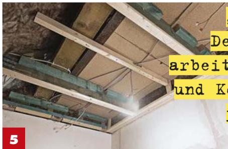
**5** Steht die Unterkonstruktion, dann kann jetzt ein Elektriker die Kabel und Anschlüsse verlegen.
