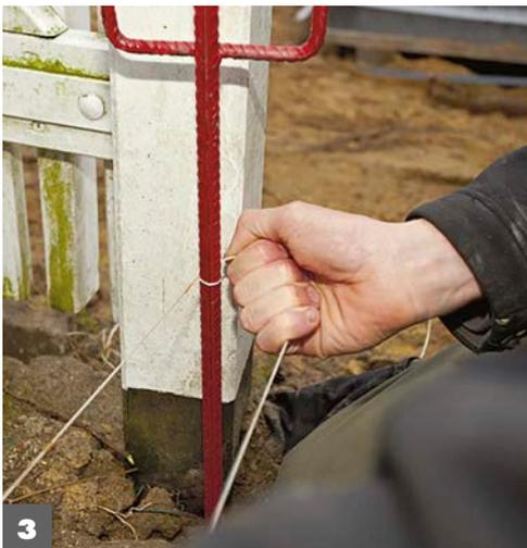
**3** **Schnur um das zweite Eisen vertäuen.** Je nach Schnurmateriale kann diese in die Haut einschneiden – tragen Sie ggf. Handschuhe.
