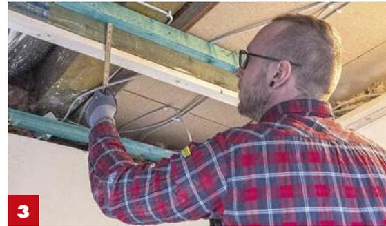
**3** Damit die Deckenbalken später aus dem Unterbau hervorragen, werden sie mit Konstruktionshölzern aufgedoppelt.
