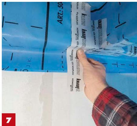
**7** Alle Stöße und Ecken und Tackerklammern sorgfältig mit dem passenden Dichtstoff **LDS Soliplan** luftdicht abkleben.
