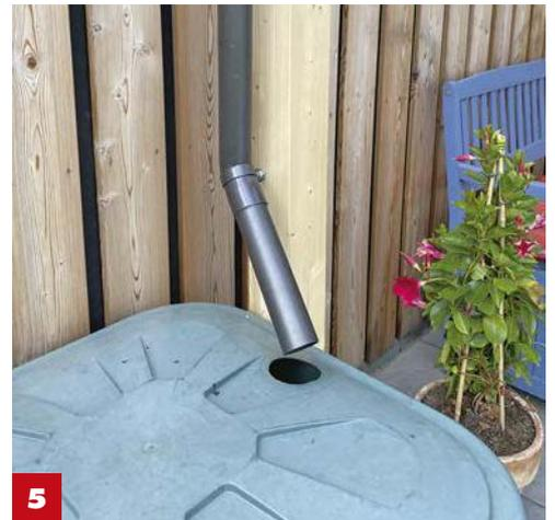
**5** Führen Sie das Fallrohr in einen Auffangbehälter, dann können Sie das Regenwasser zum Gießen benutzen.
