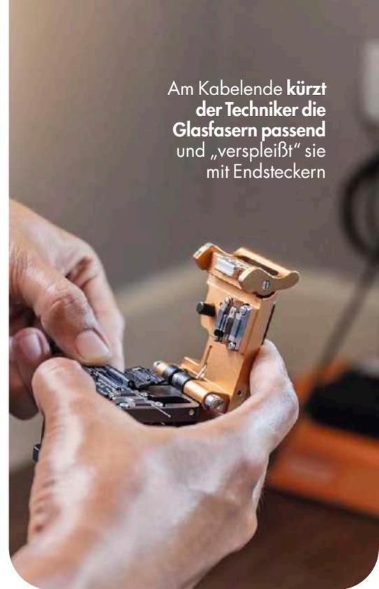
Am Kabelende **kürzt** der Techniker die Glasfasern **passend** und „verspleißt“ sie mit Endsteckern
