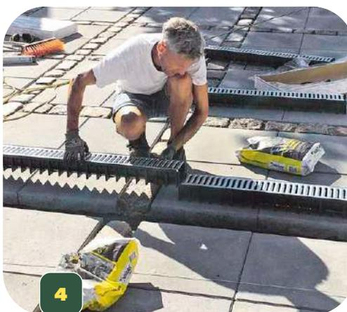
Die **Entwässerungsrinne montieren**, bevor sie in die Vertiefung gelegt wird. Sicherstellen, dass der Abfluss zum Kanal frei ist.
