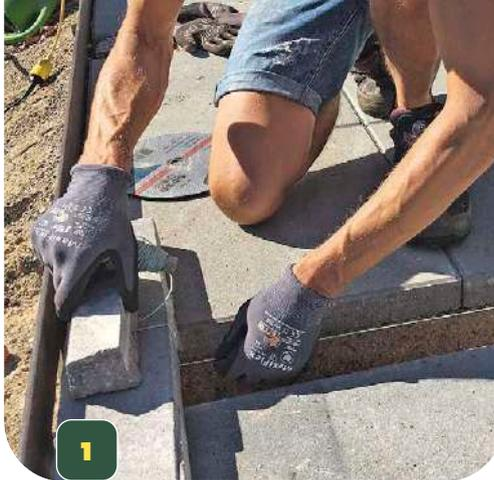
Eine Schnur ziehen, um die Höhe der Rinne (5 mm unterhalb der Platten) zu markieren. Achten Sie auf das **Gefälle zum Abfluss hin**.
