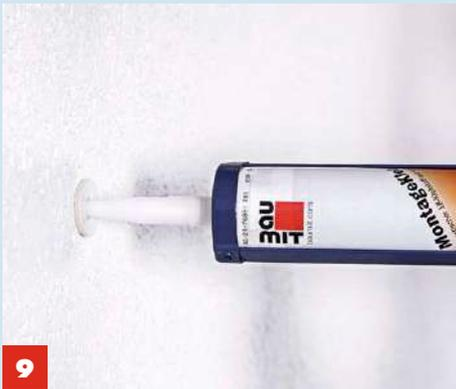
**9** Um das Eindringen von Feuchte zu verhindern, geben Sie etwas **Silikon** auf die eingedrehte Fassadenschraube.
