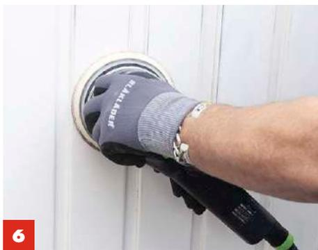
**6** Mit einem **Rotationsschleifer** wird die **Oberfläche** angeschliffen. Auch hier reicht die niedrigste Stufe.
