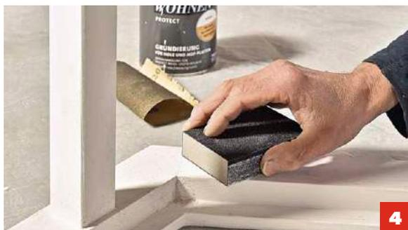
**4** Vor dem Lackanstrich mit 120er-Schleifpapier Unebenheiten und Holzfasern entfernen.
