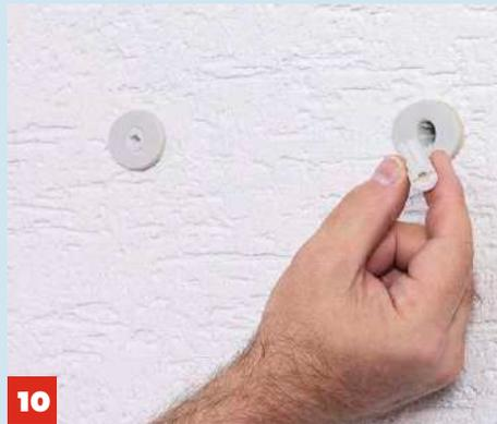
**10** Müssen Sie Schrauben von 5 oder 6 mm Durchmesser verwenden, setzen Sie eine **Reduzierhülse** in die Dübel ein.
