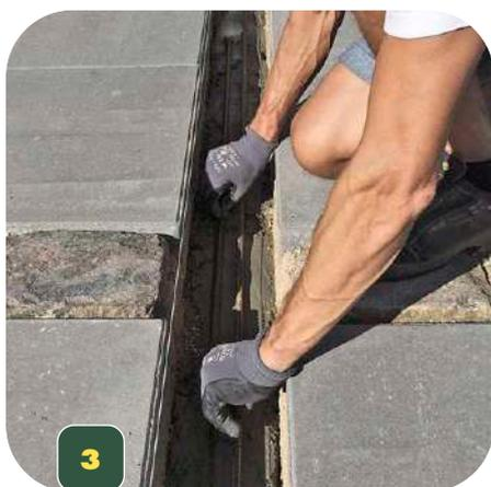
**Erdfeuchten Beton** auf den Boden der Vertiefung geben. Zwei Armierungseisen auf den Boden geben dem Fundament Festigkeit.
