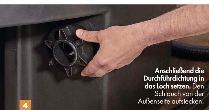
Anschließend die Durchführdichtung in das Loch setzen. Den Schlauch von der Außenseite aufstecken.
