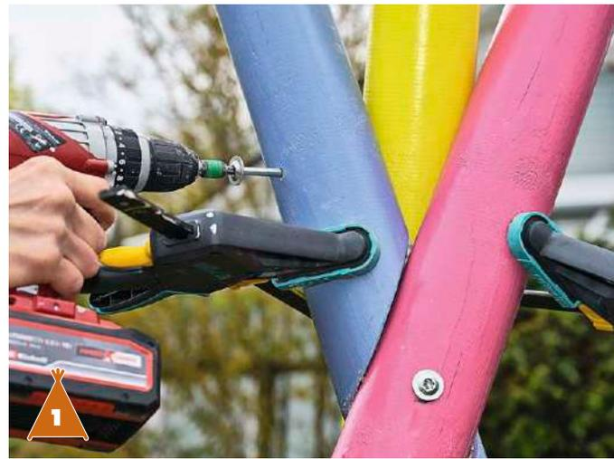
Richten Sie die Palisaden mit einer zweiten Person auf. **Montieren Sie die dritte Palisade** an zwei Stellen mit 8x180-mm-Tellerkopfschrauben. Vorbohren!
