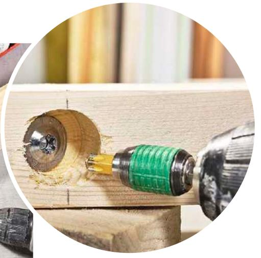
Hier sieht man gut, wie der Kopf der Tellerkopfschraube im **25-mm-Sackloch verschwindet.**
