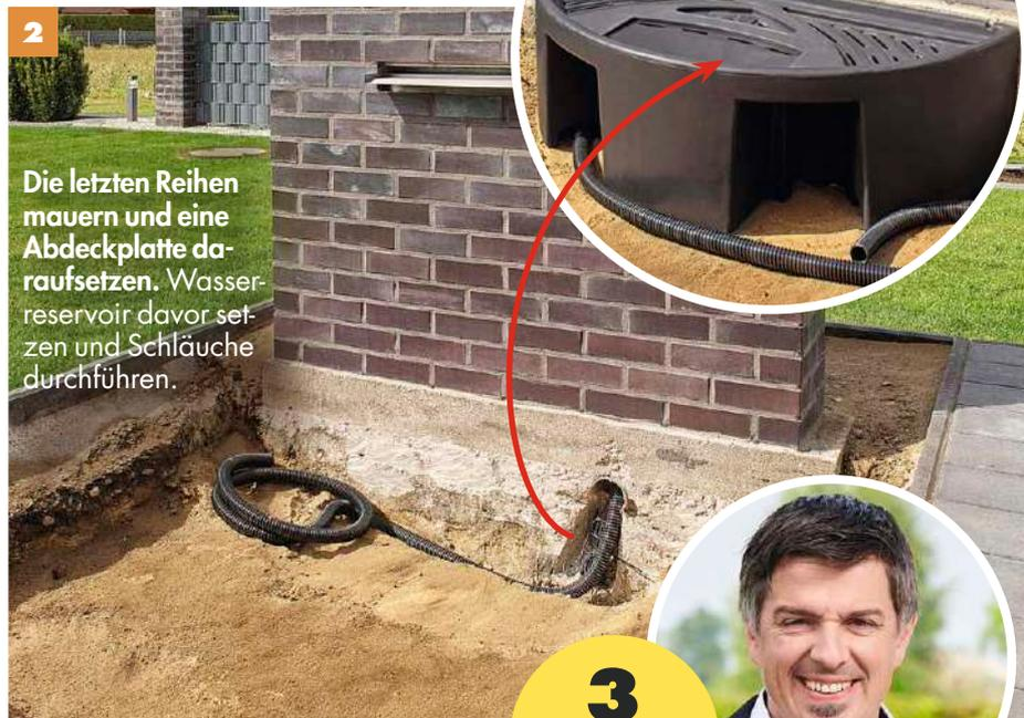
**2** Die letzten Reihen mauern und eine Abdeckplatte daraufsetzen. Wasserreservoir davor setzen und Schläuche durchführen.
