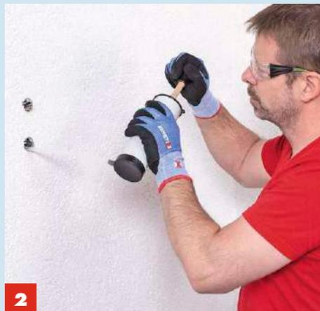
**2** Mit einer Ausblaspumpe oder einem kleinen Druckluftkompressor **reinigen Sie** die Bohrlöcher von Staub und Schmutz.
