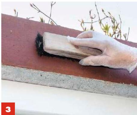
**3** Der **obere Betonkranz der Garage** soll später ebenfalls gestrichen werden. Hierzu sollten Sie den Schmutz entfernen.
