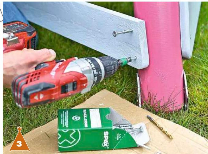
Die lackierte 1.500 x 100 x 23 mm messende **Querstrebe** mit 5x50-mm-Schrauben über den Stützschuhen an die pinke und gelbe Palisade schrauben.
