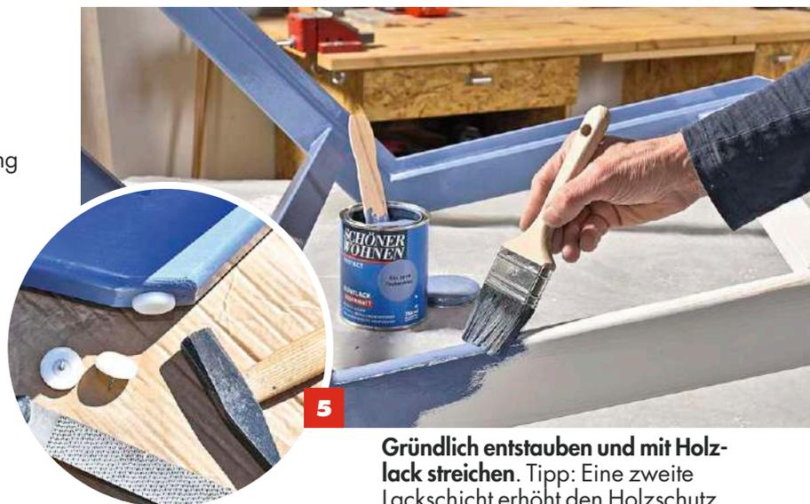
**5** Gründlich entstauben und mit Holzlack streichen. Tipp: Eine zweite Lackschicht erhöht den Holzschutz. An den vier Auflagepunkten Nagelgleiter montieren.
