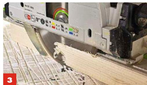
Die entsprechenden **Keile an den Leimbindern** anzeichnen und vorsichtig wegsägen. Anschlag oder Führungsschiene verwenden.
