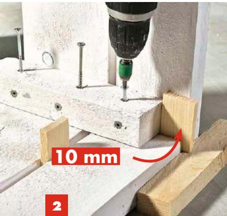
**2** Jetzt die kürzeren Dielenabschnitte mit 5 x 70 mm Schrauben montieren. Auch hier Abstandhalter verwenden.
