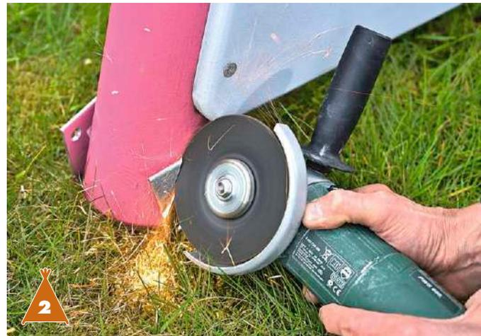
Die überstehenden Ecken an den U-Stützschuhen mit dem Winkelschleifer entfernen und sorgfältig entgraten, damit sich niemand daran verletzt.
