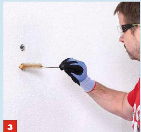
**3** Mit der Reinigungsbürste entfernen Sie **zusätzlich alle losen Teile**. Die Bohrlöcher müssen absolut sauber sein.
