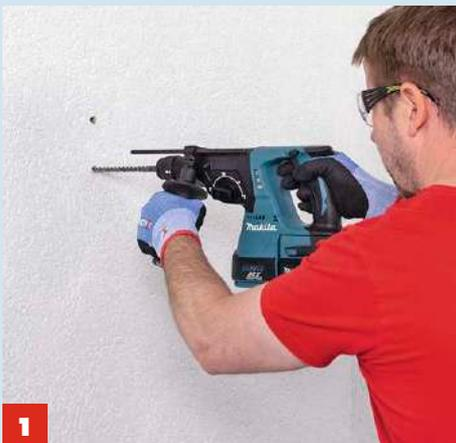
**1** Markieren Sie die Bohrlöcher und bohren Sie **zuerst mit 10 mm** vor. Bohrtiefe in der tragenden Wand mindestens 100 mm.
