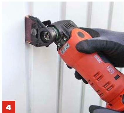
**4** Mit **180er-Schleifpapier** und einem **Multitool** werden die Sicken auf niedrigster Stufe angeschliffen.
