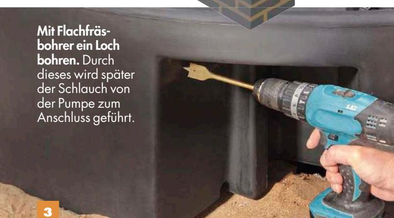
Mit Flachfräsbohrer ein Loch bohren. Durch dieses wird später der Schlauch von der Pumpe zum Anschluss geführt.
