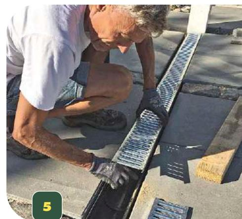
Entwässerungsrinne in die Vertiefung einsetzen. In den Beton drücken, bis die Rinne **5 mm unter der Plattenebene** liegt.
