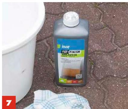
**7** Nach dem Schleifen reinigen Sie die Fläche mit **Anlager und Wasser**. Danach ist das Tor staub- und fettfrei.
