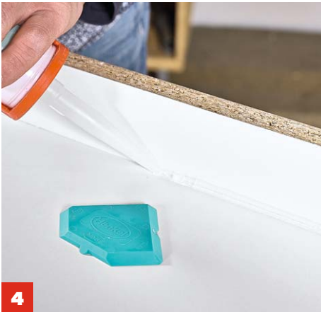
4 Mit Silikon alle Stoßfugen abdichten . Die Silikonfuge mit dem Raker in die gewünschte Form bringen.
