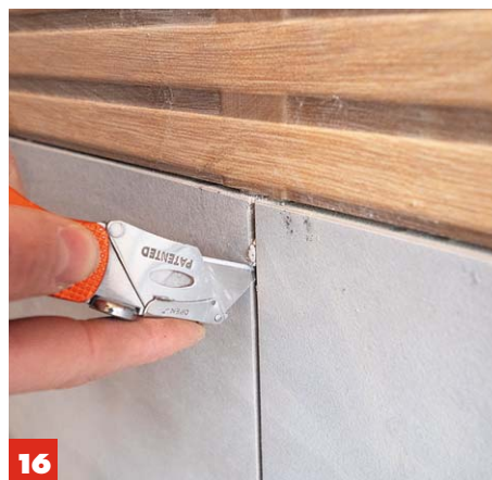
13 Verwechslungsgefahr: Was hier wie Holz aussieht, sind Keramikfliesen in Holzoptik . Fliesenkleberreste sofort entfernen.
