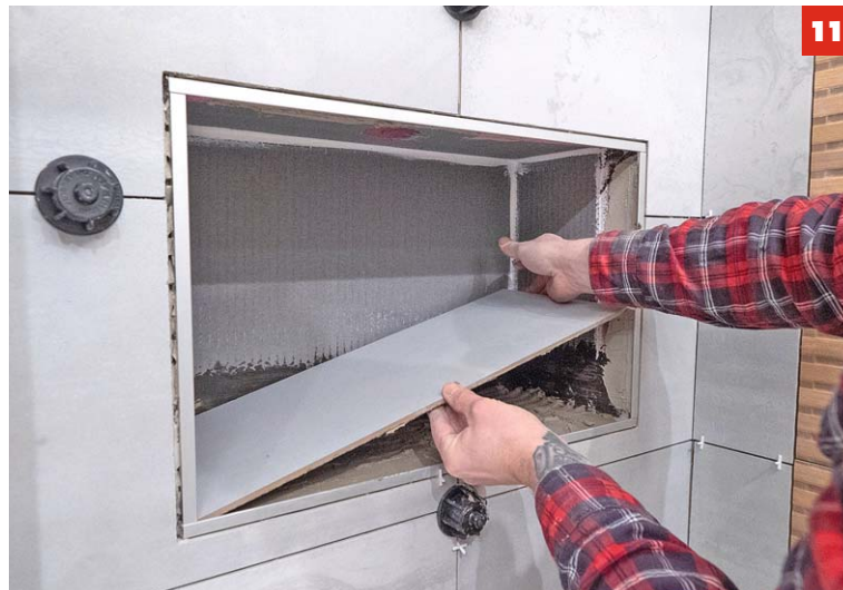
10 Für das Ablagefach in der Dusche werden Eckschienen aus Aluminium mit Fliesenkleber an die Kante geklebt.
