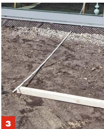
**3** Mit einer **Latte** und einem **Zollstock** den **Mittelpunkt** für den **Dachfosten** einmessen ...
