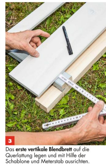
**Tipp:** Schneiden Sie die Querleisten erst nach der Montage der Blendbretter auf die passende Breite zu.
