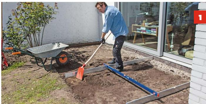
**1** Mit **Richtscheit** und einer **langen Wasserwaage** den Boden gleichmäßig ebenen.
