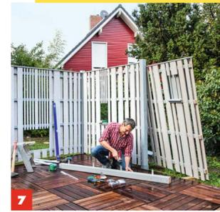
**7** Verschrauben Sie nun die Zaun-Elemente an der Querlattung mit den Flechtzaunhaltern der Pfosten.
