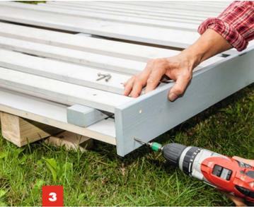
**3** Das obere Deckbrett mit 3,5 x 50 mm Edelstahlschrauben an der Oberseite der vertikalen Lattung befestigen.
