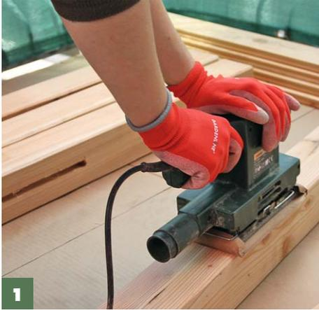
**1** Pfosten in Faserrichtung abschleifen und Harzgallen entfernen – wie, erfahren Sie in Ausgabe 8/21 von **selber machen**.
