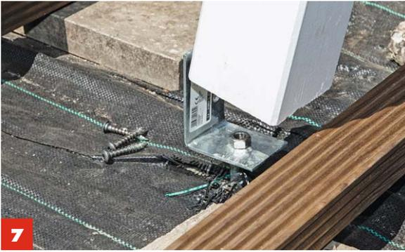
**7** Der **Pfosten** wird **auf dem Stützwinkel befestigt**. Eine untergelegte **Edelstahlmutter** schützt ihn vor Nässe.
