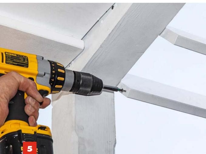
**5** Zum Verstellen der Lamellen wird je eine Edelstahlschraube (4x 25 mm) in die Unterkante der ersten Lamellen geschraubt.
