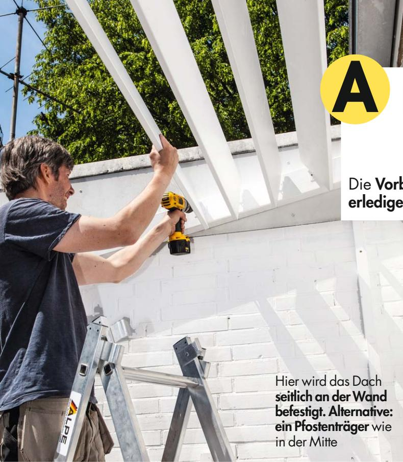
Hier wird das Dach seitlich an der Wand befestigt. Alternative: ein Pfostenträger wie in der Mitte
