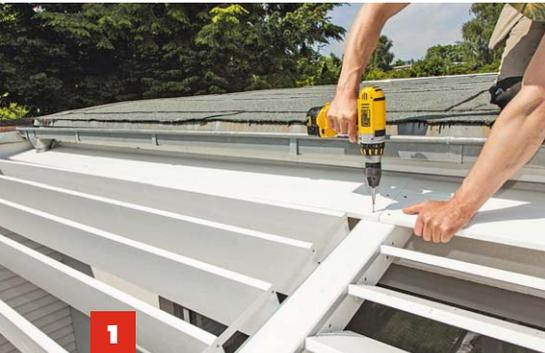
Direkt am Haus verhindern **Dachüberstand und Regenfallrohr** die Beweglichkeit der Lamellen. Lösung: eine feste Blende.
