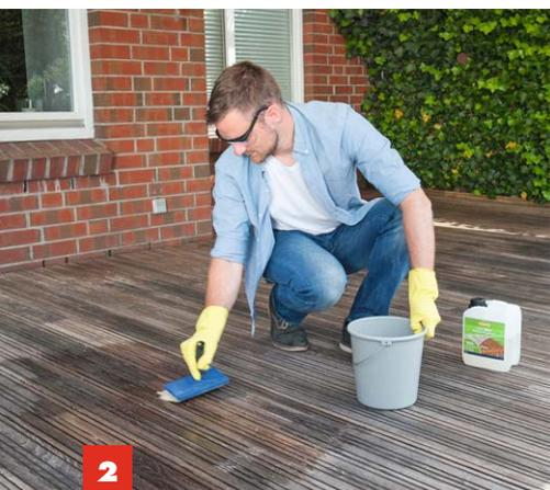
**2** Nach dem Trocknen wird der Holzton aufgefrischt: **Entgrauer** dünn mit dem Pinsel auftragen und einwirken lassen.
