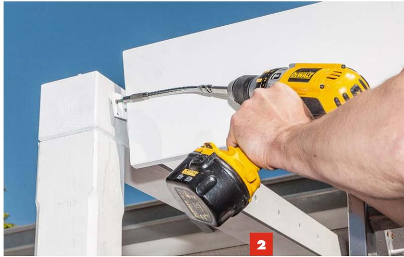
**2** Zuerst die beiden vorderen Lamellen mit der flexiblen Welle (siehe Kasten links) festschrauben. Jetzt steht der Pfosten stabil.
