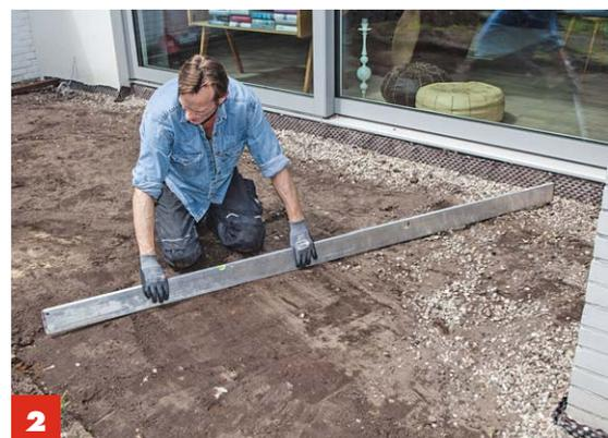
**2** Boden mit **Richtscheit** und **Wasserwaage** mit **2 % Gefälle vom Haus weg** (Blase stößt gegen die Markierung der Wasserwaagenlibelle) **glatt abziehen**, ggf. weiter mit Erde auffüllen.
