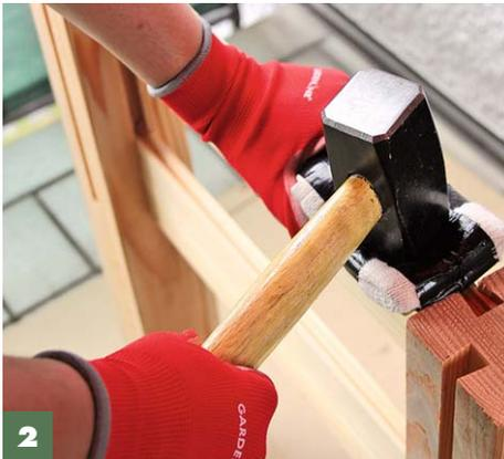
**2** Seitenbretter in die Pfostennut treiben. Wer keinen Gummihammer besitzt, kann dicken Stoff zum Polstern unterlegen.
