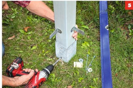
**5** Stecken Sie die Pfosten ein und richten Sie sie aus. 10-mm-Löcher vorbohren und mit je 2 Schlossschrauben befestigen.
