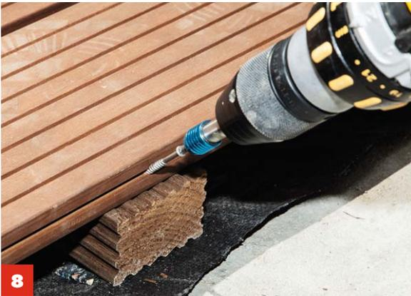
**8** Die **letzte Dielenreihe** wird ohne Plastikclip schräg durch die Nut an der Unterkonstruktion verschraubt.
