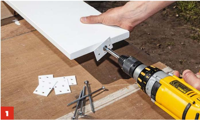
**1** 120-mm-Tellerkopfschrauben durch das Mittelloch der „Lagerplatten“ mittig in die Stirnkanten der Lamellen schrauben.
