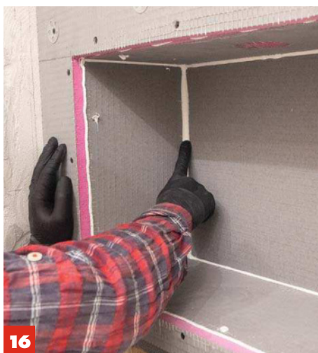
16 Die Ecken im Inneren des Fachs und die Schraubenlöcher werden zusätzlich mit Board-Fix verklebt und abgedichtet .
