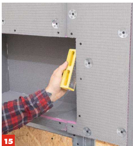
15 Sollten noch Kanten überstehen, können diese ganz leicht mit dem Gipskarton-hobel plan gehobelt werden.
