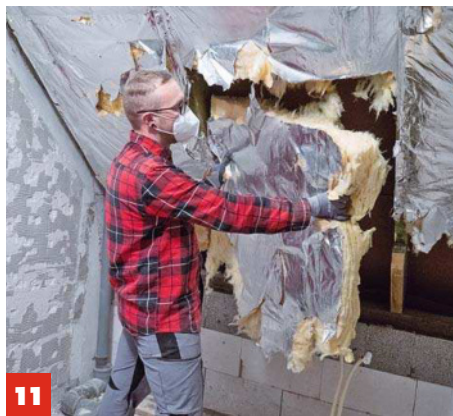
11 Auch Drempe, Dachschräge und Zwischendecke sollen neu gestaltet werden. Dazu entfernen wir die alte Dämmung .
