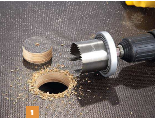
1 In der Mitte der Siebdruckplatte mit der Lochsäge eine kreisrunde Aussparung zum Einsetzen des Rohrs herstellen .
