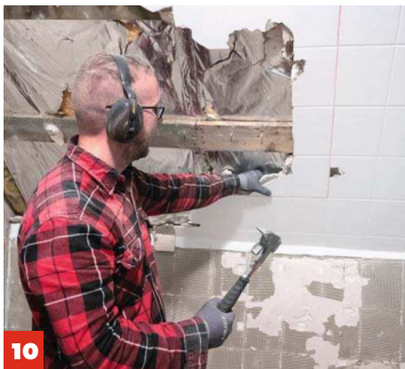
10 Da ein Fenster in die Dachschräge eingesetzt werden soll, reißen wir nun die Fliesen mitsamt Gipskartonplatte ab .
