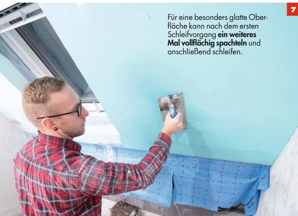
4 Masse mit der Kelle rühren und damit im ersten Gang alle Schraubenköpfe, Fugen und Kanten spachteln und abziehen .
