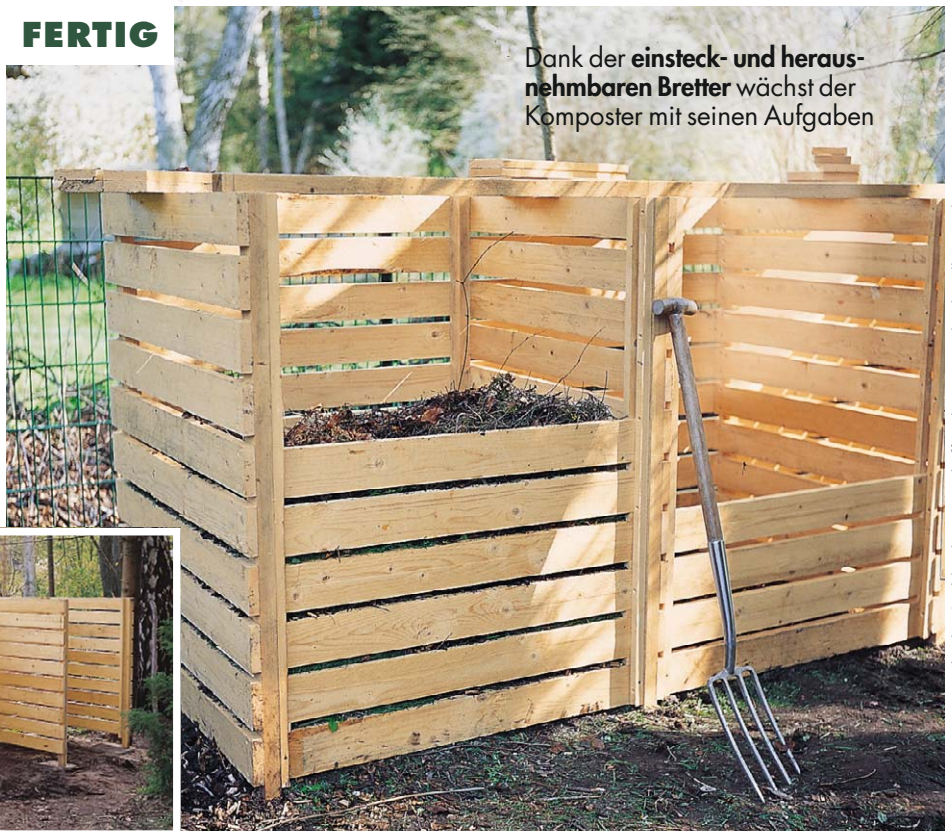
2 Zur Stabilität die Seitenteile mit quer aufgeschraubtem Kantholz verbinden. So werden sie nicht zur Seite gedrückt.
