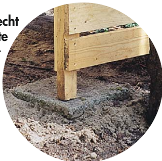
1 Die Rückwand aller Kammern besteht aus durchgehenden Latten. Die Führungsleisten der Trennwände aufschrauben.
