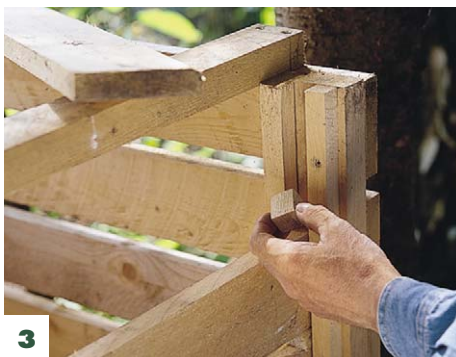
3 Die Bretter darf man nicht auf Stoß in die Führungsleisten stecken. Kleine eingesetzte Zwischenstücke geben genug Abstand.
