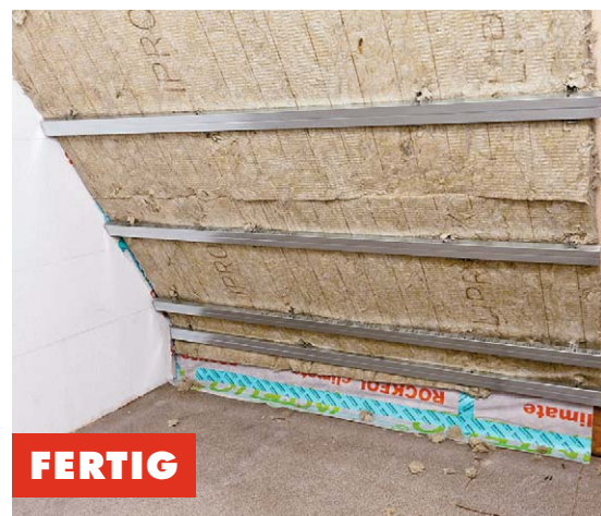
Der zusätzliche Arbeitsschritt lässt Wärmebrücken verschwinden und steigert die Dämmleistung wesentlich
