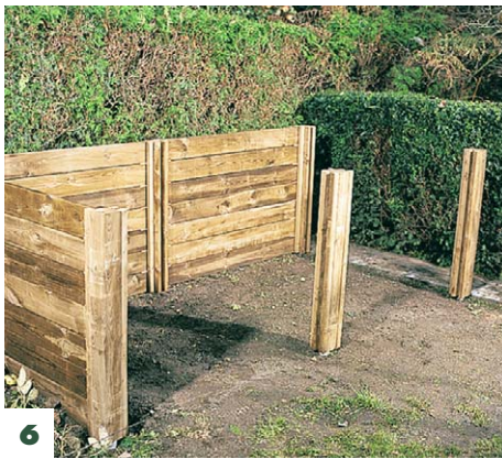
6 Als Erstes die Rückwand und die Seiten des Komposters einschieben . Darauf folgen die Mittelwand, zuletzt die Fronten.
