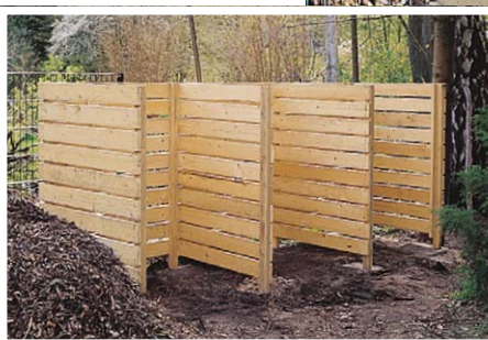
3 Die Bretter darf man nicht auf Stoß in die Führungsleisten stecken. Kleine eingesetzte Zwischenstücke geben genug Abstand.
