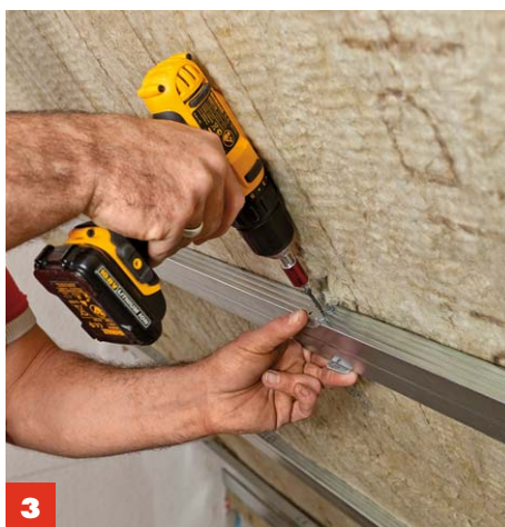
3 Die Trockenbauprofile werden anschließend wie gehabt an den Abhängern fixiert und halten die Dämmmatten.
