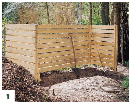
1 Die Rückwand aller Kammern besteht aus durchgehenden Latten. Die Führungsleisten der Trennwände aufschrauben.
