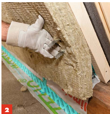
2 Die Dämmmatten werden von den Direktabhängern durchstochen und so fixiert. Nicht mit dem Messer nachhelfen!
