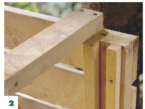
2 Zur Stabilität die Seitenteile mit quer aufgeschraubtem Kantholz verbinden. So werden sie nicht zur Seite gedrückt.
